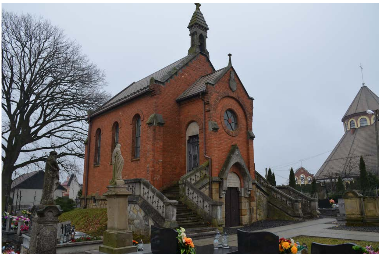
Fot. nr 3,4. Kaplica grobowa Rodziny Korczak. Widoczne na fotografii widok ogólny kaplicy. Fot. Mariusz Wrona
