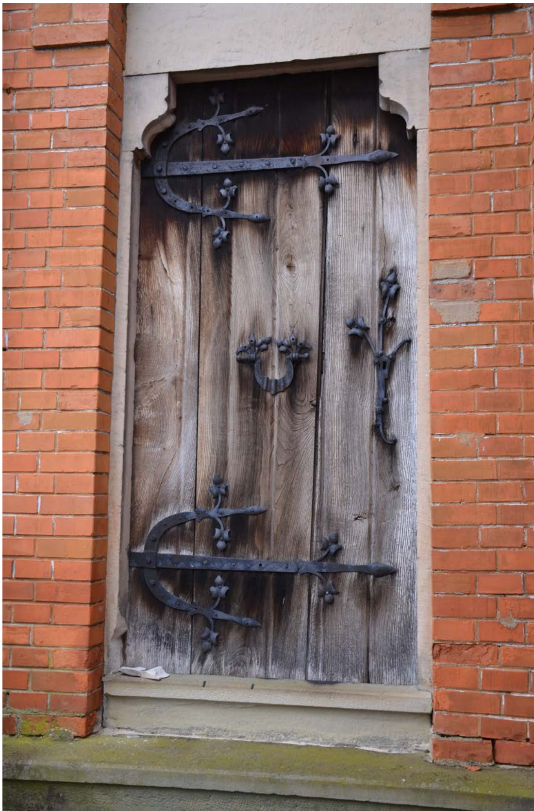
Fot. nr 12. Kaplica grobowa Rodziny Korczak. Widoczne na fotografii drzwi wejściowe do zasadniczej części kaplicy. Korozja elementów stalowych oraz elementów drewnianych.
