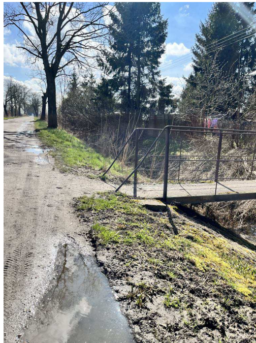
zdj. istniejące bariery przy kładkach nad rowem
