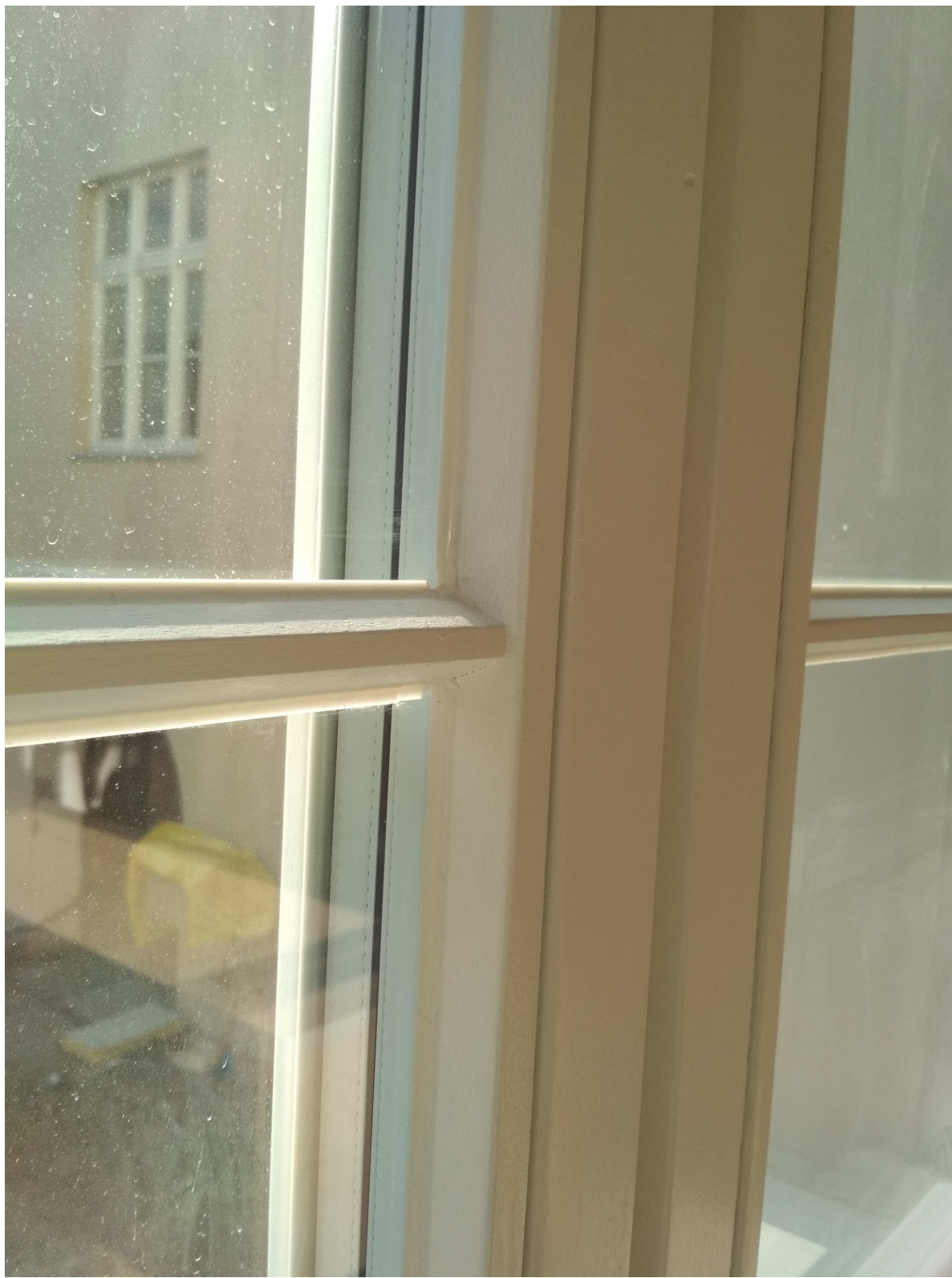
Fotografia nr 1: Sposób osadzenia szprosu naszybowego
