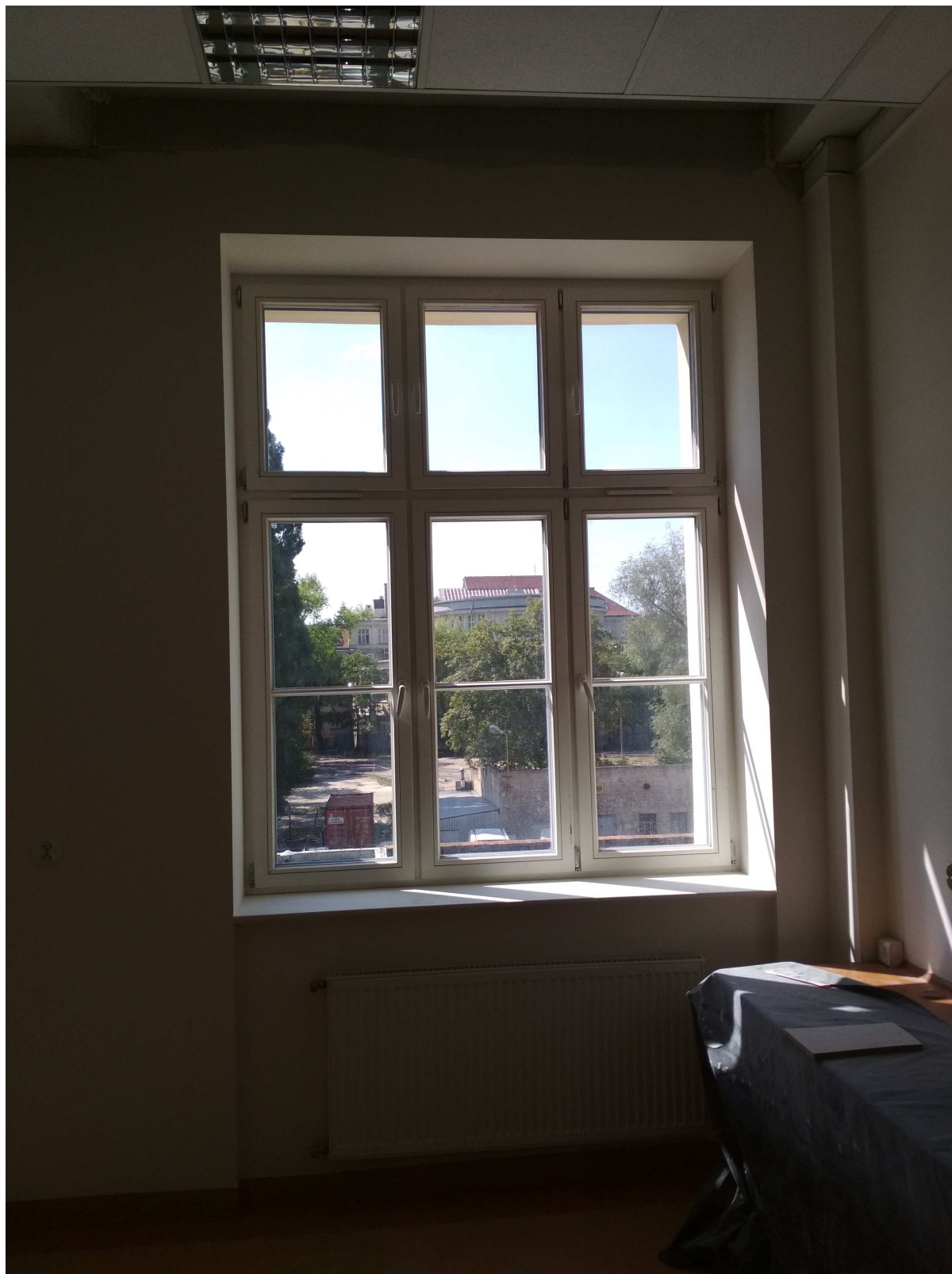
Fotografia nr 4: Widok na okno typu „T3”
