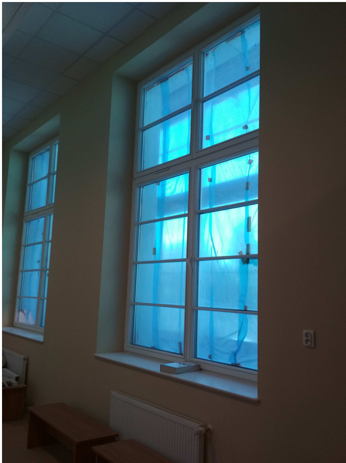
Fotografia nr 3: Widok na okno typu „T2”
