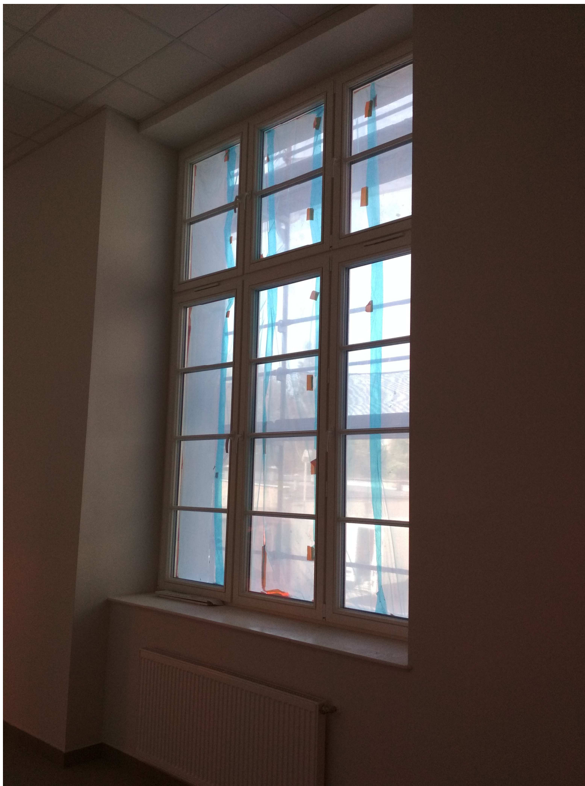
Fotografia nr 2: Widok na okno typu „T1”
