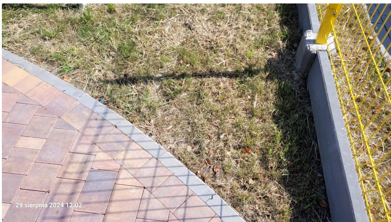
FOT.4 Ułożenie nowej kostki w nawiązaniu do istniejącej nawierzchni i fragmentu ogrodzenia.
