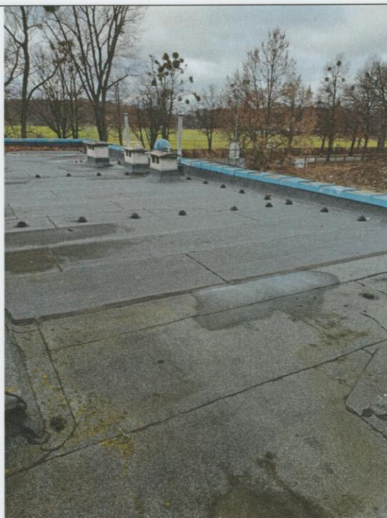
Miejsce naprawy części niższego dachu.
