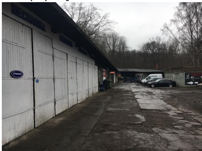
Zdj. 1 Budynek warsztatowy - przeznaczony do rozbiórki
