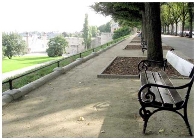
Fot. 1 Nawierzchnia przepuszczalna, mineralna.
