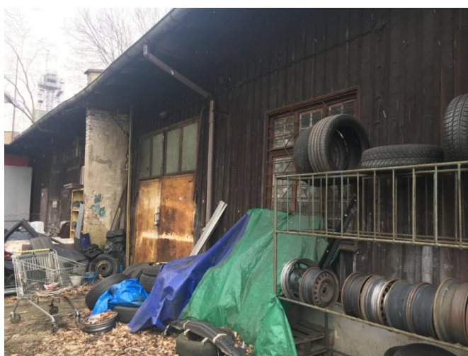
Zdj. 2 Budynek warsztatowy - elewacja wschodnia
