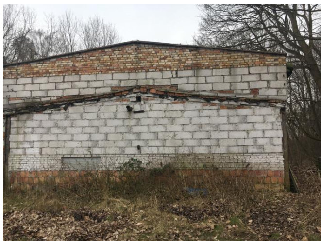
Zdj. 3 Budynek warsztatowy - elewacja północno-wschodnia
