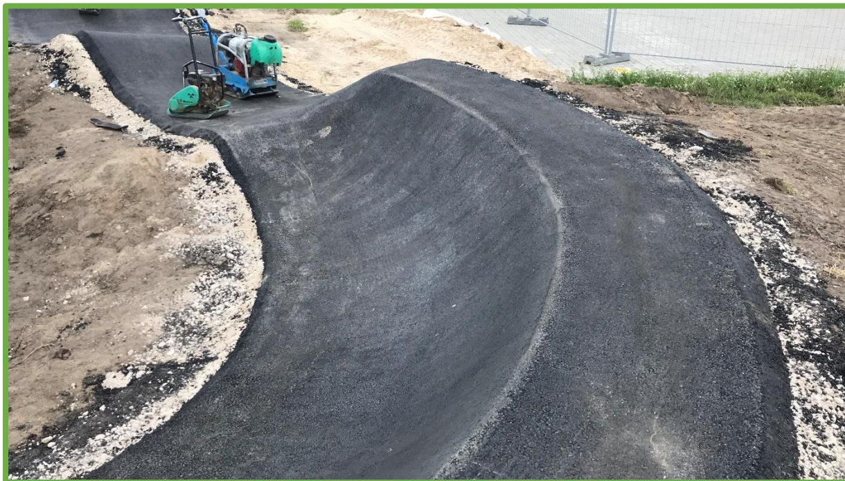
Prawidłowo wykonana nawierzchnia asfaltowa – jednorodna i gładka.
