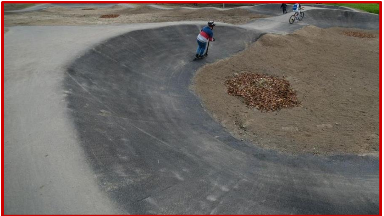
Nieprawidłowo wykonany zakręt o niejednostajnym promieniu, bez wypłaszczonej dolnej półki oraz niebędący w przekroju wycinkiem koła.
