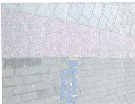
Kostka brukowa na styku z pasami z płyt granitu bordowego.
