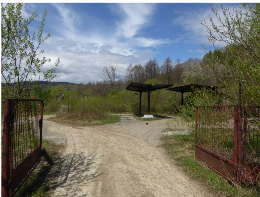
4. Brama wjazdowa i drogi asfaltowe na stacji paliw.
