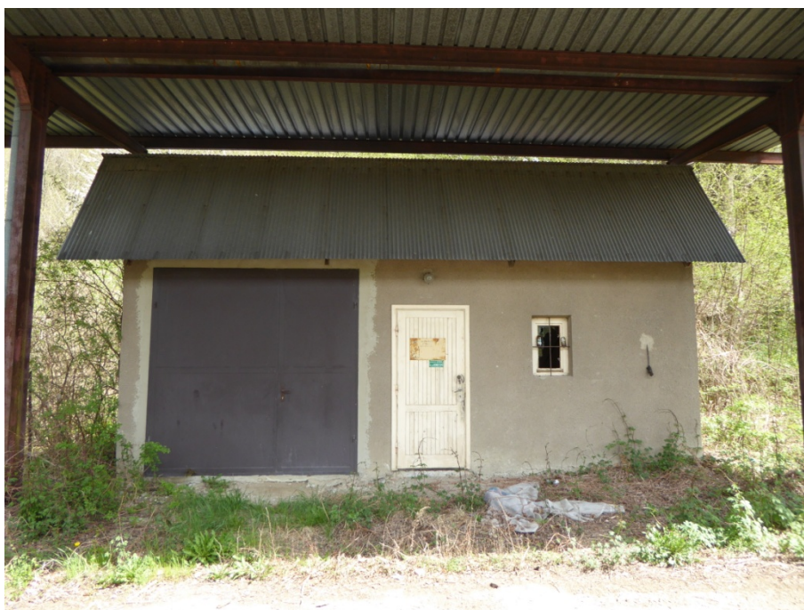
1. Budynek obsługi z jedną z wiat przeznaczonych do rozbiórki.
