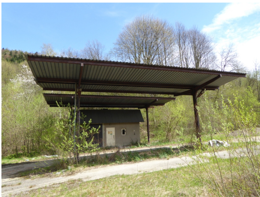
2. Dwie wiaty oraz budynek obsługi przeznaczone do rozbiórki.
