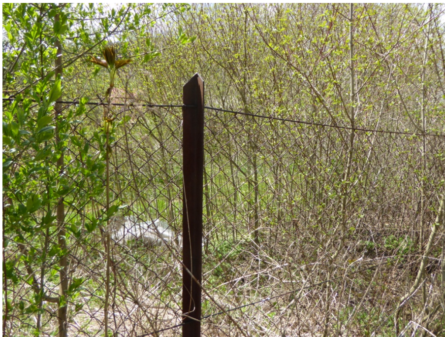
5.Ogrodzenie stacji paliw przeznaczone do rozbiórki.
