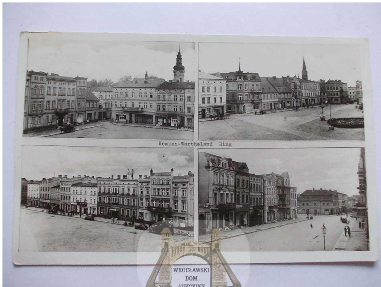
Fot.1 Zdjęcie archiwalne kamienicy przy ul. Rynek 41
