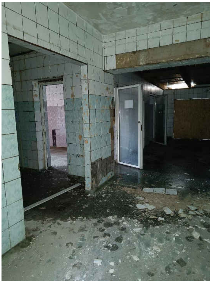
nr 9 część produkcyjna obiektu
