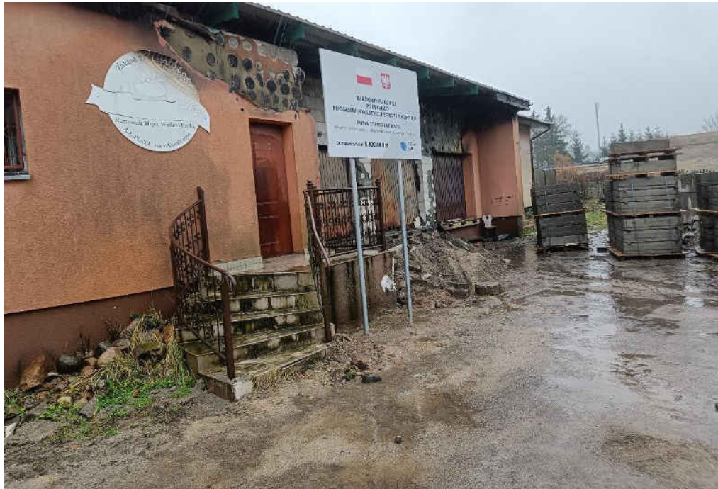
nr 3 elewacja północno - zachodnia
