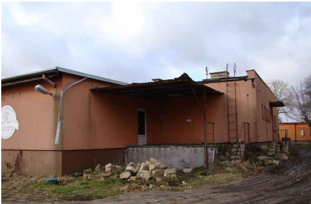
nr 2 elewacja północno - wschodnia
