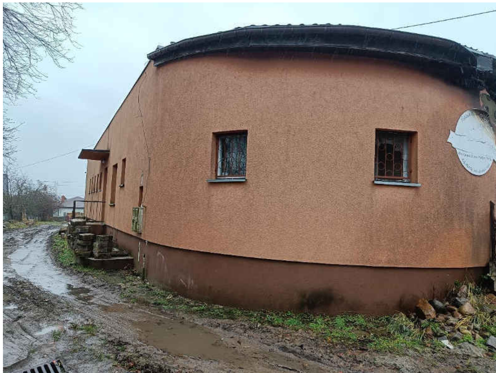
nr 4 elewacja północno - wschodnia
