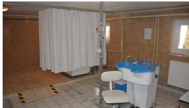
Fotografia 7: Części hydroterapii - odsłonięte rury, prowizorycznie poprowadzony włącznik (źródło: materiał własny).
