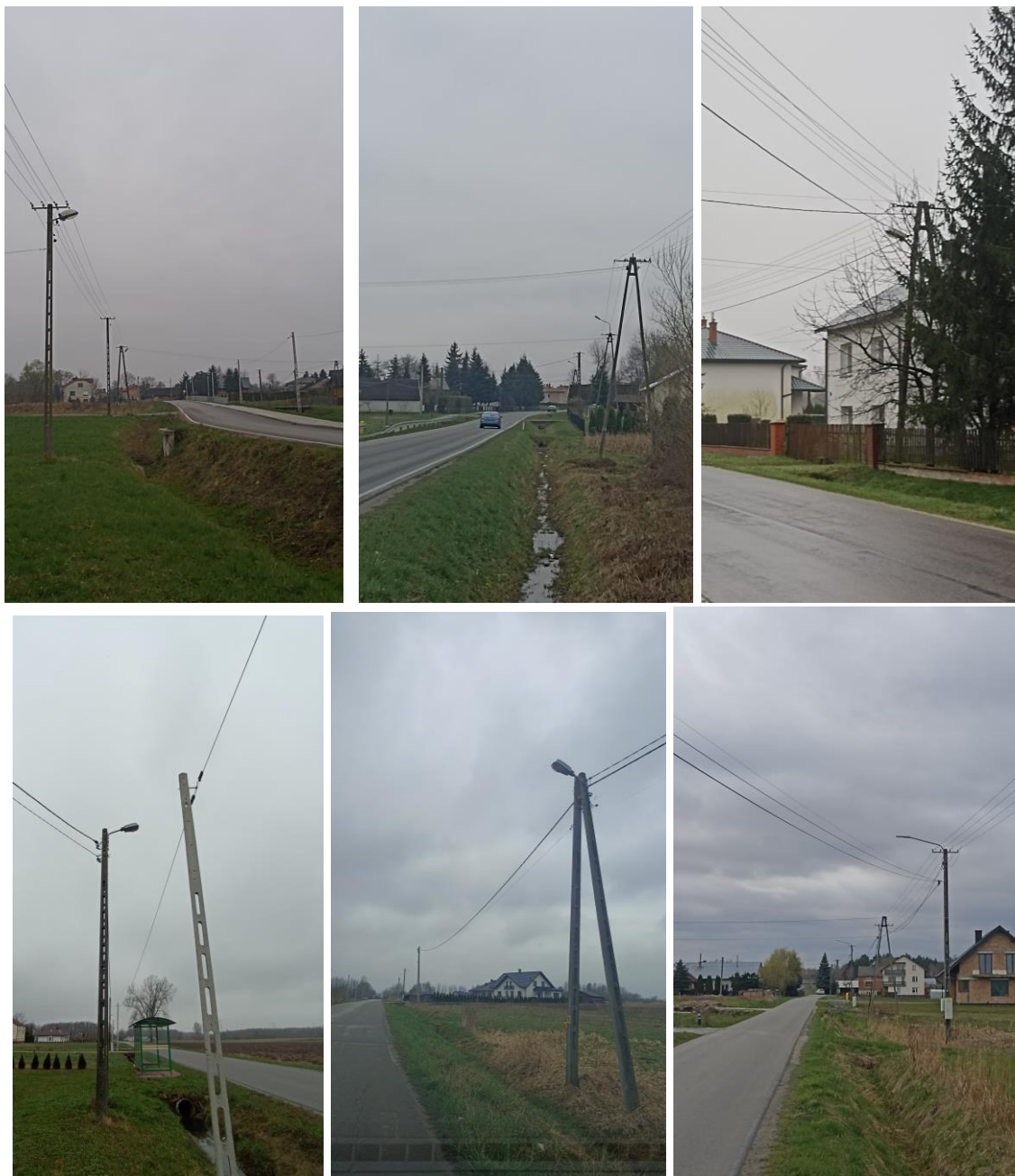
Rys.37. Ilustracja jednostronnego sposobu rozmieszczenia słupów oświetleniowych na odcinkach dróg i ulic
