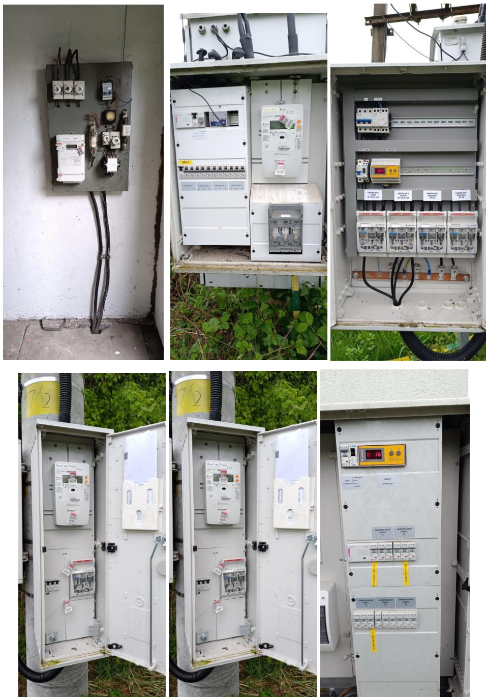
Rys.36. Zabezpieczenia występujące w szafach oświetleniowych
