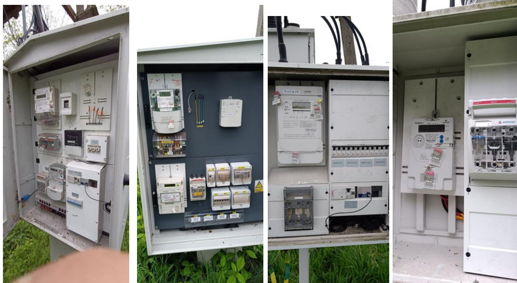
Rys.35. Przykłady styczników oraz zegarów występujących w szafach oświetleniowych
