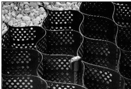
Rys. 7. Ułożona i wypełniona geosiatka komórkowa a) Geosiatka po ułożeniu, b) Geosiatka przymocowana do podłoża kotwami i częściowo zasypiana, c) Geosiatka całkowicie zasypiana kruszywem
