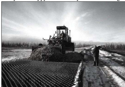
Rys. 8. Zasypywanie kruszywem komórek geosiatki za pomocą ładowarki
