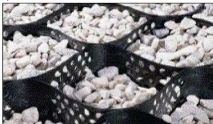
Rys. 8. Zasypywanie kruszywem komórek geosiatki za pomocą ładowarki
