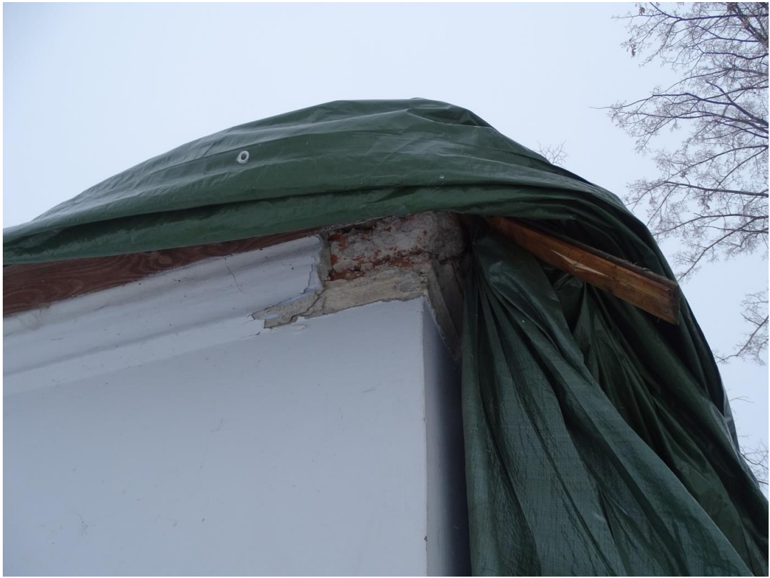
Fot.[8] Widoczne uszkodzenie gzymsu przeznaczone do odtworzenia. Fot. autor.
