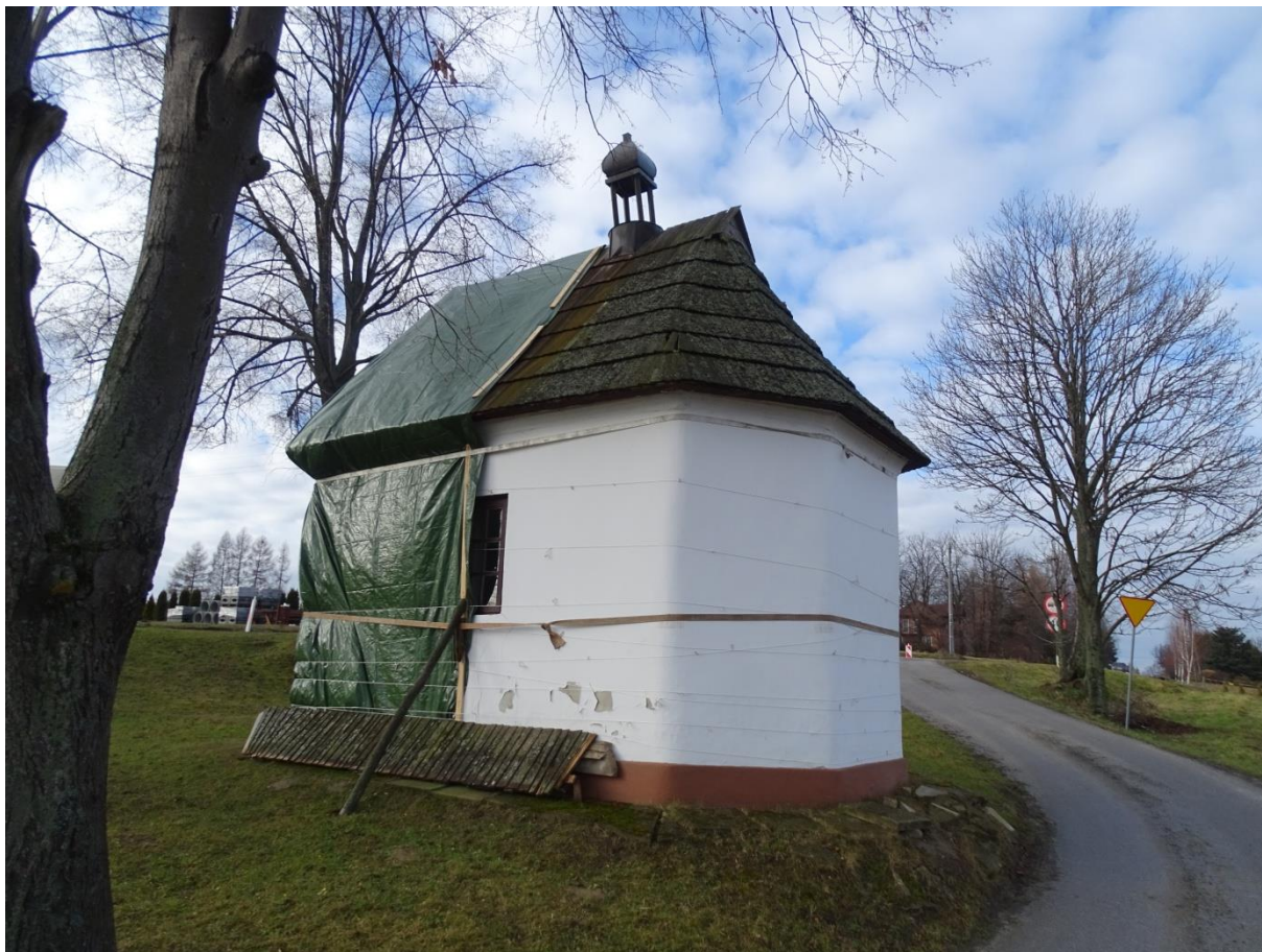
Fot.[3] Wygląd elewacji południowo – wschodniej. Widoczne rozległe obecności porostów na połaci dachowej, złuszczenia powłok malarskich oraz uszkodzenie opaski wokół ścian obiektu. Fot. autor.
