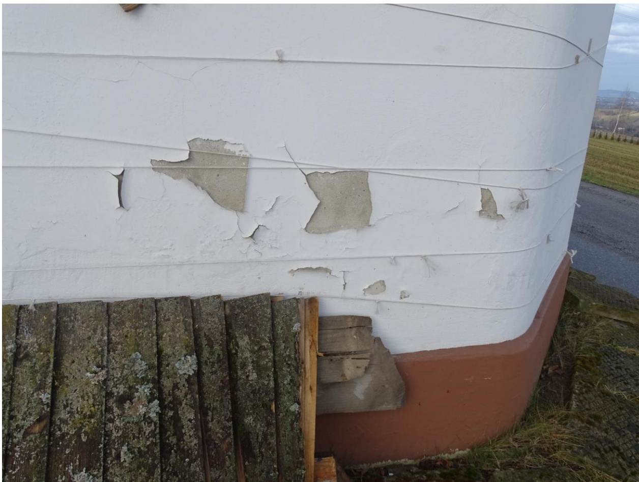
Fot. 8. Zniszczenie elewacji zewnętrznej. Fot. autor.
