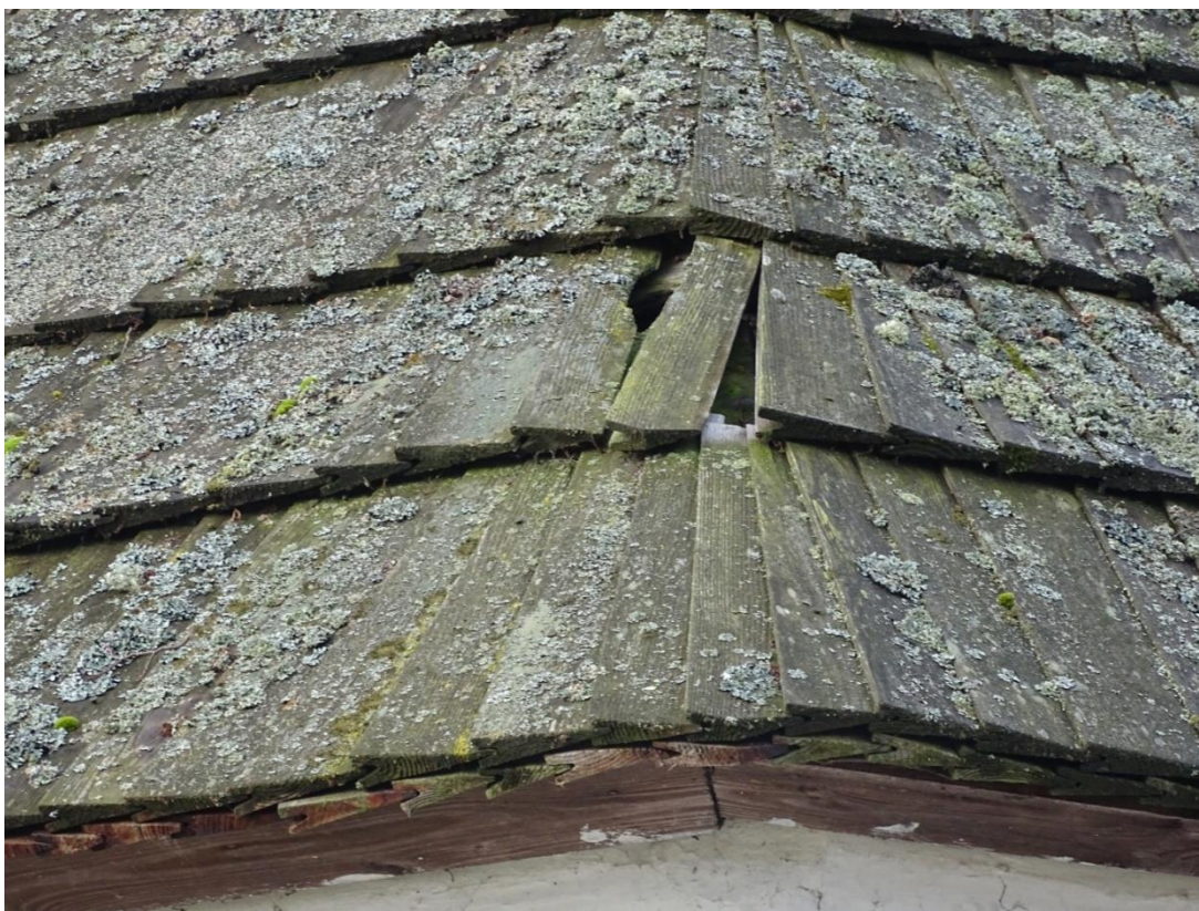
Fot.[6] Widoczne ubytki w pokryciu dachu z gontu. Fot. autor.
