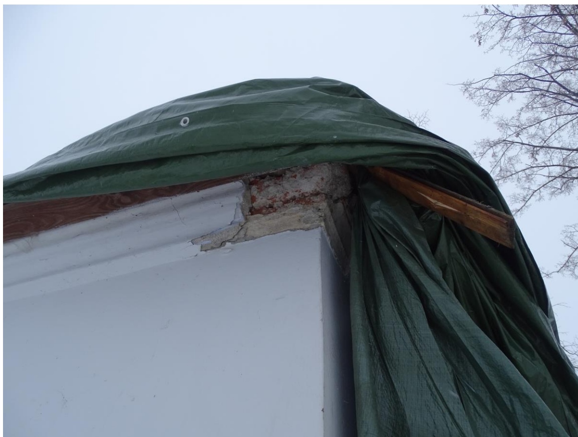
Fot. 7. Widoczne zniszczenie gzymsu. Fot. autor.
