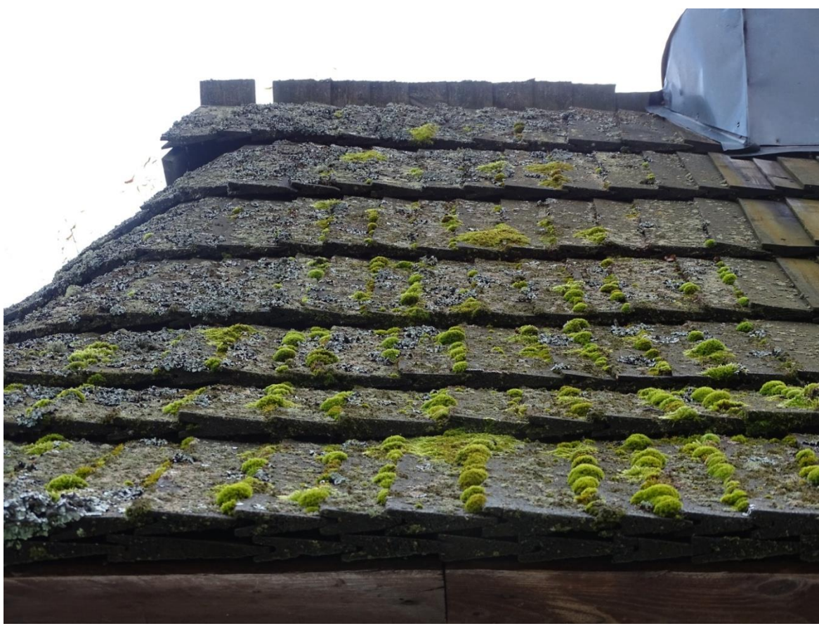
Fot.[5] Pokrycie dachu z widocznym rozległym atakiem mchów i porostów. Fot. autor.
