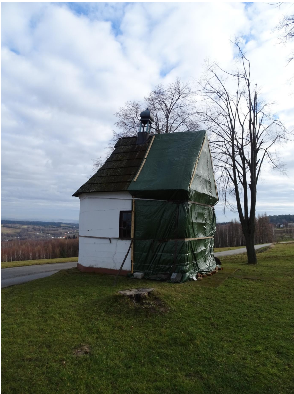
Fot.[2] Kapliczka po uszkodzeniu przez uderzenie upadającego drzewa.
