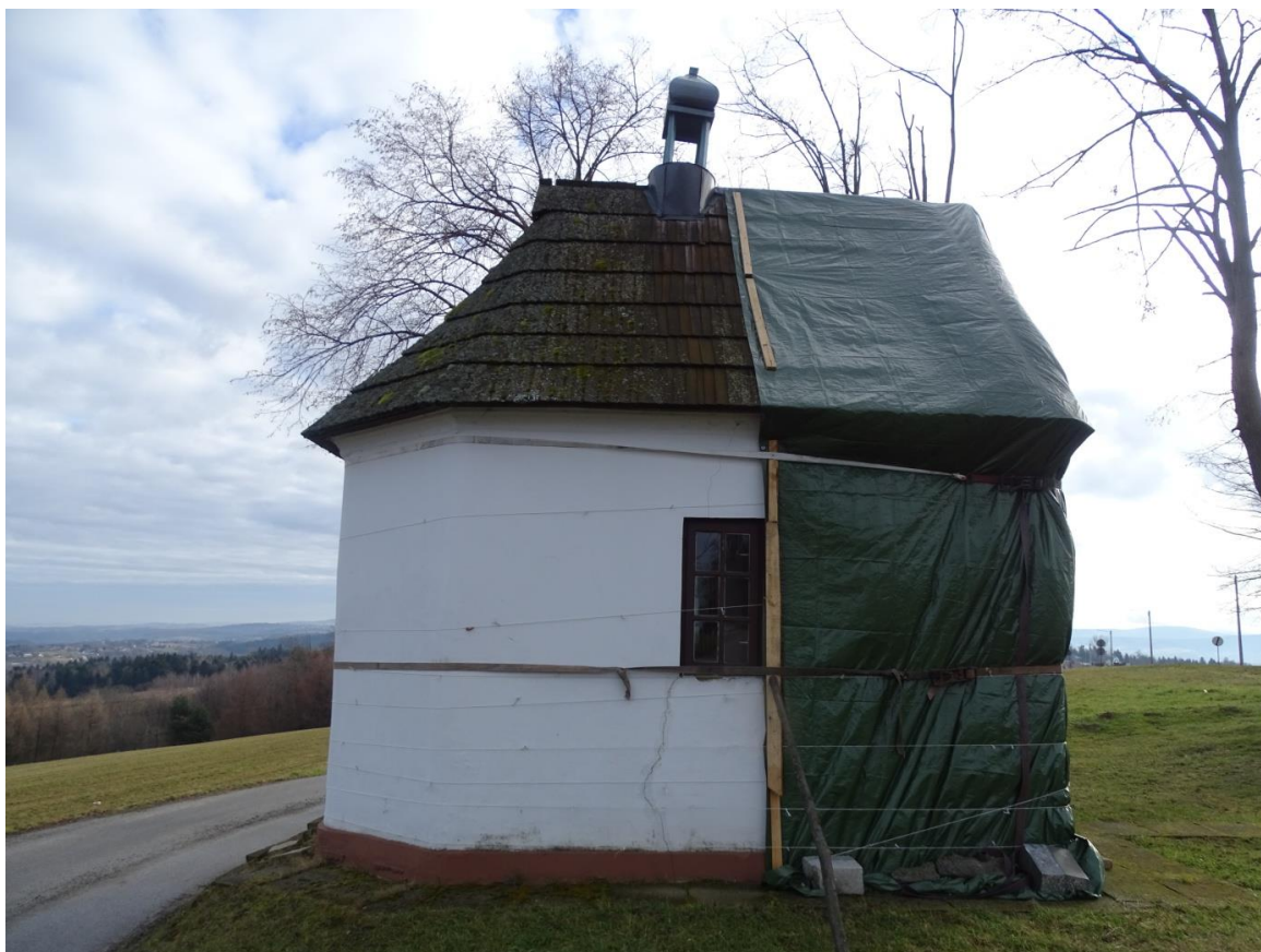
Fot.[4] Wygląd elewacji północnej. Widoczne pionowe zarysowanie ściany. Fot. autor.
