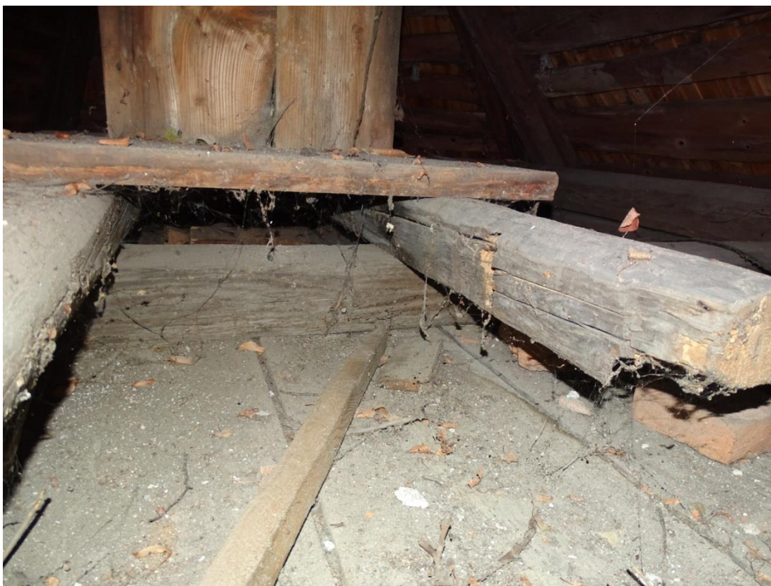
Fot.[7] Podwaliny sygnaturki z lokalną obecnością owadów. Fot. autor.
