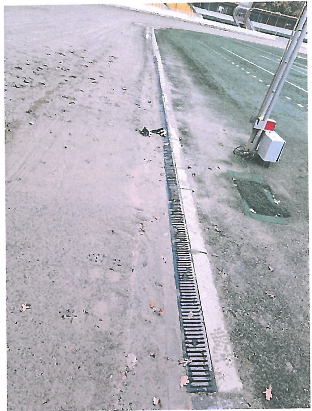
Zdj. 4, 5. Widok na istniejące odwodnienie toru żużlowego- krawężniki betonowe i fragment odwodnienia.
