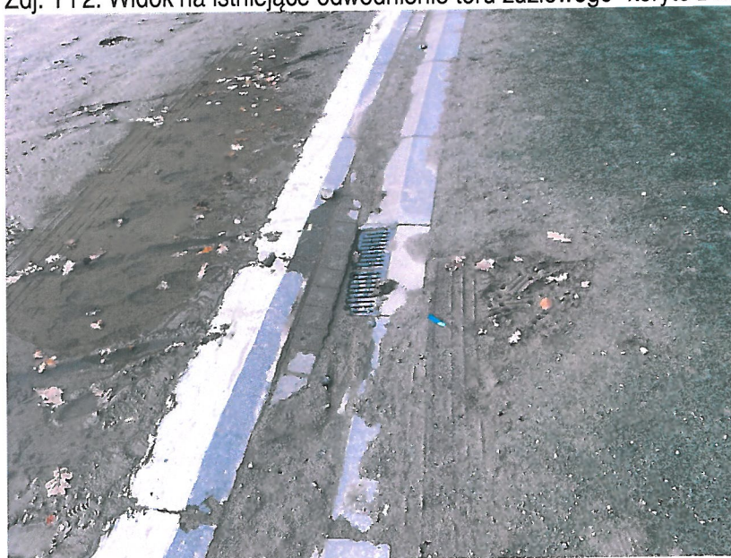
Zdj. 1 i 2. Widok na istniejące odwodnienie toru żuźlowego- koryto z krawężników betonowych i kostki.
