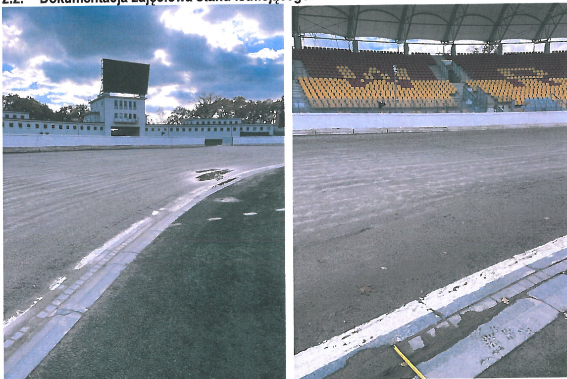
Zdj. 1 i 2. Widok na istniejące odwodnienie toru żuźlowego- koryto z krawężników betonowych i kostki.
