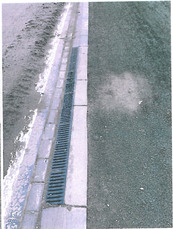
Zdj. 6, 7. Widok na istniejące odwodnienie toru żużlowego- krawężniki betonowe i fragment odwodnienia ze studzienką.
