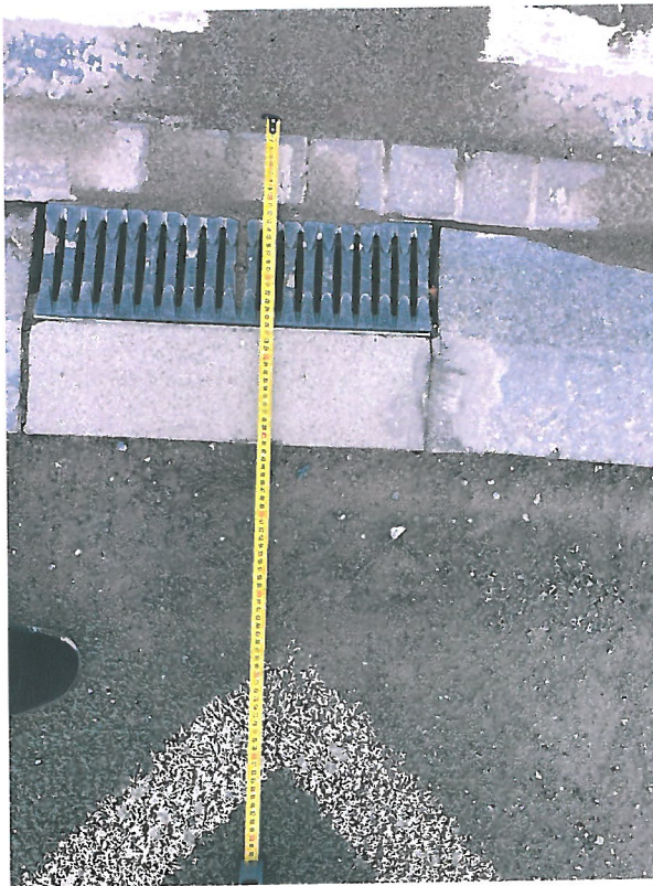
Zdj. 6, 7. Widok na istniejące odwodnienie toru żużlowego- krawężniki betonowe i fragment odwodnienia ze studzienką.
