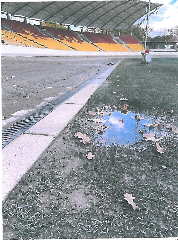
Zdj. 4, 5. Widok na istniejące odwodnienie toru żużlowego- krawężniki betonowe i fragment odwodnienia.
