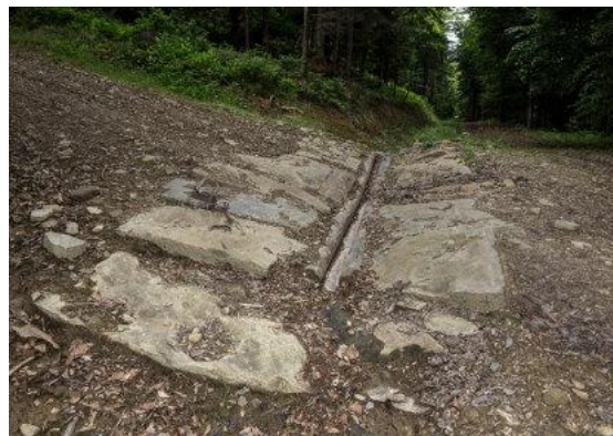
Wodospust odprowadzający wodę z drogi do lasu.
