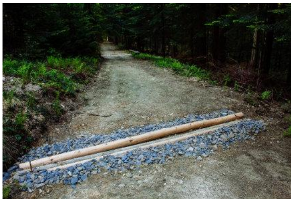
Wodospust z okrągłaków – Nadleśnictwo Gorlice
