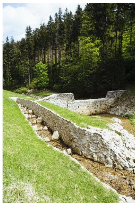
Zapora przeciwrumowiskowa w Nadleśnictwie Łądek Zdrój z oczyszczoną w ramach projektu retencji górskiej niecką (min. funkcja przeciwpowodziowa) i dobudowaną przeplawką. Zapora przerywa ciągłość transportu rumowiska - należy monitorować potrzebę alimentacji rumoszu poniżej zapory. Źródło: Archiwum CKPŚ.
