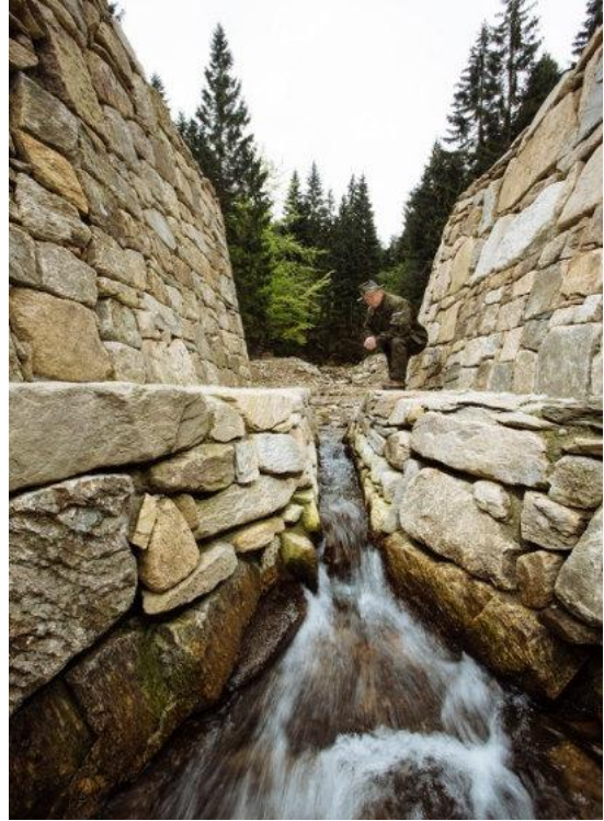
Widok na zaporę czołową dawnego zbiornika na cieku do spławu drewna przerobionego na zbiornik przeciwpowodziowy – Nadleśnictwo Międzylesie. Źródło: Archiwum CKPŚ. (rys. na górze)
