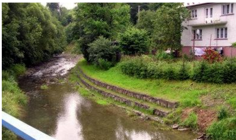
Fot. 3. Zabezpieczenie konstrukcji budowlanych
