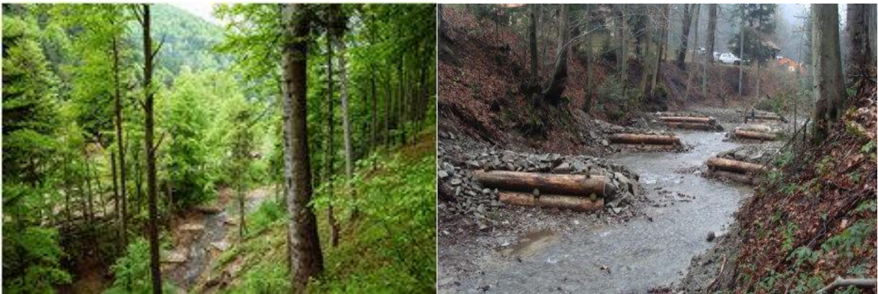
Deflektory nurtu drewniano-kamienne w górskim terenie w Nadleśnictwie Piwniczna
