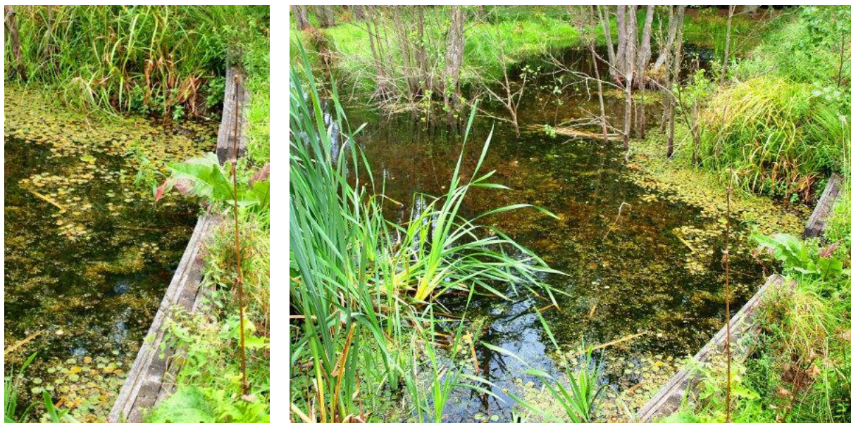
Nawet małe zastawki ulegają naporowi wody jeśli pozbawione są wzmocnień zastrzałem, oczepem i podparciem od dołu umocnieniem. Fot. Z. Filipek Źródło: Archiwum CKPS
