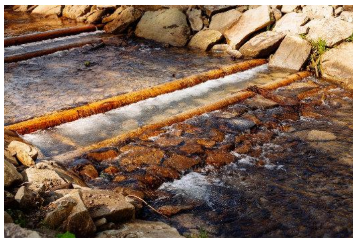
Kaskada bardzo niskich progów łatwa do pokonania dla organizmów wodnych, z basenami poniżej progu podpartymi gurtem doskonale zabezpieczonym narzutem kamiennym i belkami podłużnymi. Zwraca uwagę dobre zakotwienie belek w brzegach. Niestety brak przelewów na małą wodę. Źródło: Archiwum CKPŚ.
