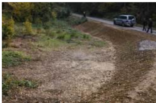
Zbiorniki na spływy powierzchniowe w N-ctwie Piwniczna
