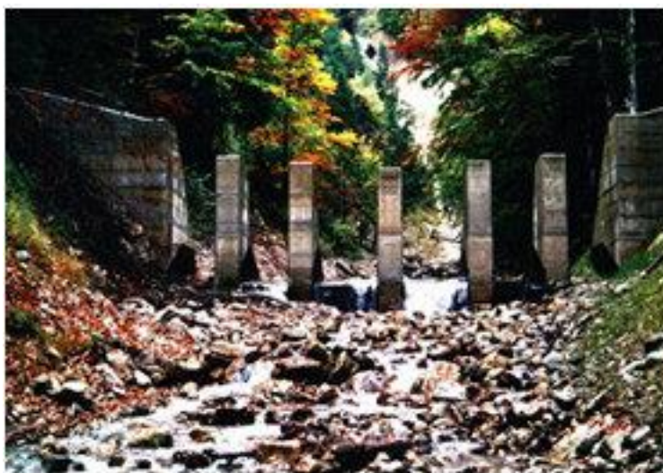
Zmodernizowana zapora szczelinowa (Austria)
