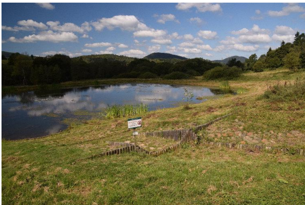
Ostatni ze zbiorników kaskadowych zasilanych z cieków a dodatkowo także wodą doprowadzoną z rowu przydrożnego – na pierwszym planie widoczne miejsce zasilania zbiornika wodą z rowu – Nadleśnictwo Baligród (fot. M. Kucharz)
