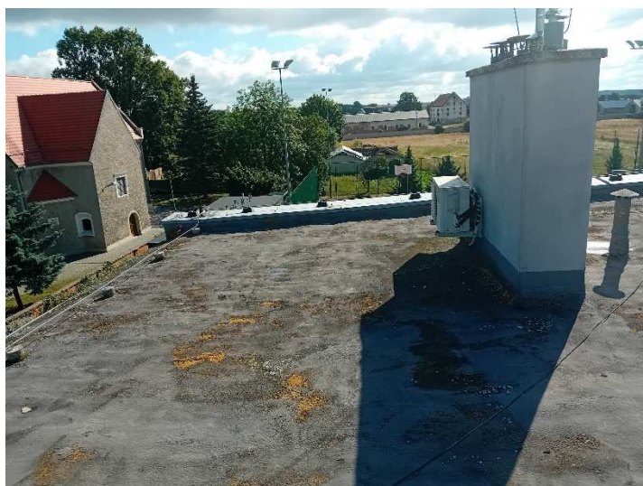
Dach nad częścią mieszkalną
