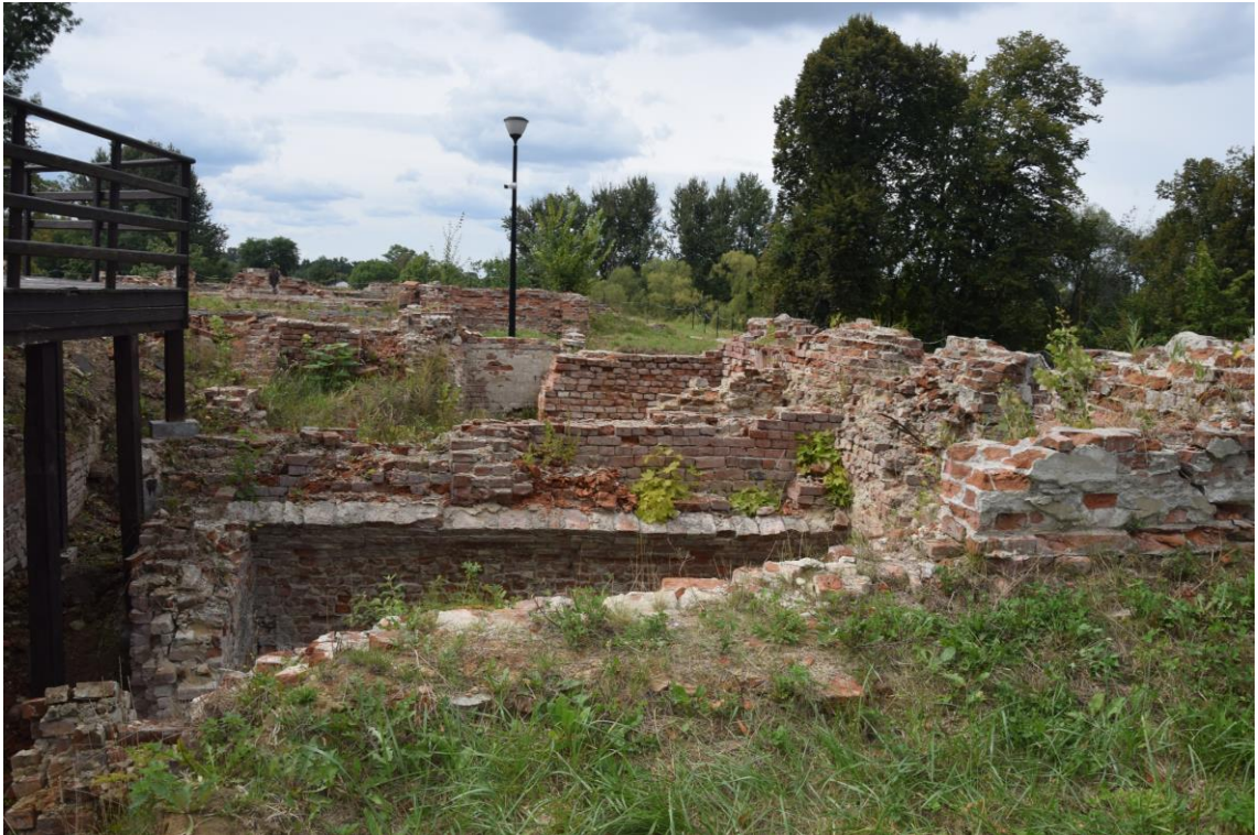
Fot. Piwnice -1.4 i -1.5 widok od przejścia. Stan zachowania na 2024 r.
