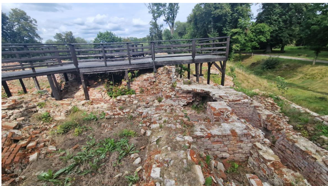
Fot. Widok na pomieszczenie 0.16. Widok połączenia ze strukturą murową od strony wschodniej. Stan zachowania 2024 r.
