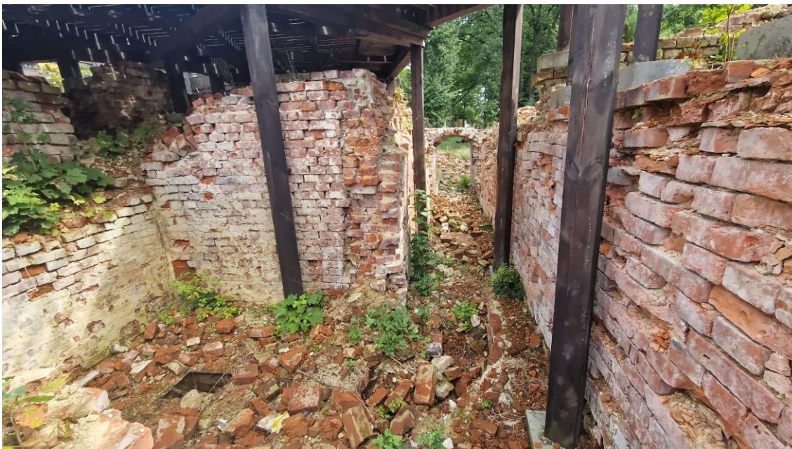
Fot. Ściany przejścia podziemnego -1.2 pod помещением 0.16. Widok od strony podpiwniczenia pod помещением 0.15. Stan zachowania na 2024 r.
