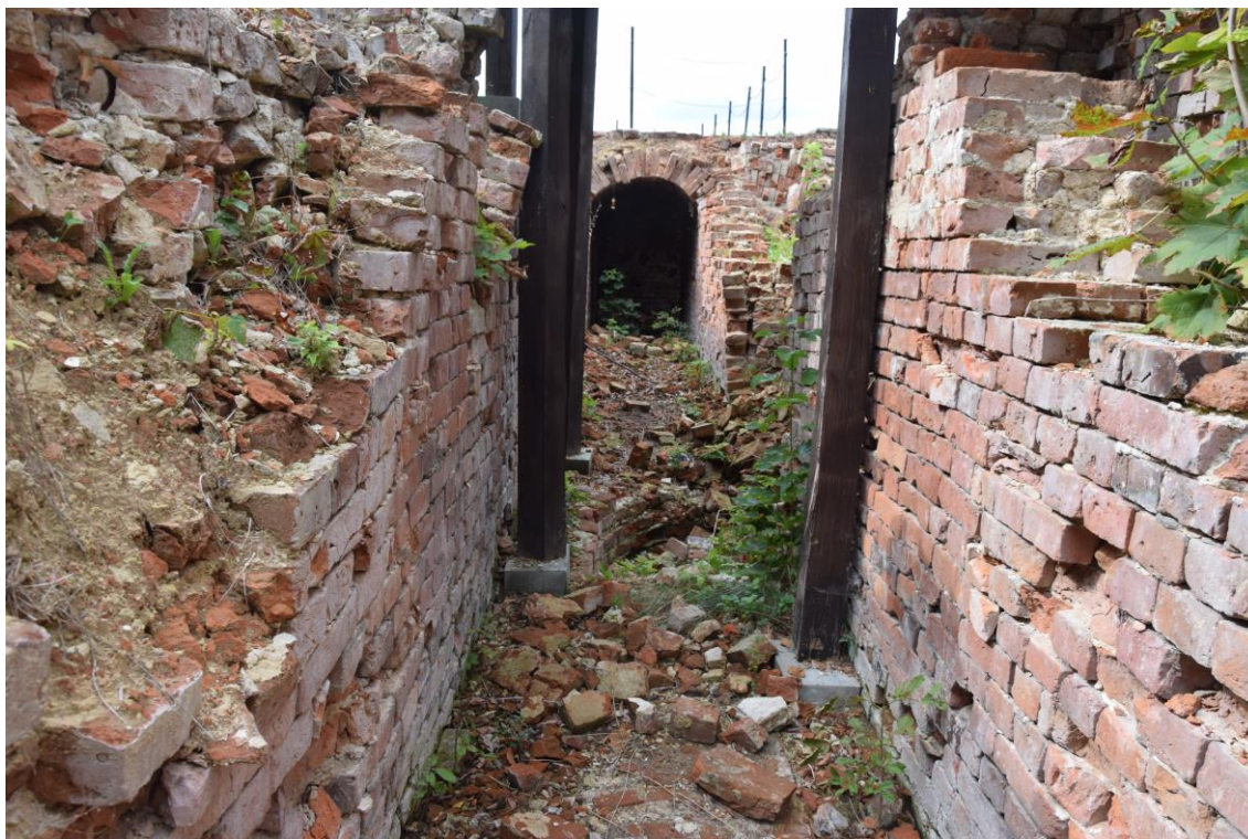
Fot. Ściany przejścia podziemnego -1.2 pod pomieszczeniem 0.16. Stan zachowania na 2024 r.
