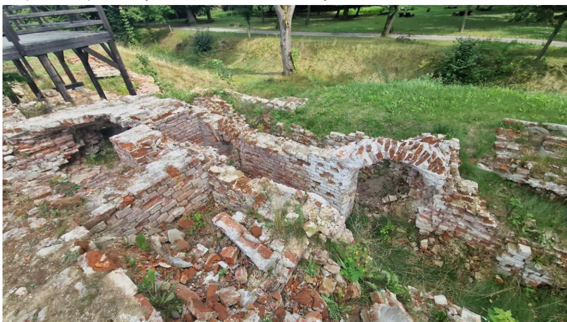
Fot. Obszar przejścia -1.1. Widok od strony pomieszczenia 0.16. Stan zachowania na 2024 r.
