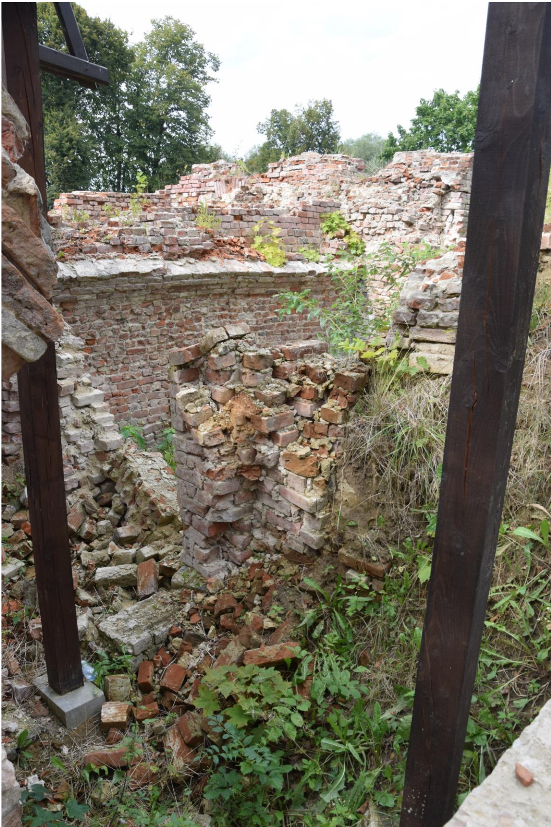
Fot. Piwnice -1.4 i -1.5 widok od przejścia. Stan zachowania na 2024 r.
