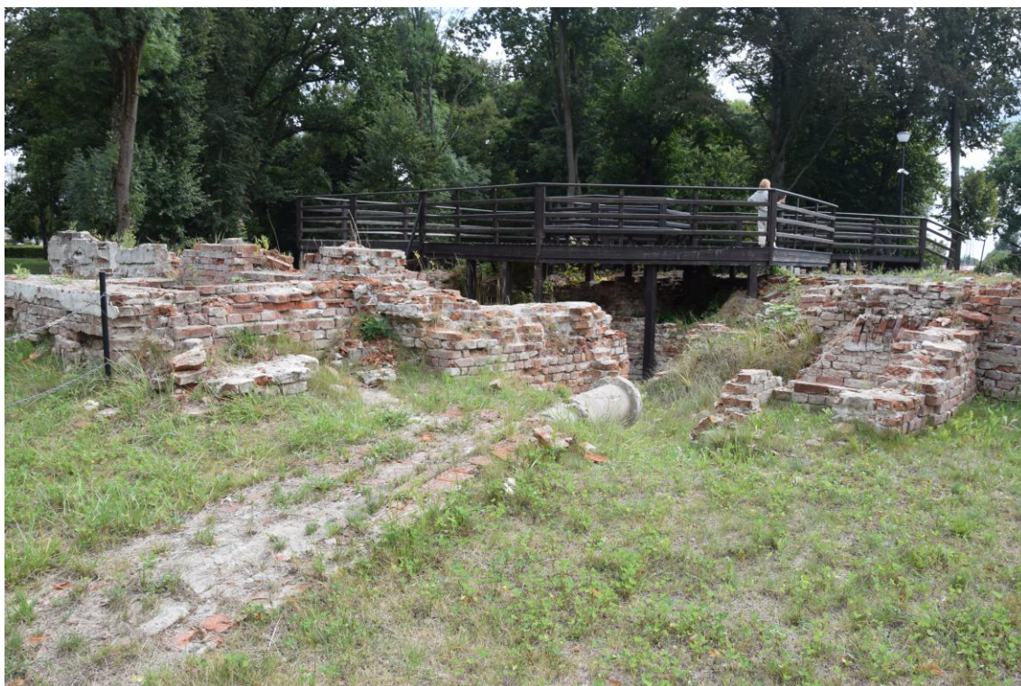
Fot. Pozostałości systemu kanalizacji deszczowej. Stan zachowania na 2024 r.
