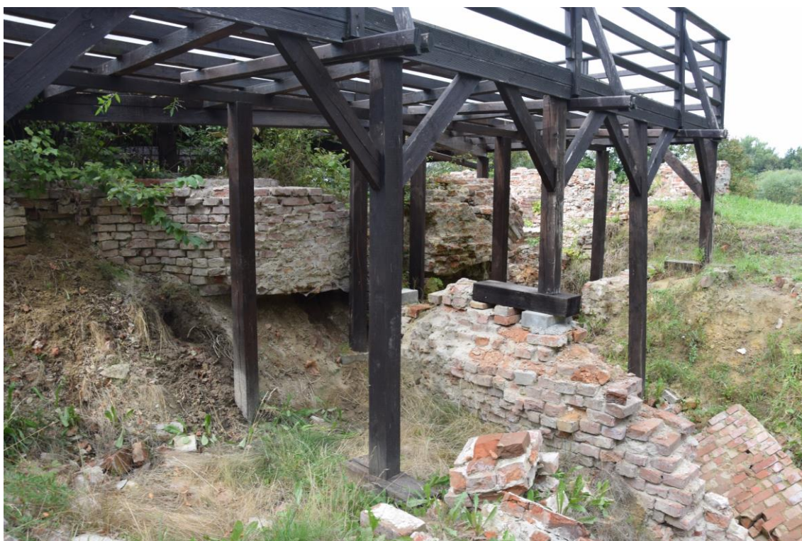
Fot. Taras T3 – widok od wschodu. Stan zachowania na 2024 r.
