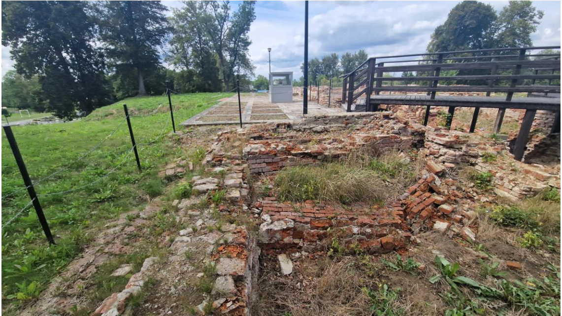
Fot. Widok na pomieszczenie 0.16. Od strony południowej ściany widoczny zachowany kanał technologiczny. Stan zachowania 2024 r.
