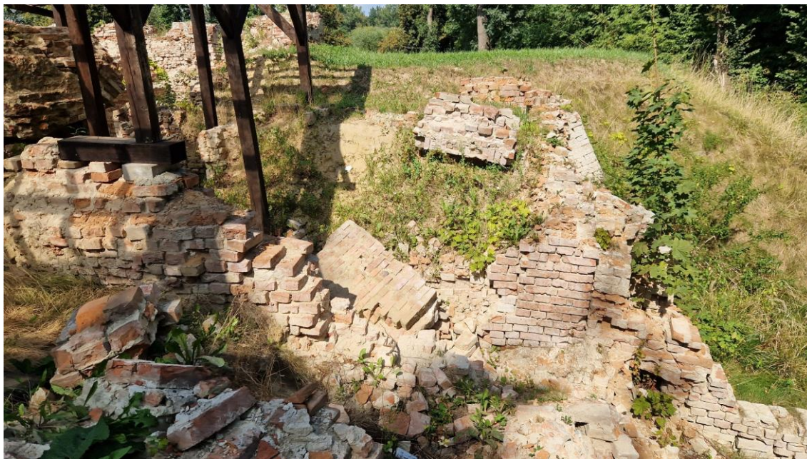
Fot. Obszar przejścia podziemnego do piwnic. Stan zachowania na 2024 r.
