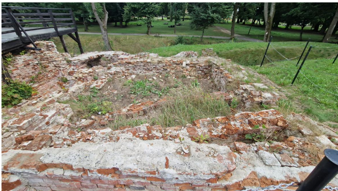
Fot. Widok na pomieszczenie 0.16. Między ścianami widoczne pozostałości kanału technologicznego. Stan zachowania 2024 r.
