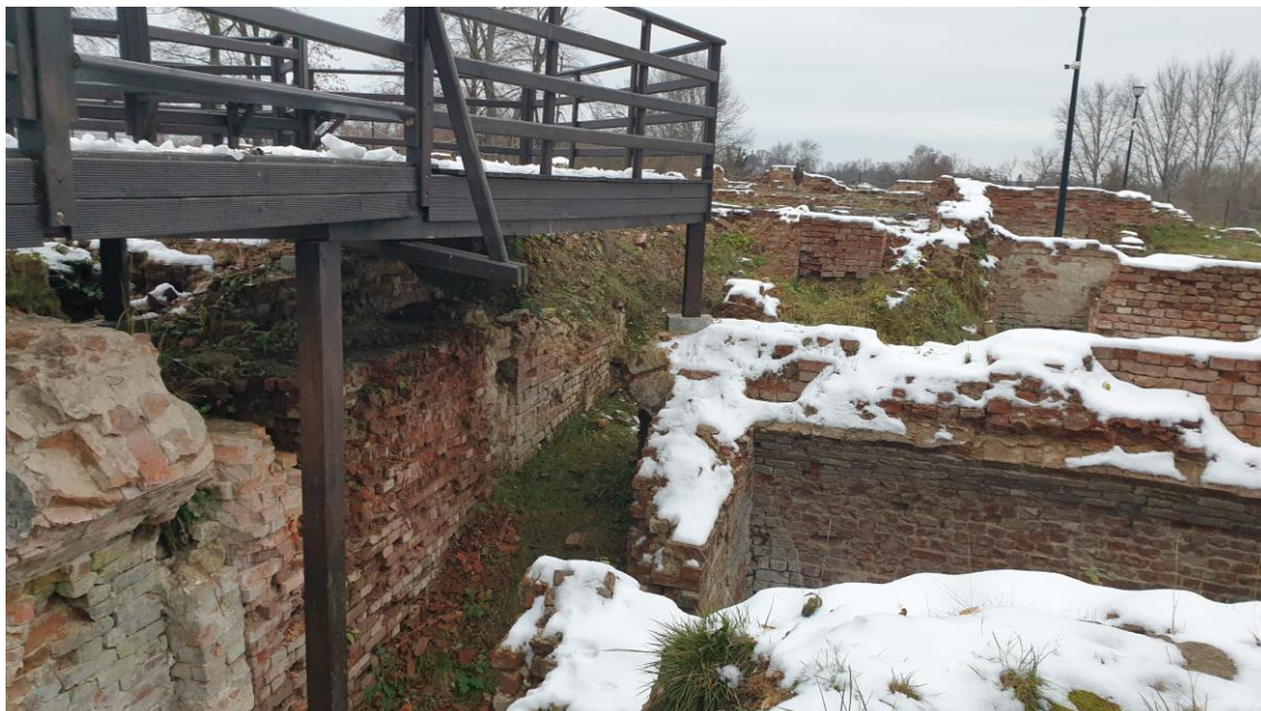
Fot. Obszar przejścia podziemnego do piwnic. Stan zachowania na 2023 r.
