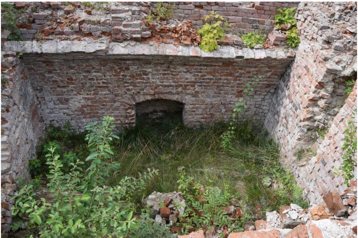
Fot. Piwnica -1.4. Stan zachowania na 2024 r.
