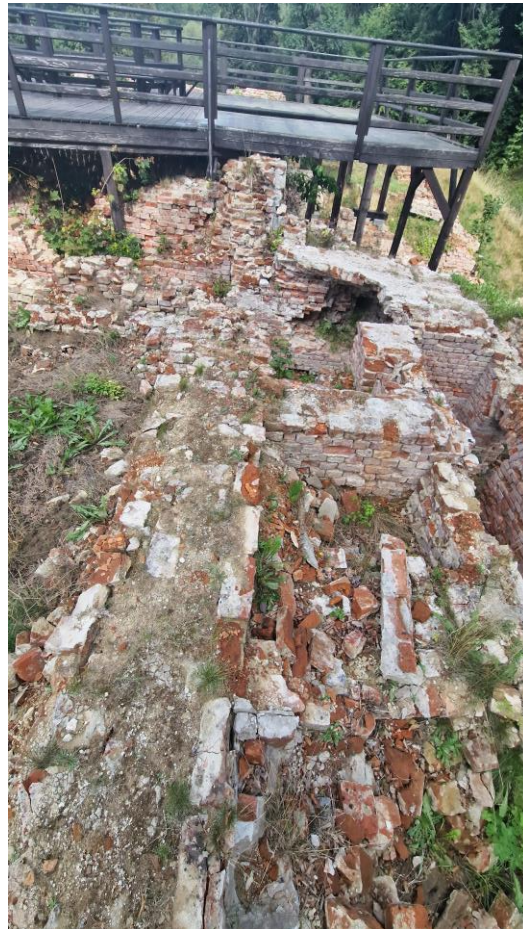
Fot. Przejście -1.1. Struktura murowa pomiędzy ścianą przejścia a ścianą pomieszczenia 0.16. Stan zachowania na 2024 r.
