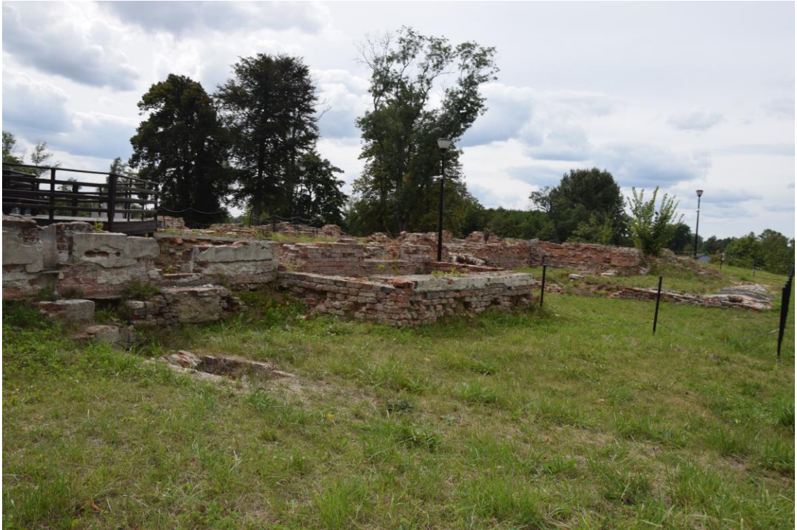
Fot. Widok od zewnątrz na ściany piwnicy od strony północnej. Stan zachowania na 2024 r.
