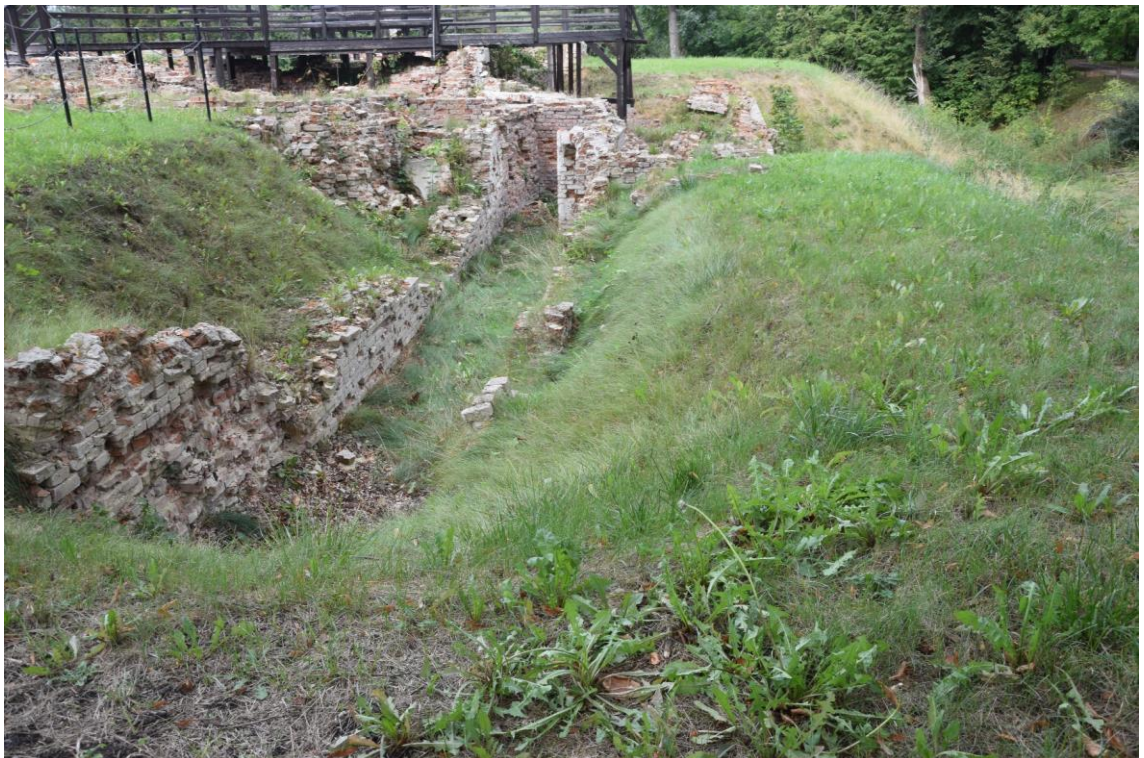
Fot. Przejście -1.1. Stan zachowania na 2024 r.
