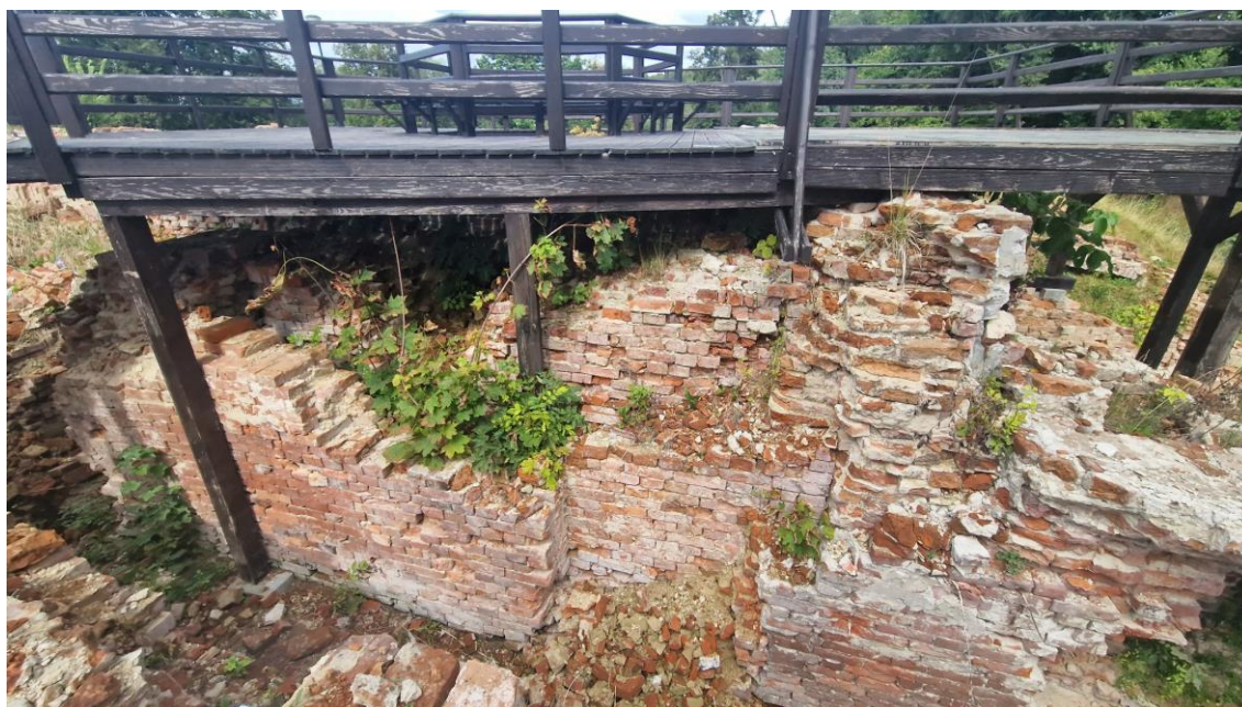
Fot. Taras T3 – widok od strony pomieszczenia 0.16. Stan zachowania na 2024 r.
