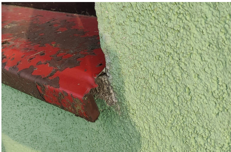
Zdj. nr 4- Uszkodzony parapet oraz zbrojenie diagonalne ościeża
