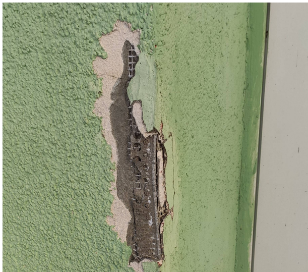
Zdj. nr 3 – Uszkodzenia narożnika ściany
