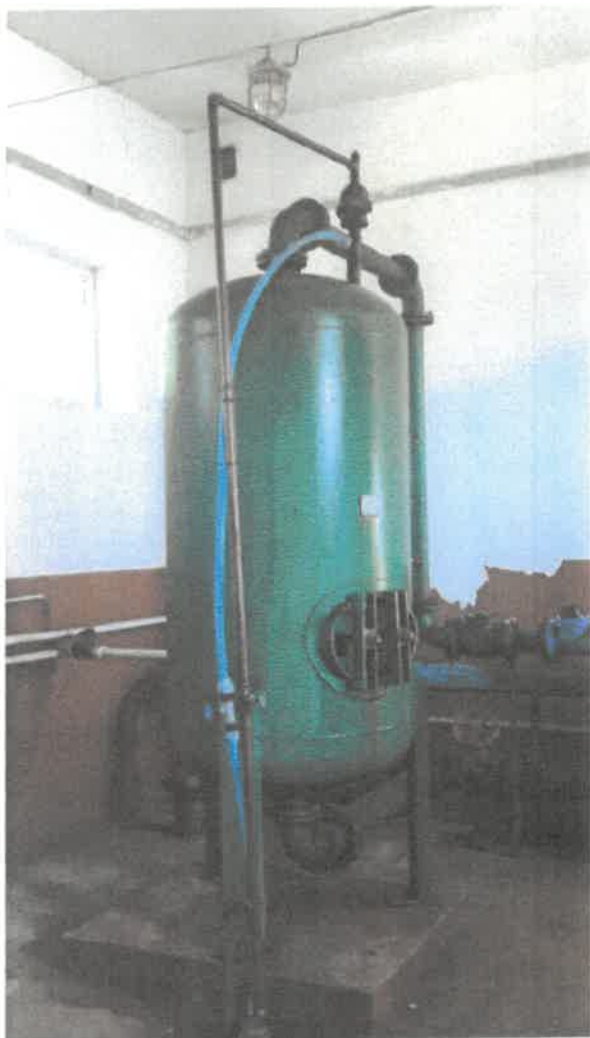
Aerator, rurociągi technologiczne
