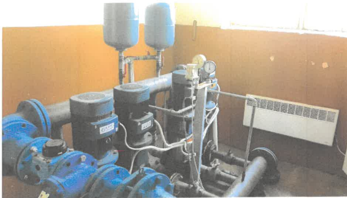
Zestaw hydroforowy wody na sieć
