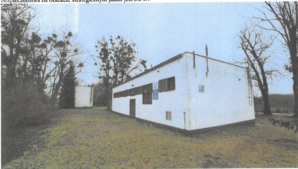
Istniejący budynek SUW
