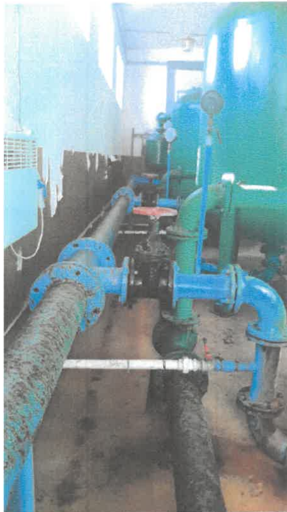
Aerator, rurociągi technologiczne
