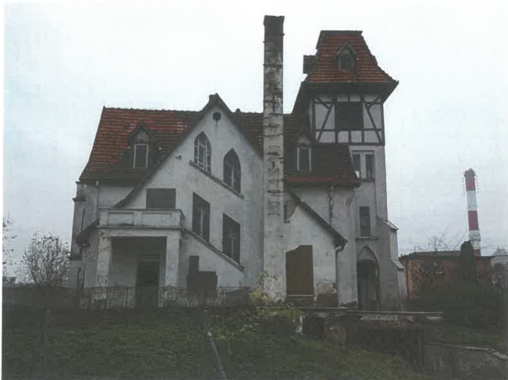
Fot. 3 – Elewacja tylna budynku (północno-zachodnia) od strony ul. Recznej.
