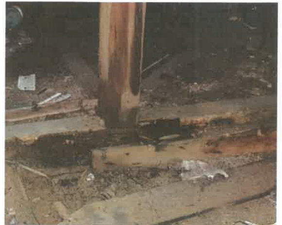
Fot. 9 – Kolejny przykład działania wilgoci na drewno konstrukcji dachowej wieży. Widoczna korozja biologiczna słupa oraz kleszczy.
