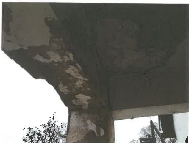
Fot. 46, 47, 48 – Zniszczenia oczepu żelbetowego stanowiącego podparcie balkonu nad wejściem głównym do budynku.
