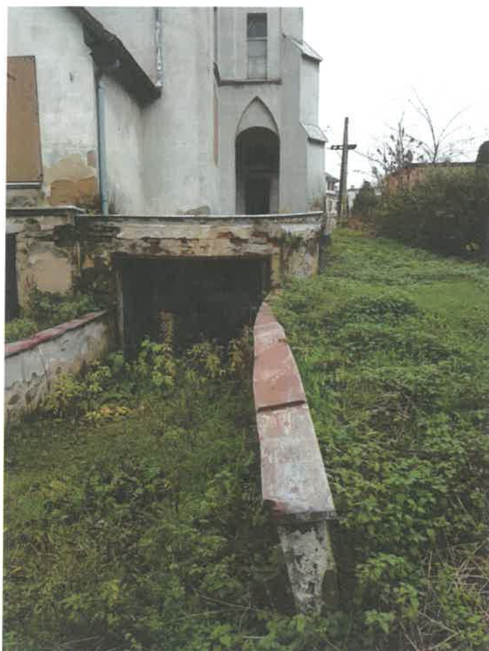
Fot. 62 – Totalna destrukcja tynku oraz materiału ceramicznego ściany przedsionka kotłowni oraz garażu.
