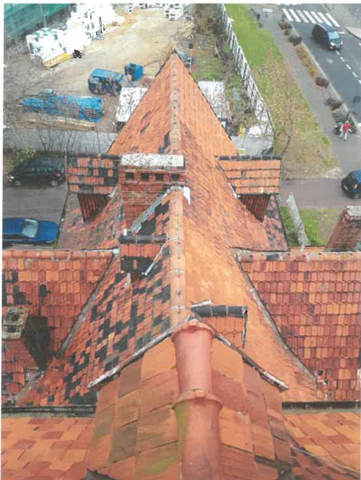
Fot. 19 – Widok ogólny połaci dachowych budynku.
