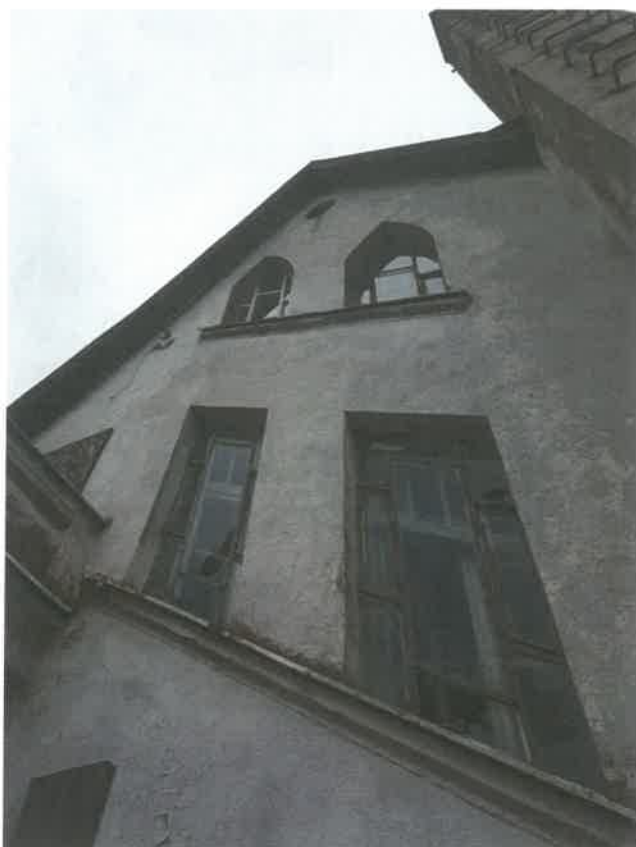
Fot. 96, 97 – Okna doświetlające klatkę schodową nadające wyjątkowy charakter tylnej elewacji frontowej budynku. Stan techniczny stolarki zły, liczne ubytki szklenia.
