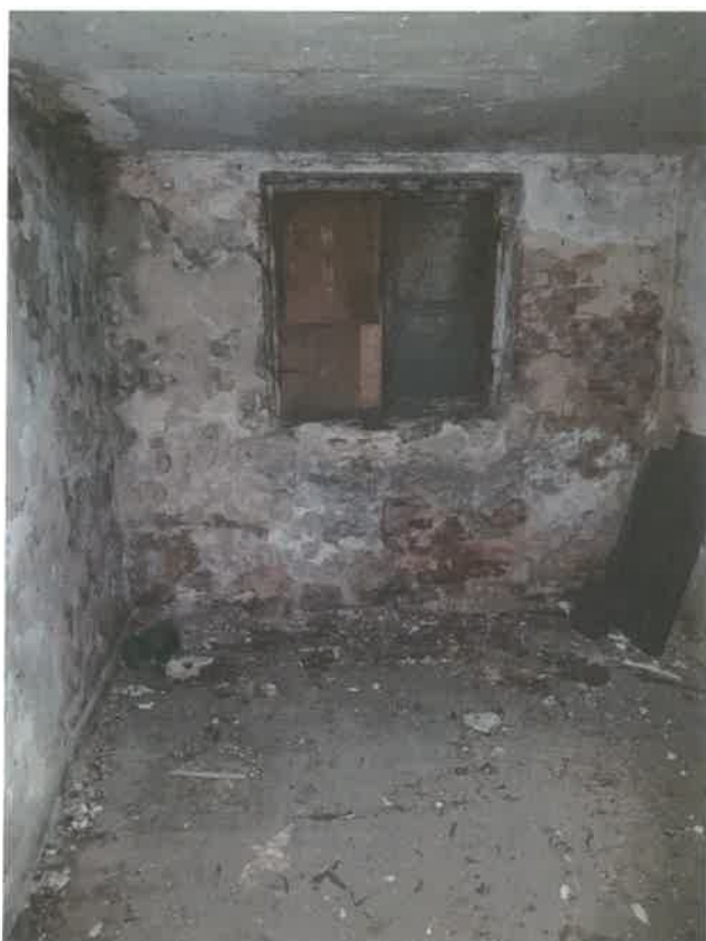
Fot. 68, 69 – Przykład dewastacji pomieszczeń piwnicznych. Ubytki tynków, zawilgocenia ścian i posadzek spowodowane infiltracją wód opadowych przez uszkodzone i nieuszczelnione naświetla okienne.
