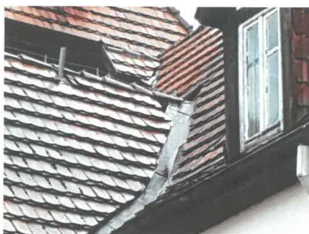
Fot. 25, 26 – Ubytki dachówek w rejonie kosza dachowego.
