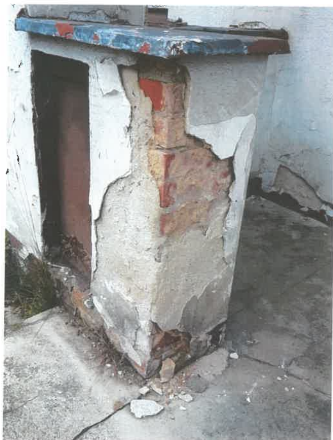
Fot. 49, 50 – Degradacja tynków cokołowych w rejonie wejścia głównego..
