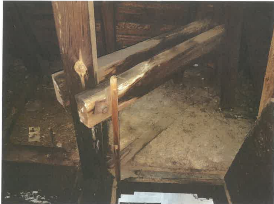
Fot. 9 – Kolejny przykład działania wilgoci na drewno konstrukcji dachowej wieży. Widoczna korozja biologiczna słupa oraz kleszczy.
