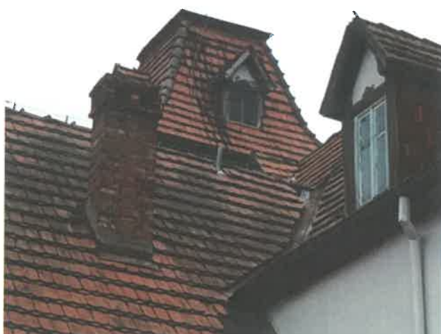
Fot. 25, 26 – Ubytki dachówek w rejonie kosza dachowego.
