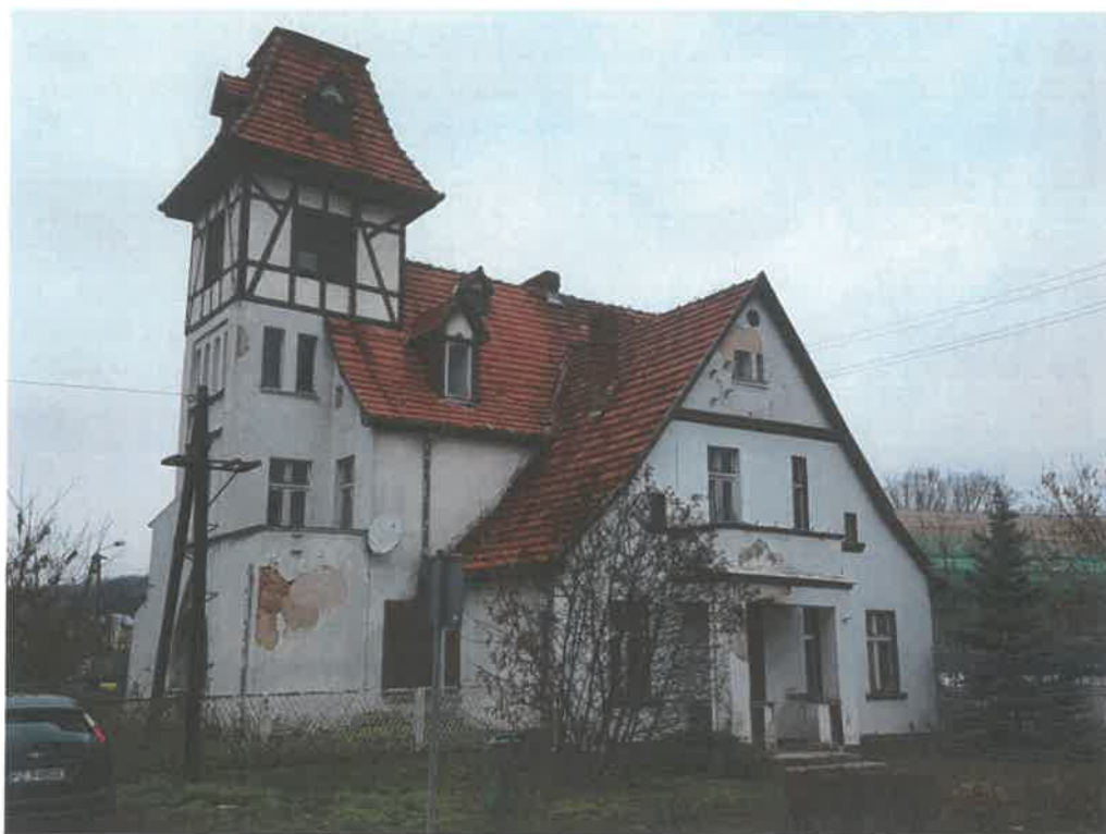
Fot. 1 – Elewacja frontowa budynku (południowo-wschodnia) od strony ul. Wawrzyniaka.
