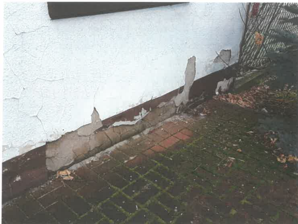
Fot. 51 – Kolejny przykład degradacji tynków cokołowych.
