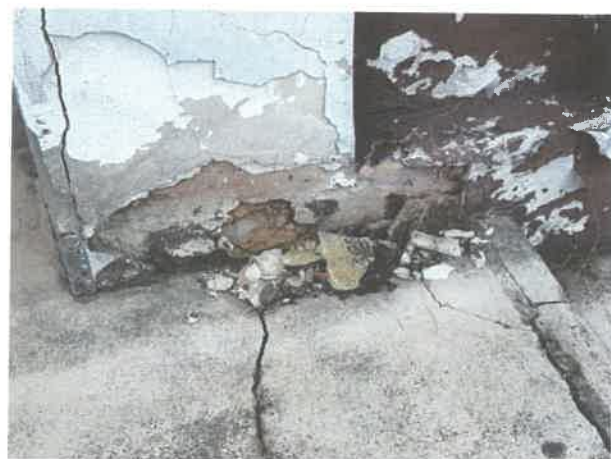
Fot. 46, 47, 48 – Zniszczenia oczepu żelbetowego stanowiącego podparcie balkonu nad wejściem głównym do budynku.
