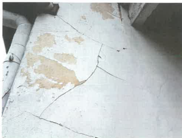
Fot. 51 – Kolejny przykład degradacji tynków cokołowych.
