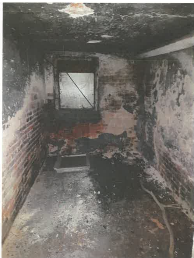
Fot. 68, 69 – Przykład dewastacji pomieszczeń piwnicznych. Ubytki tynków, zawilgocenia ścian i posadzek spowodowane infiltracją wód opadowych przez uszkodzone i nieuszczelnione naświetla okienne.
