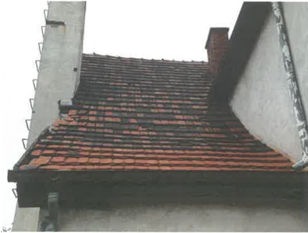
Fot. 27, 28 – Kolejny przykład przemieszczeń i ubytków dachówek oraz uszkodzeń wiatrownicy.
