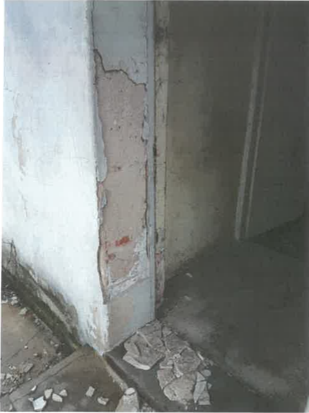
Fot. 59, 60 – Ubytki i odspojenia tynku w otworze wyjścia na taras budynku (porównaj z fot. 58).
