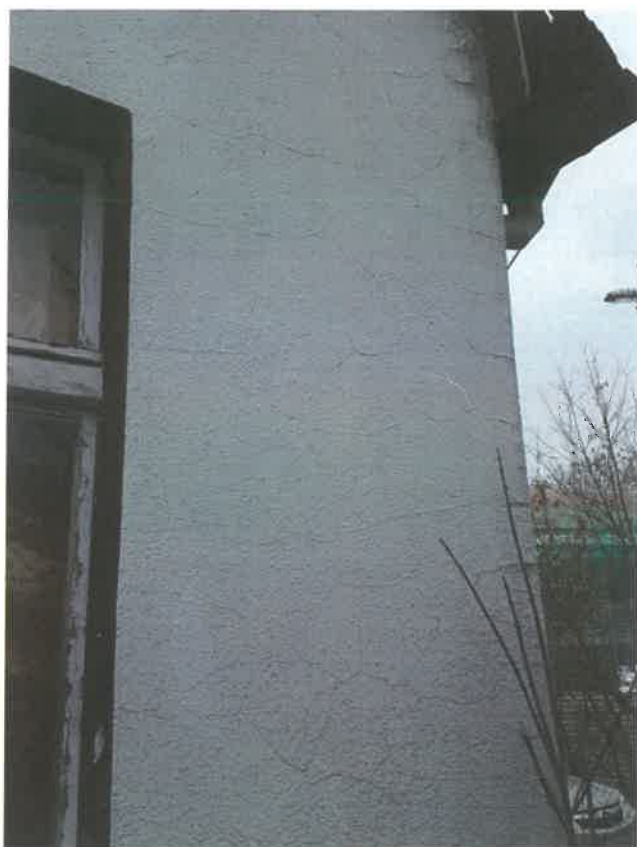
Fot. 51 – Kolejny przykład degradacji tynków cokołowych.
