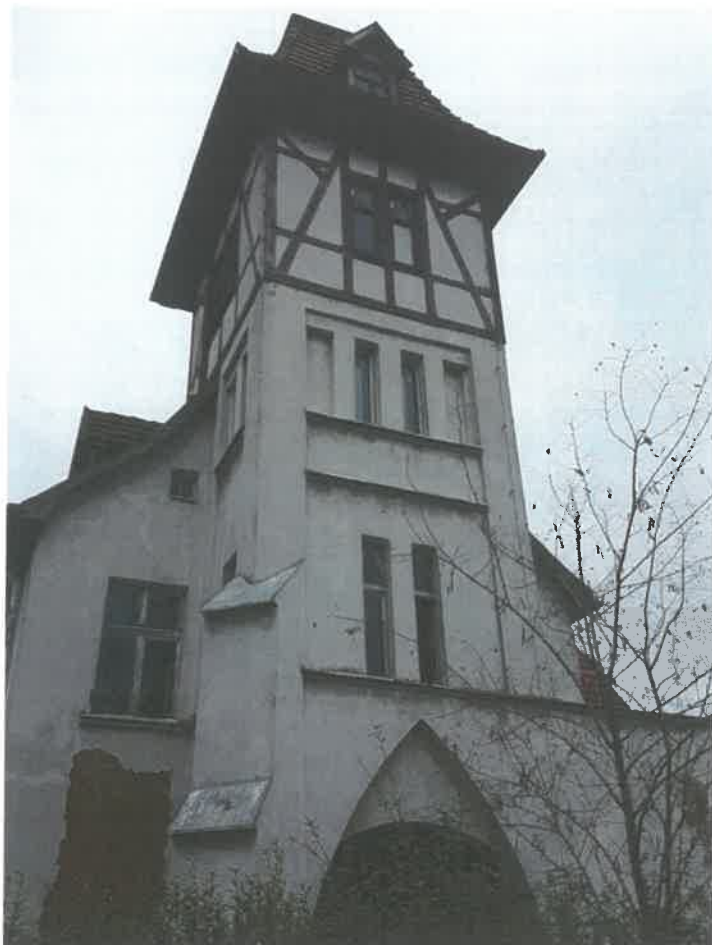
Fot. 4 – Elewacja boczna budynku (południowo-zachodnia).
