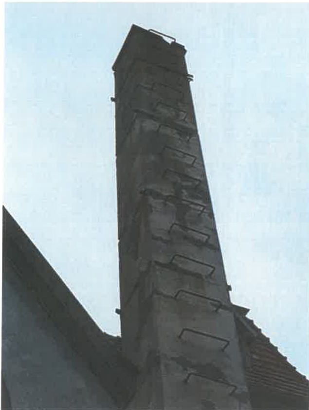
Fot. 40, 41 – Duża degradacja komina ponad dachem budynku – stan przedawaryjny.
