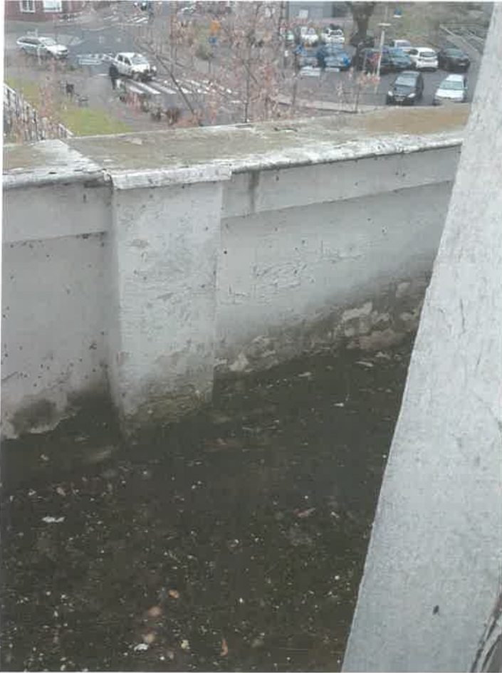
Fot. 78 – Korozja biologiczna posadzki balkonu oraz ściany balustradowej. Zły stan obróbek blacharskich murowanej balustrady.
