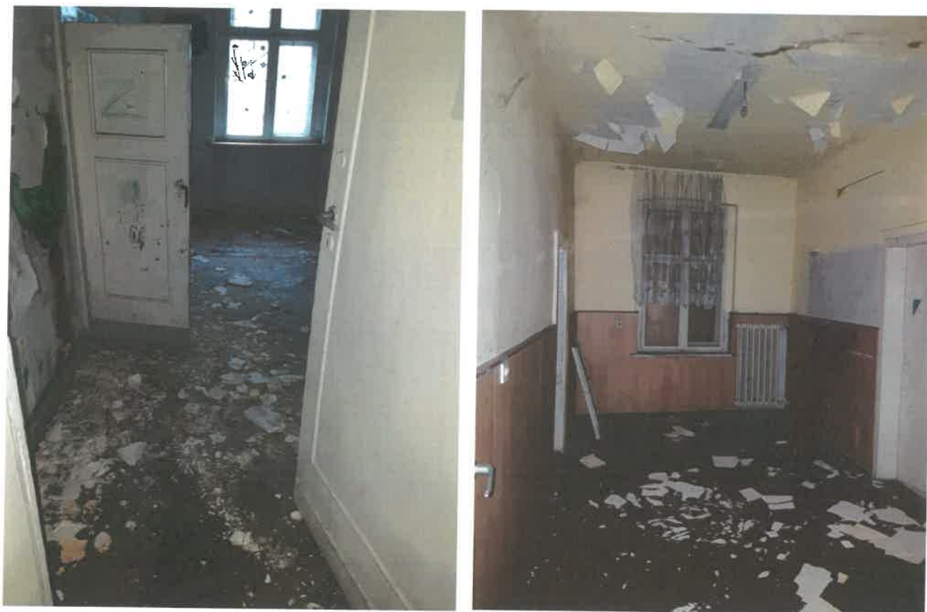
Fot. 101, 102 – Przykładowy stan pomieszczeń w budynku.
