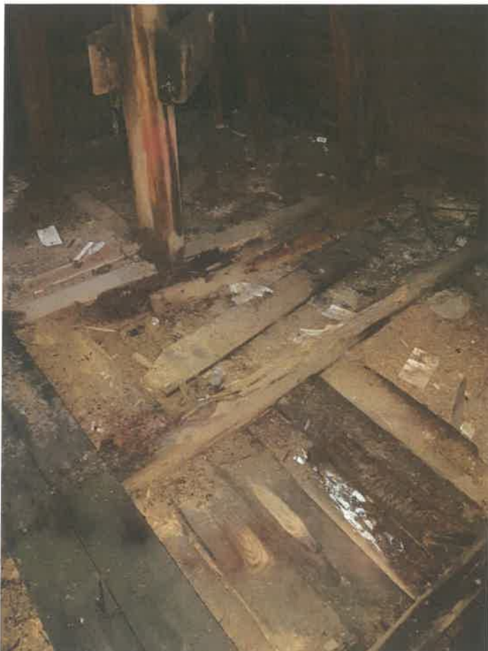
Fot. 9 – Kolejny przykład działania wilgoci na drewno konstrukcji dachowej wieży. Widoczna korozja biologiczna słupa oraz kleszczy.
