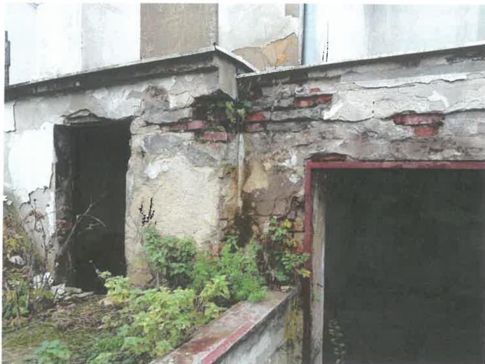
Fot. 62 – Totalna destrukcja tynku oraz materiału ceramicznego ściany przedsionka kotłowni oraz garażu.
