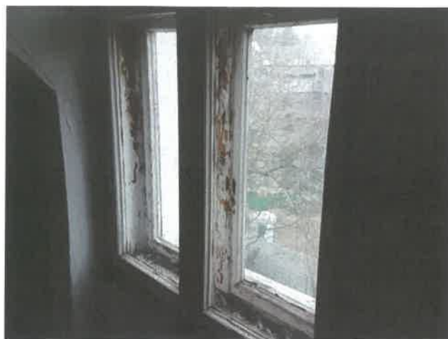
Fot. 98, 99 – Zużyta technicznie stolarka okienna.
