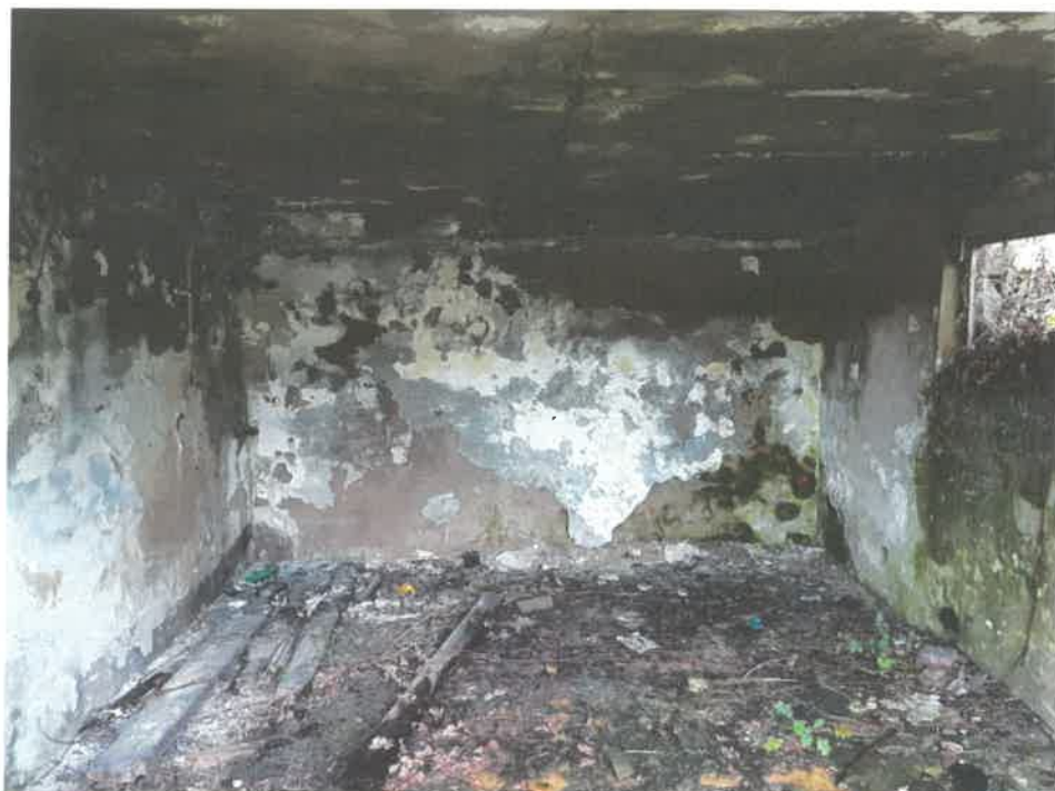
Fot. 64 – Totalna dewastacja ścian, posadzki i stropu wewnątrz garażu. Widoczne duże ogniska korozji biologicznej w postaci pleśni i glonów. Ściany silnie zawilgocone (mokre).
