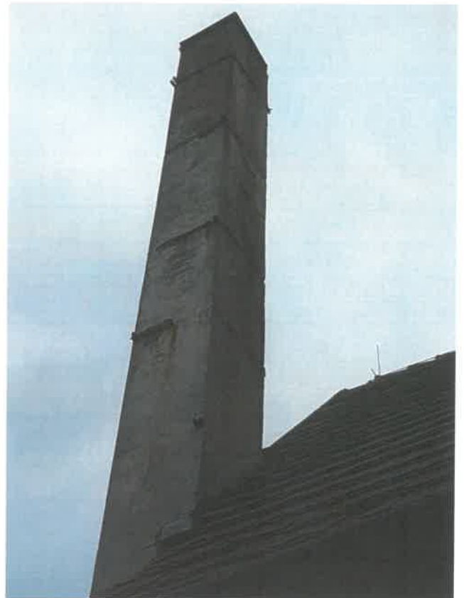
Fot. 40, 41 – Duża degradacja komina ponad dachem budynku – stan przedawaryjny.
