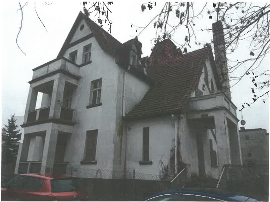
Fot. 2 – Elewacja boczna budynku (północno-wschodnia).
