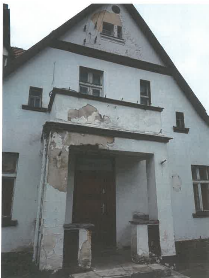
Fot. 44, 45 – Zniszczenia elewacyjne ściany szczytowej od strony wejścia głównego do budynku.
