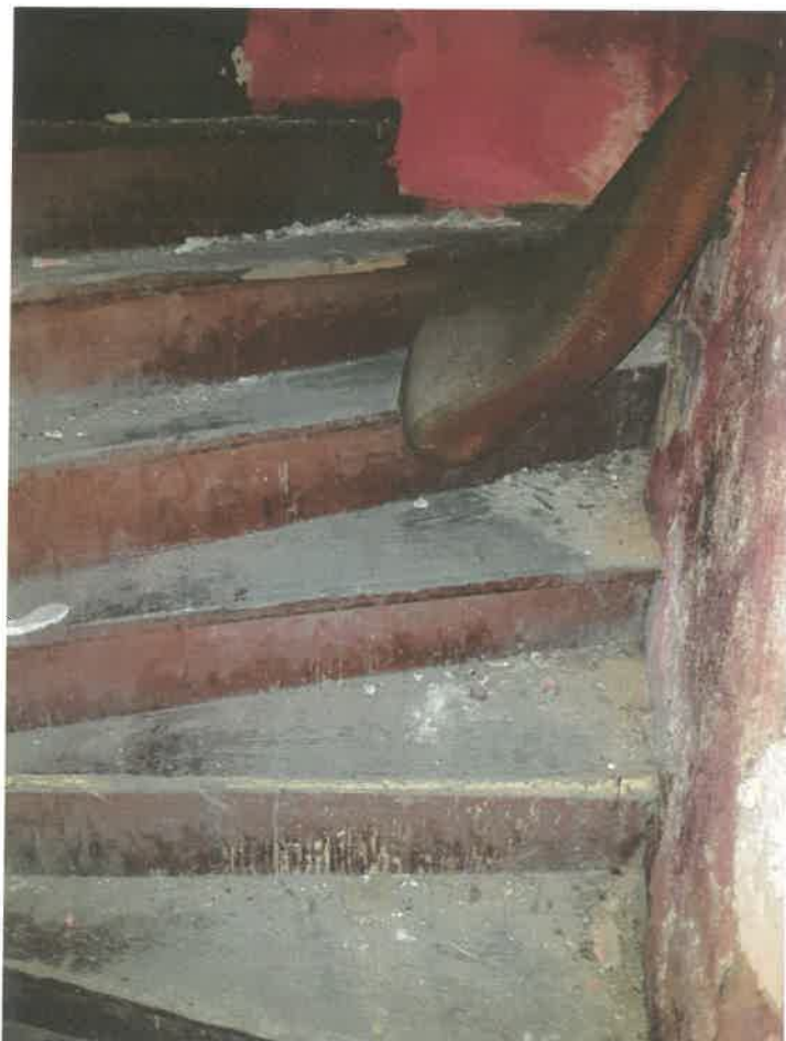
Fot. 95 – Drewniane schody zejściowe do piwnicy.
