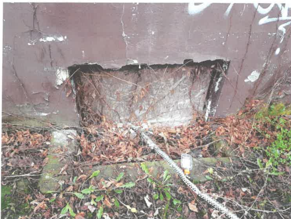
Fot. 57 – Spękany tynk cokołowy. Zanieczyszczone naświetle okienne piwnicy, przez które woda opadowa infiltruje do środka budynku powodując zawilgocenie murów piwnic.
