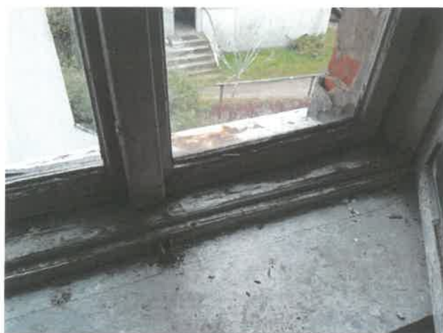
Fot. 98, 99 – Zużyta technicznie stolarka okienna.
