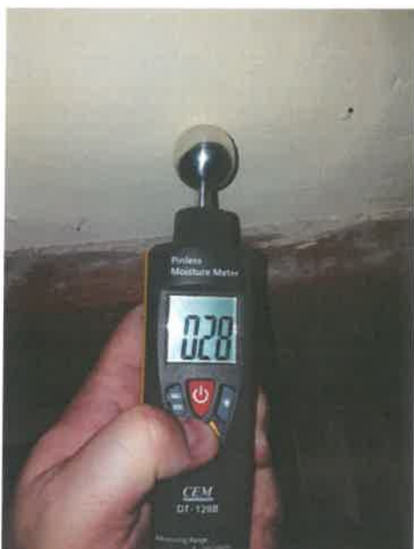
Fot. 104 – Przykładowy wynik pomiaru ściany zewnętrznej parteru.
