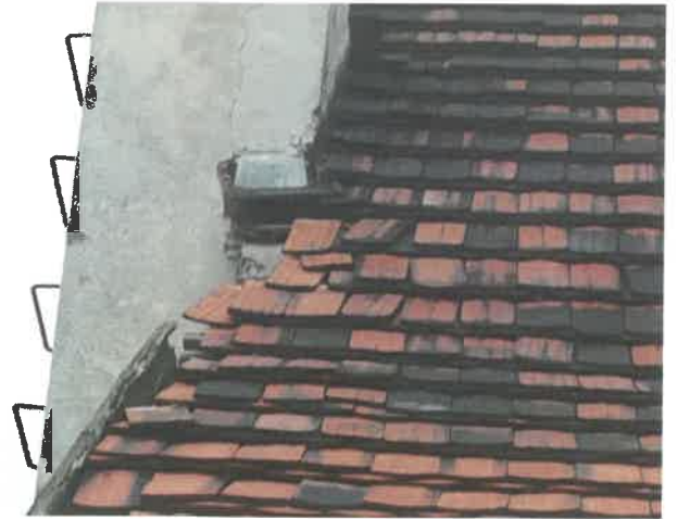
Fot. 27, 28 – Kolejny przykład przemieszczeń i ubytków dachówek oraz uszkodzeń wiatrownicy.
