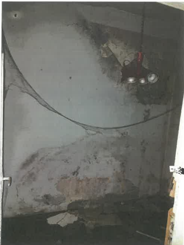
Fot. 66, 67 – Silne zawilgocenie z ogniskami korozyjnymi (pleśń) ścian wewnętrznych 1 piętra.
