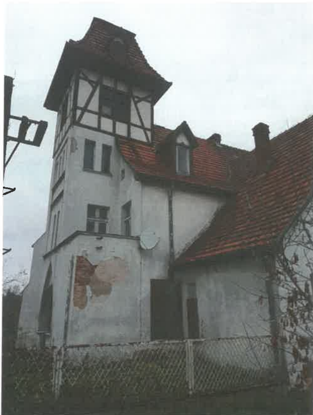
Fot. 42, 43 – Ubytki tynku elewacyjnego. Odstonięte wiązanie cegieł, widoczne na fot. po prawej, świadczy o istniejącym pierwotnie otworze, zamurowanym w okresie późniejszym.
