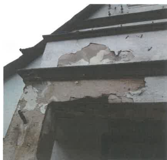
Fot. 42, 43 – Ubytki tynku elewacyjnego. Odstonięte wiązanie cegieł, widoczne na fot. po prawej, świadczy o istniejącym pierwotnie otworze, zamurowanym w okresie późniejszym.
