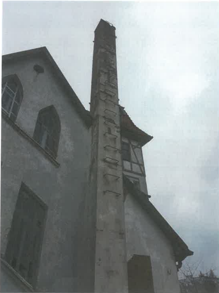
Fot. 39 – Widok ogólny komina na elewacji tylnej budynku.
