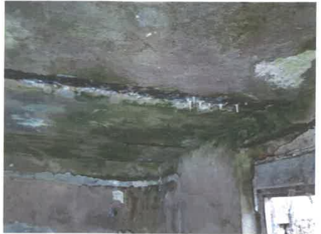
Fot. 78 – Korozja biologiczna posadzki balkonu oraz ściany balustradowej. Zły stan obróbek blacharskich murowanej balustrady.
