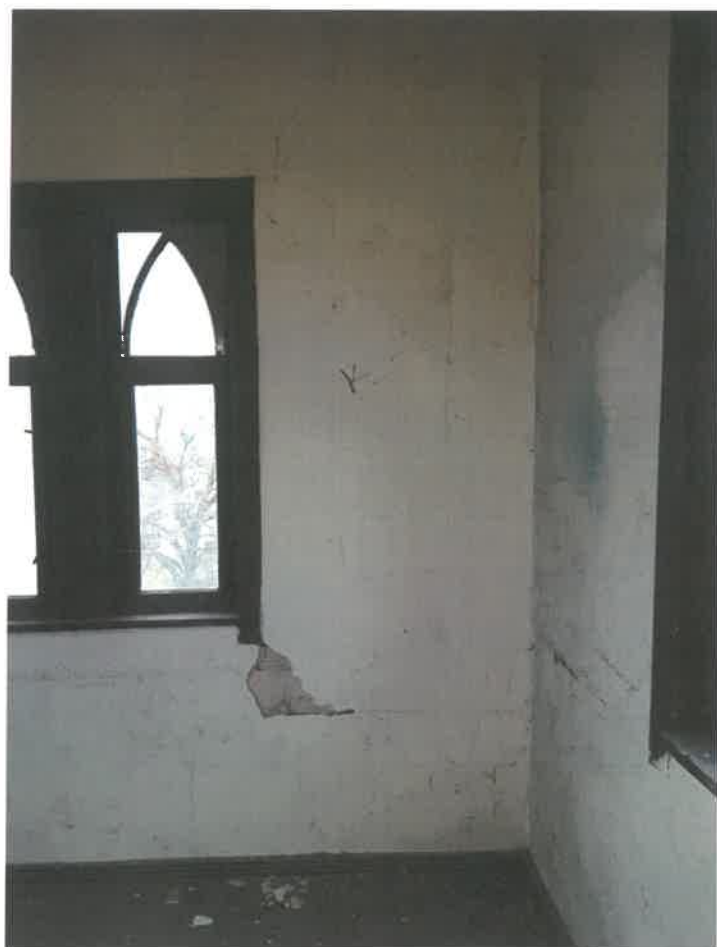
Fot. 64 – Totalna dewastacja ścian, posadzki i stropu wewnątrz garażu. Widoczne duże ogniska korozji biologicznej w postaci pleśni i glonów. Ściany silnie zawilgocone (mokre).
