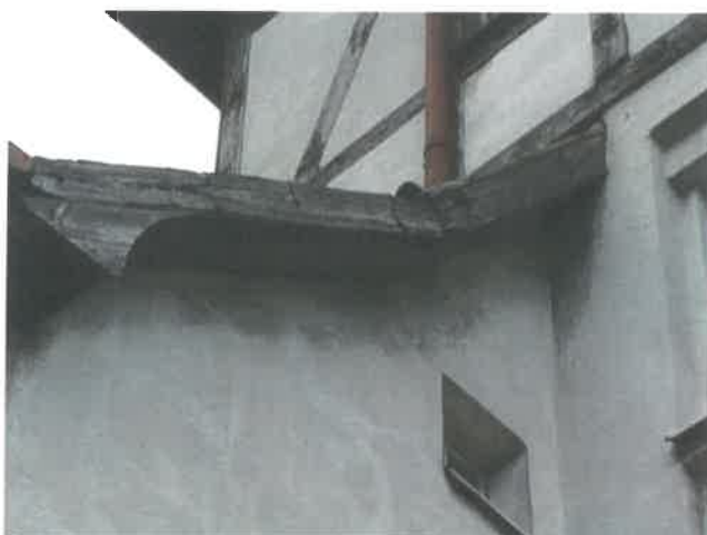
Fot. 32, 33, 34 – Kolejne przykłady zużycia technicznego i uszkodzeń drewna wiatrownic.
