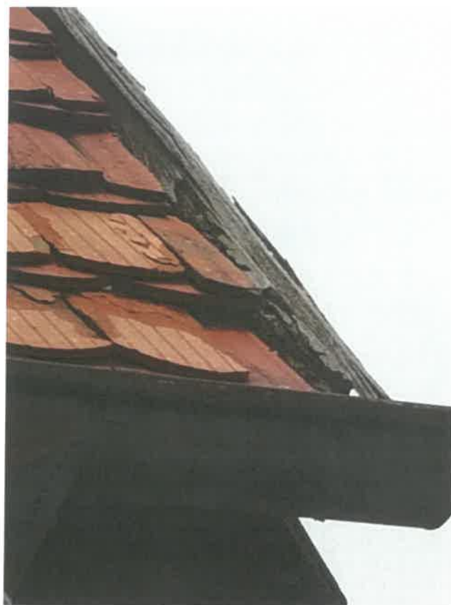
Fot. 32, 33, 34 – Kolejne przykłady zużycia technicznego i uszkodzeń drewna wiatrownic.
