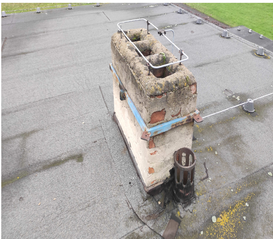
Widoczne spękania tynku na przewodach kominowych wentylacyjnych
