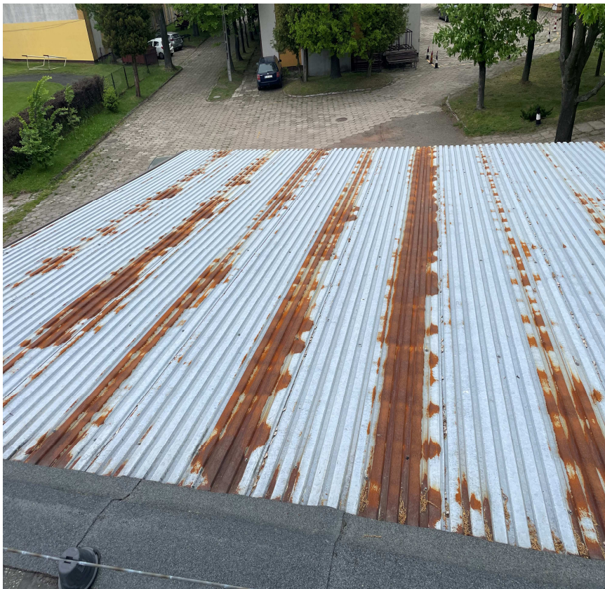
Widoczna korozja dachu stalowego
