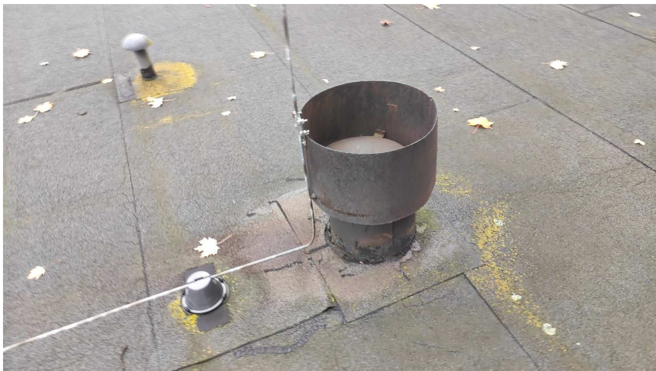
Fot. Widok dachu stalowe kominy wentylacyjne
