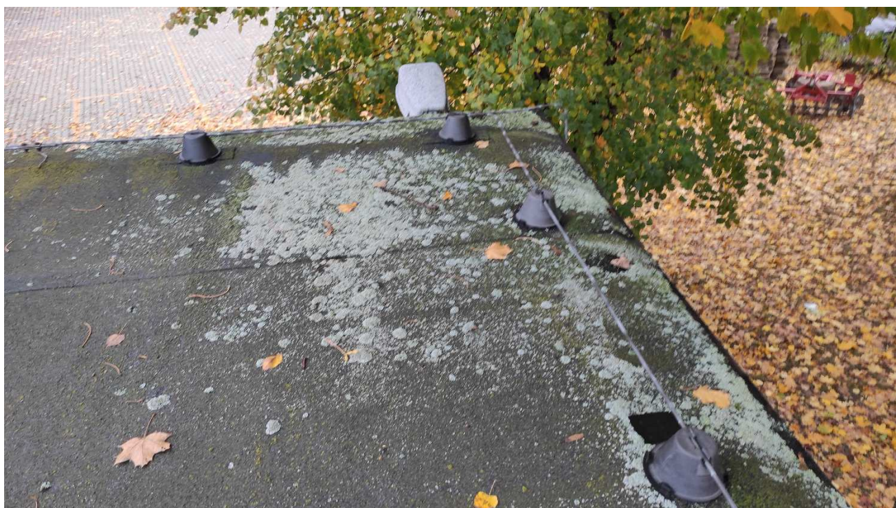
Fot. Widok dachu korozja biologiczna
