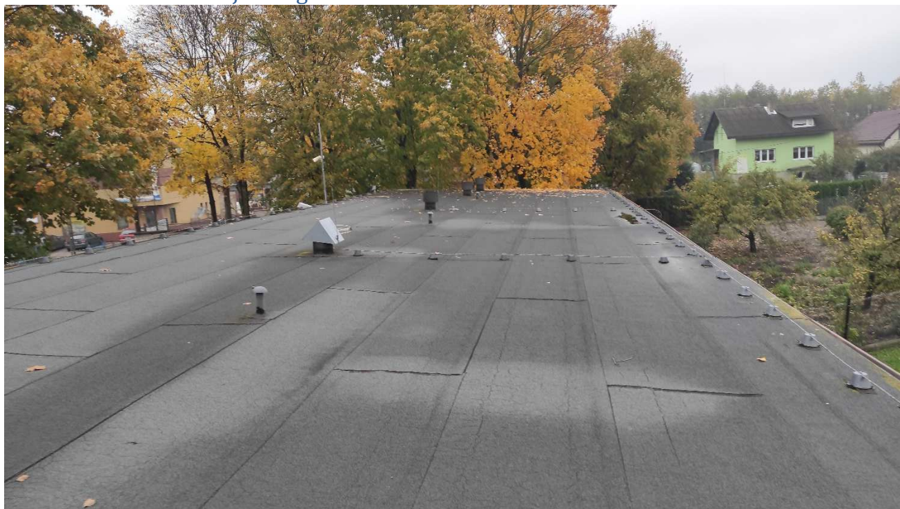
Fot. Widok dachu pokrytego styropapą
