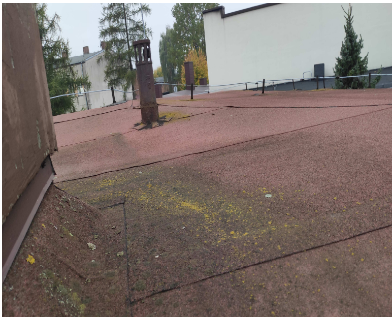
Widoczne odspajanie się papy
