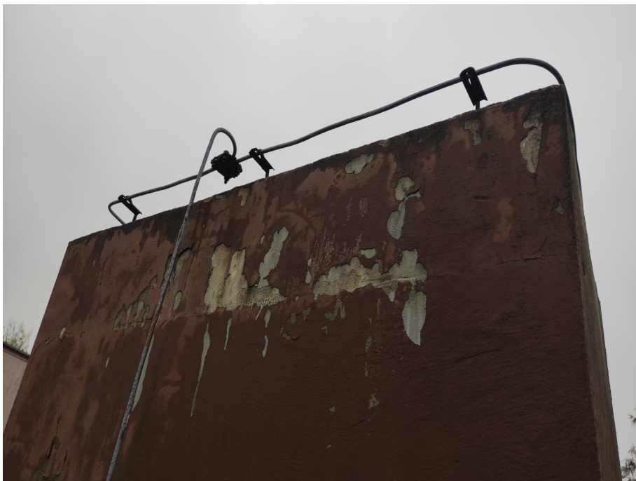
Widoczne odspajanie się tynku od przewodów kominowych
