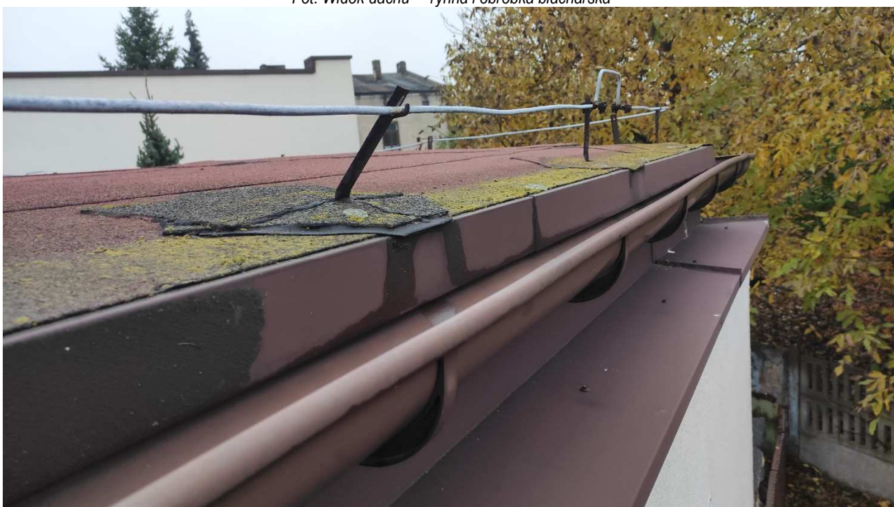
Fot. Widok dachu – instalacja odgromowa
