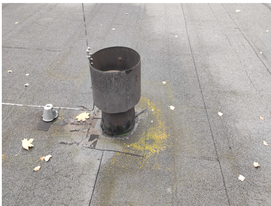
Widoczne nieszczelności przy obróbkach
