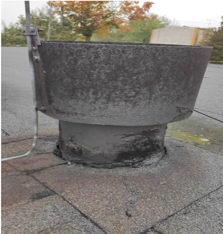
Widoczne nieszczelności przy wywiewzakach
