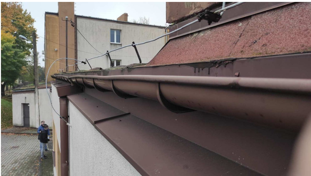
Fot. Widok dachu – rynna i obróbka blacharska
