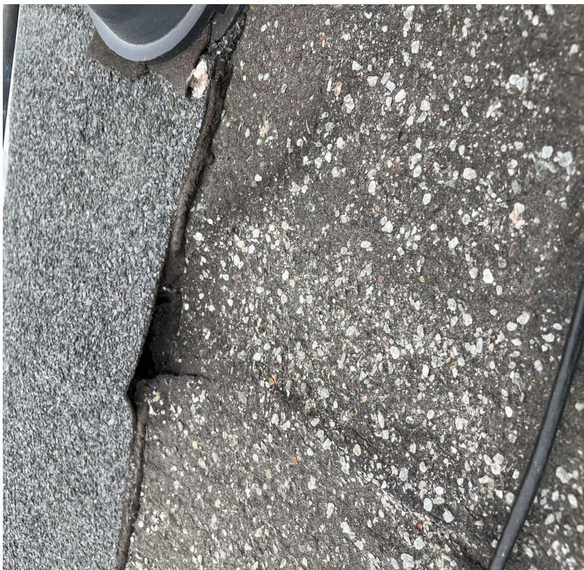
Widoczne nieszczelności w poszyciu.
