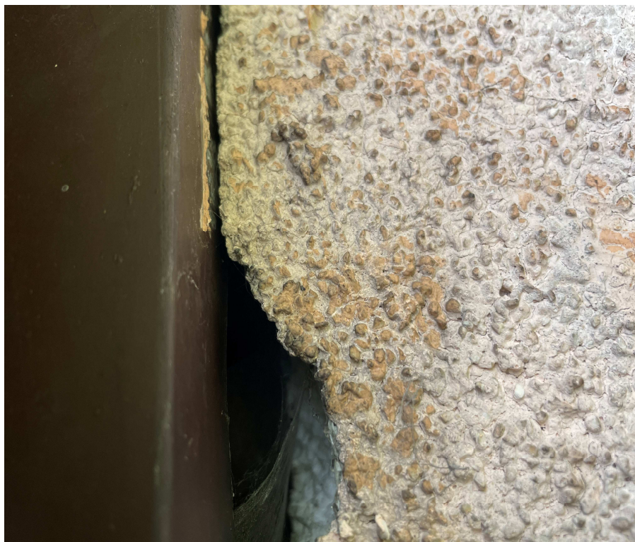
Widoczne nieszczelności przy obróbkach
