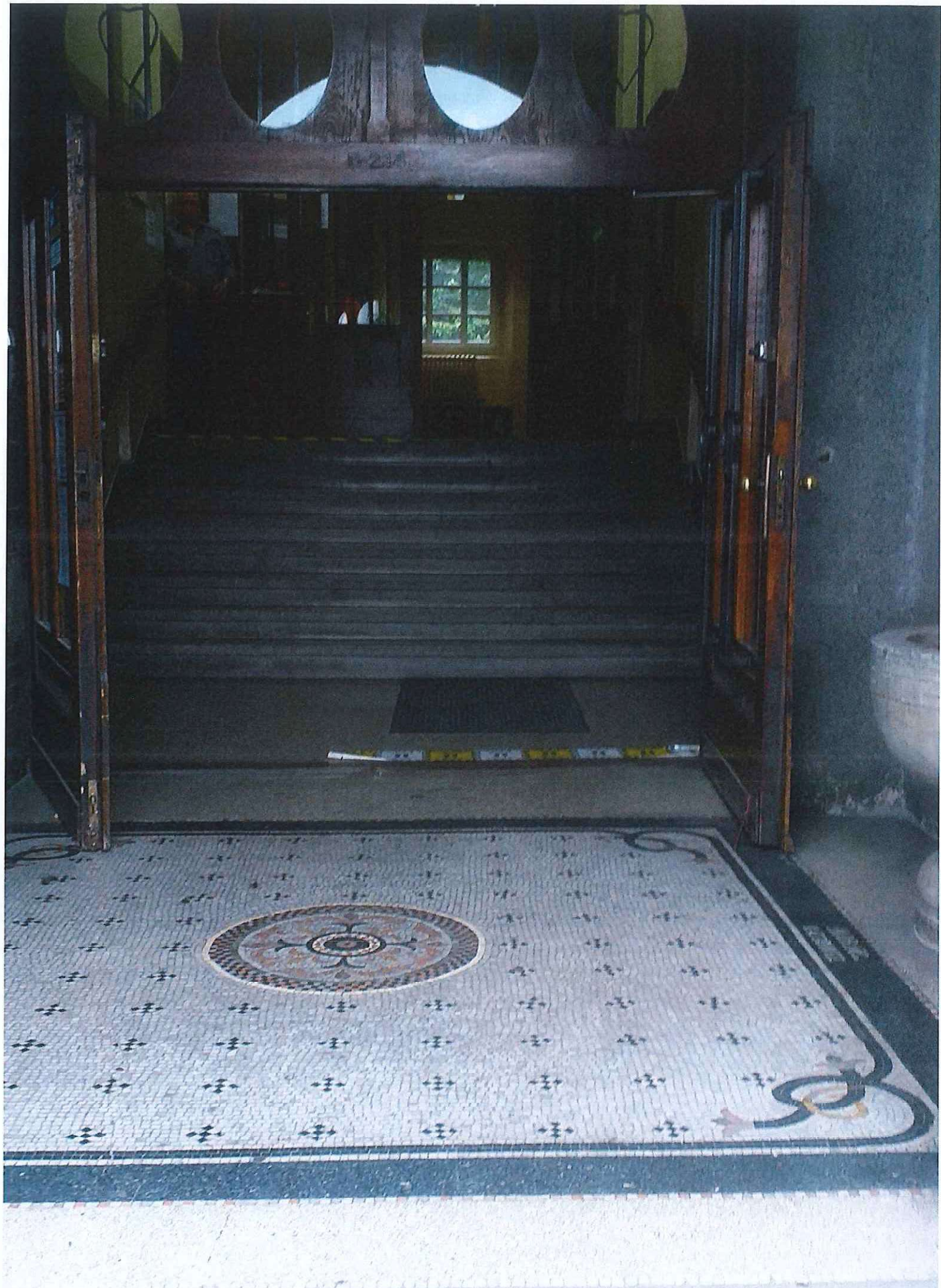
część B' KATOWICE ul. JAGIELONSKA 26-28 SCHODY WEJSCIOWE
