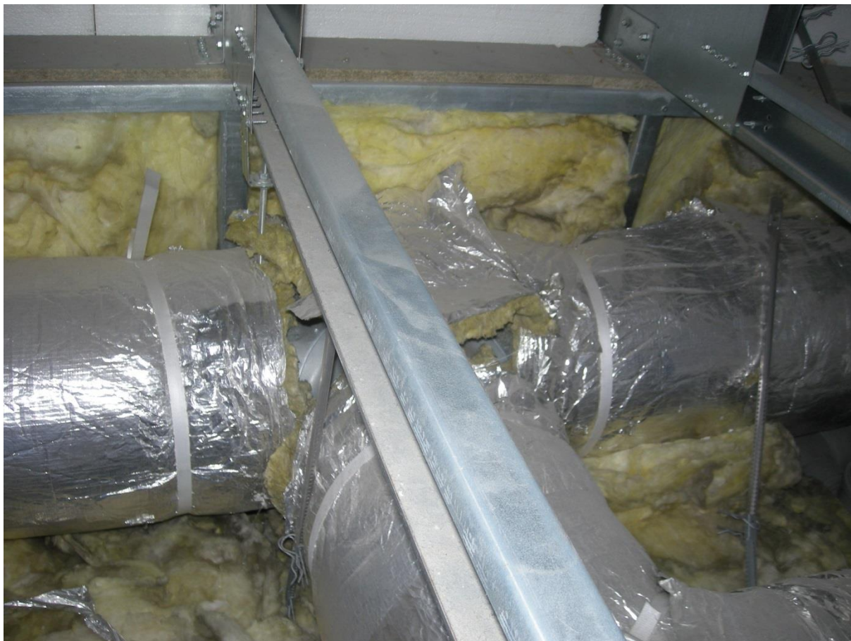
Zdjęcie nr 9. Doszczelnienie połączeń oraz naprawa izolacji na kanale nawiewnym, poddasze.
