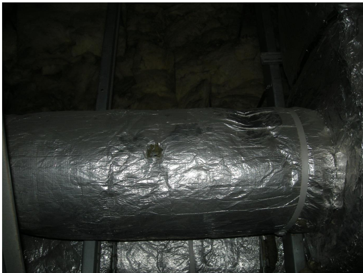
Zdjęcie nr 4. Zalepić taśmą otwór kontrolny po pomiarach wentylacyjnych na poddaszu.
