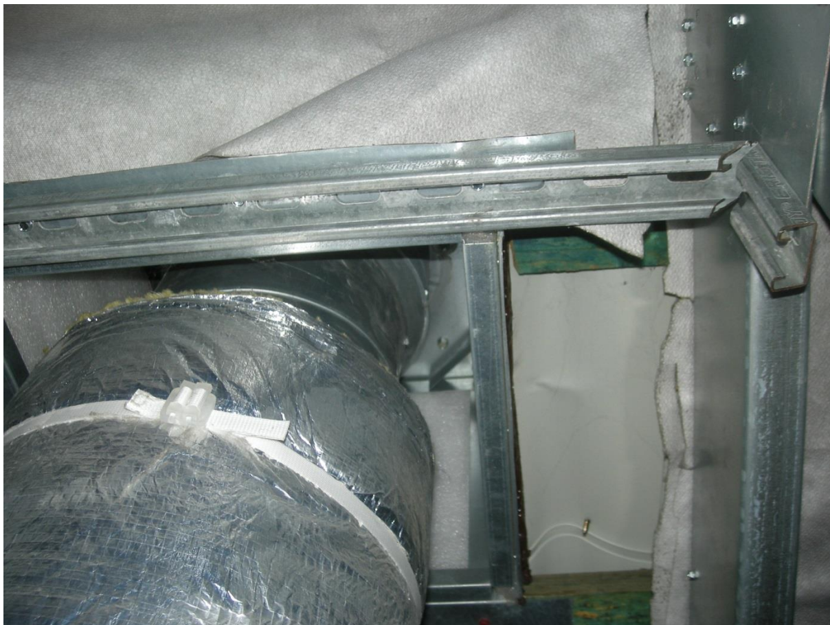
Zdjęcie nr 7. Przejście przez dach wentylatora wywiewnego z toalet. Do założenia izolacja celem uniknięcia wykraplania w zimie.
