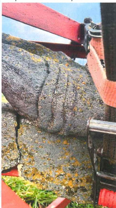
Krucyfiks Babiński. Widoczne pęknięcie krzyża w miejscu łączenia mlekiem cementowym. fot. M. Pytka
