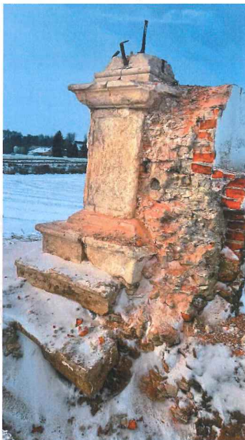
Krucyfiks Babiński. Widok pierwotnego założenia podstawy krzyża w trakcie odsłaniania. Widoczne klamry spajające oraz trzpień mocujący trzon. Stan zachowania gzymsu oraz trzy poziome schody. Widoczny jest także rumosz obudowy. Stan koniec 2023 r. fot. M. Pytko
