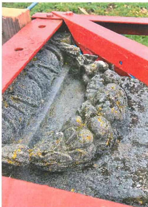
Krucyfiks Babiński. Fragment detalu rzeźbiarskiego głowicy z widocznym silnym rozrostem biologicznym fot. M. Pytka
