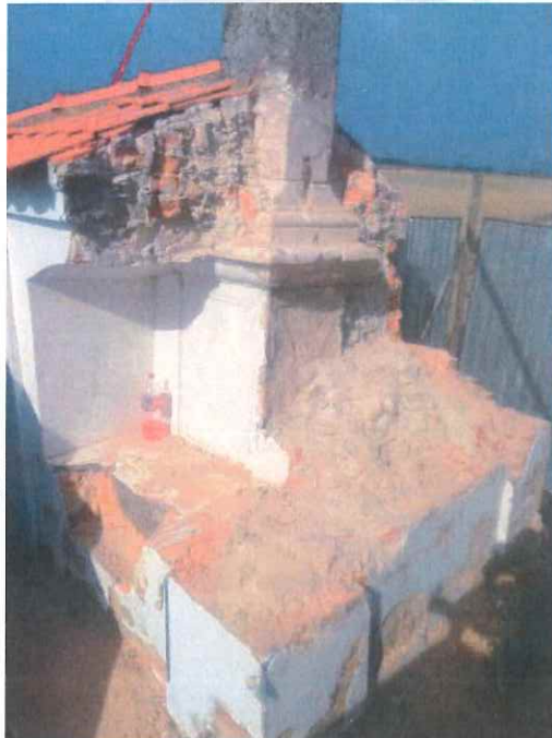
Rozbiórka obudowy podstawy krzyża. Widoczne łączenie trzonu przy pomocy klamer z bazą. Poniżej odsłonięty fragment wydatnego gzymsu oraz masywny cokół z dekoracją rzeźbiarską powierzchni ścian bocznych. Stan koniec 2023 r. fot. M. Pytko
