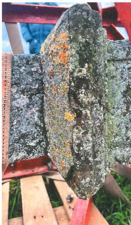
Krucyfiks Babiński. Widoczne łączenia cementowe elementów rzeźbiarskich głowicy. fot. M. Pytko
