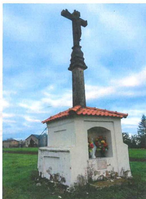
Krucyfiks Babiński wraz z obudowaną dolną częścią w formie kapliczki. Widoczne wychylenie całości w kierunku pn/ zach. orasz dezintegracja obudowy. fot. M. Pytko
