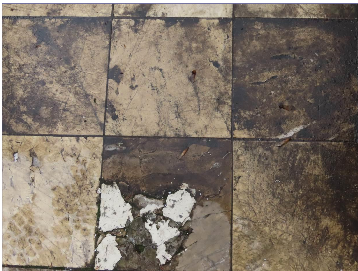
kity naprawcze na płytkach, degradacja strukturalna kamieniarki
