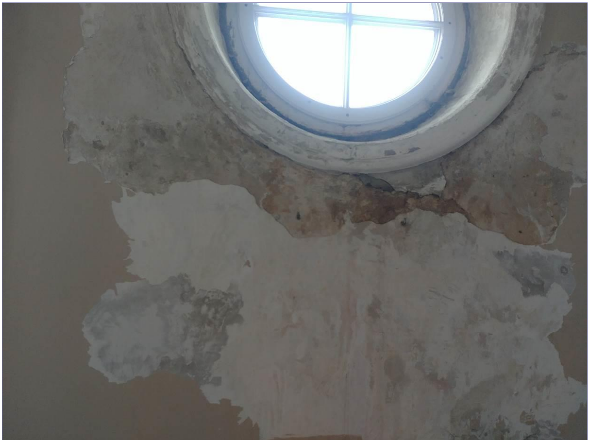
uszkodzenia tynków elewacji boniowanych spowodowanych zalewaniem tarasu od góry
