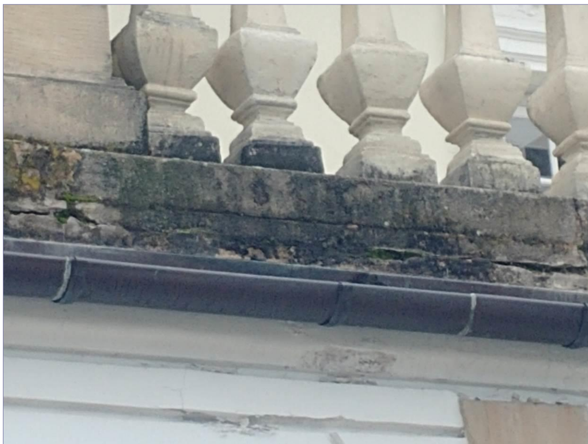
balustrada – różnice kolorystyczne tralek kamiennych i wykonanych z betonu, ponadto korozja biologiczna, zawilgocenie, spękania i braki kamieniarki (podestu), naprawy z cementem
