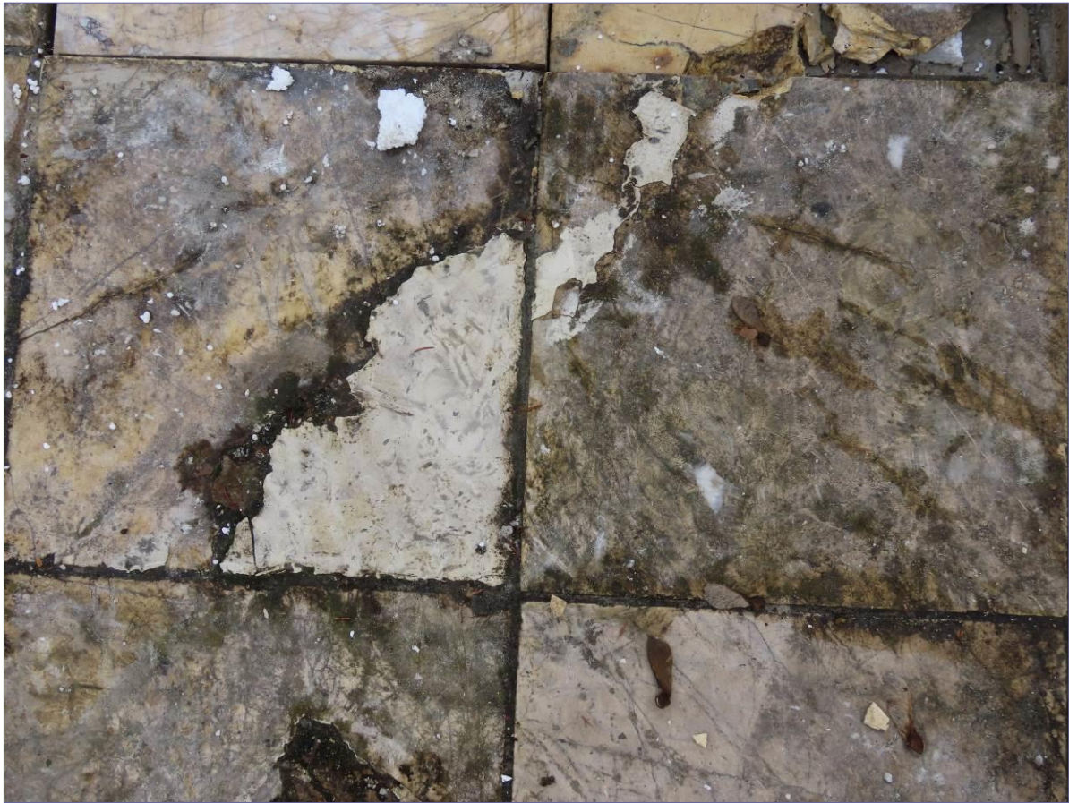
kity naprawcze na płytkach, degradacja strukturalna kamieniarki, liczne podciekanie wody powodujące odspojenia płytek, lokalnie doraźnie naprawiane
