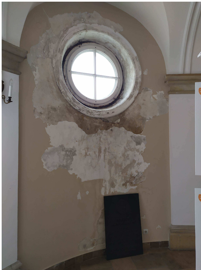
Fot. nr 7 Uszkodzenie ściany wewnętrznej przy oknie
