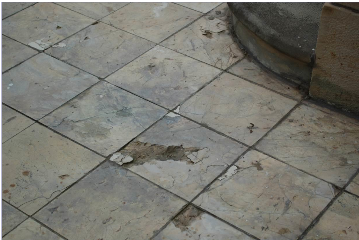
kity naprawcze na płytkach, degradacja strukturalna kamieniarki
