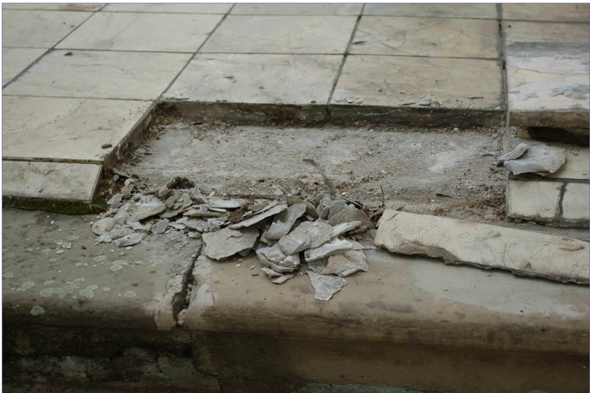
kity naprawcze na płytkach, degradacja strukturalna kamieniarki, liczne podciekanie wody powodujące odspojenia płytek, lokalnie doraźnie naprawiane
