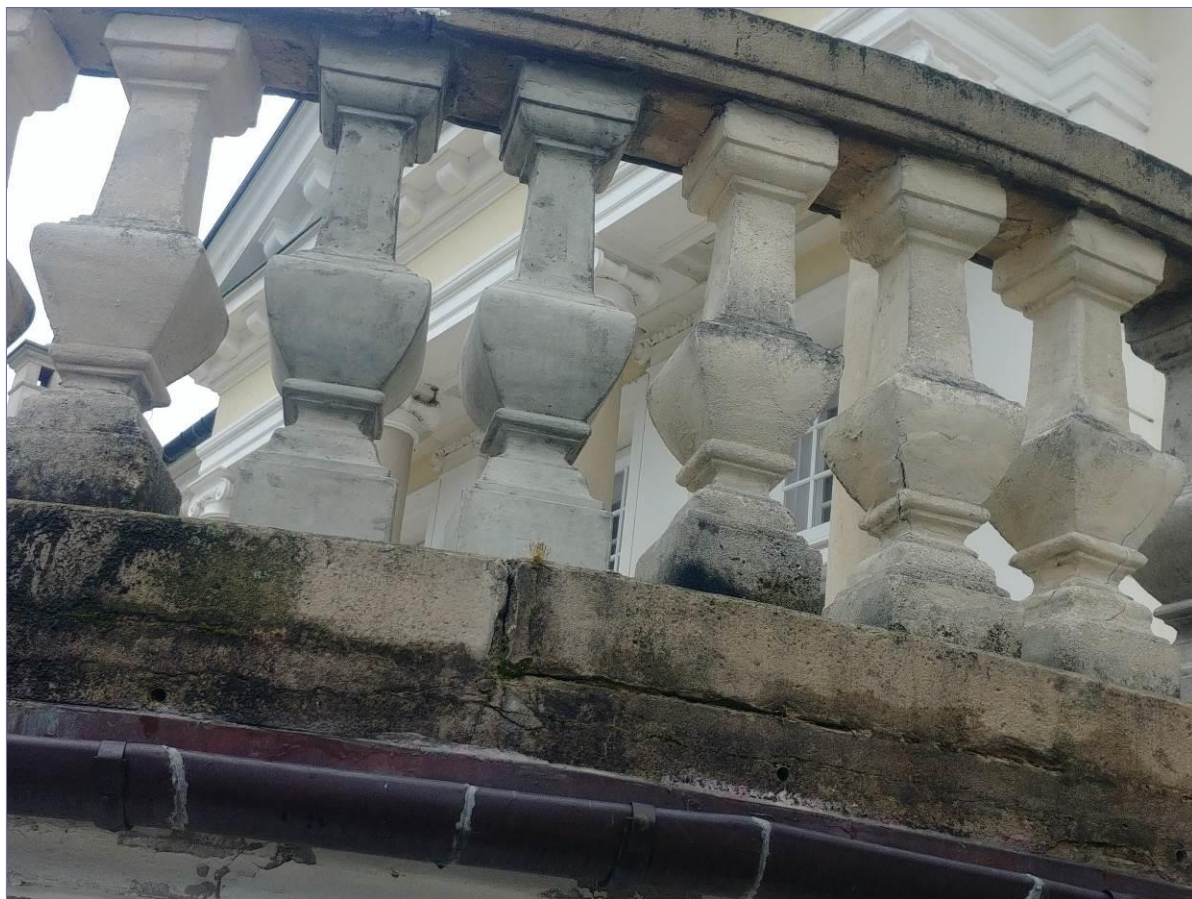
balustrada – różnice kolorystyczne tralek kamiennych i wykonanych z betonu, ponadto korozja biologiczna, zawilgocenie, spękania i braki kamieniarki (podestu), naprawy z cementem
