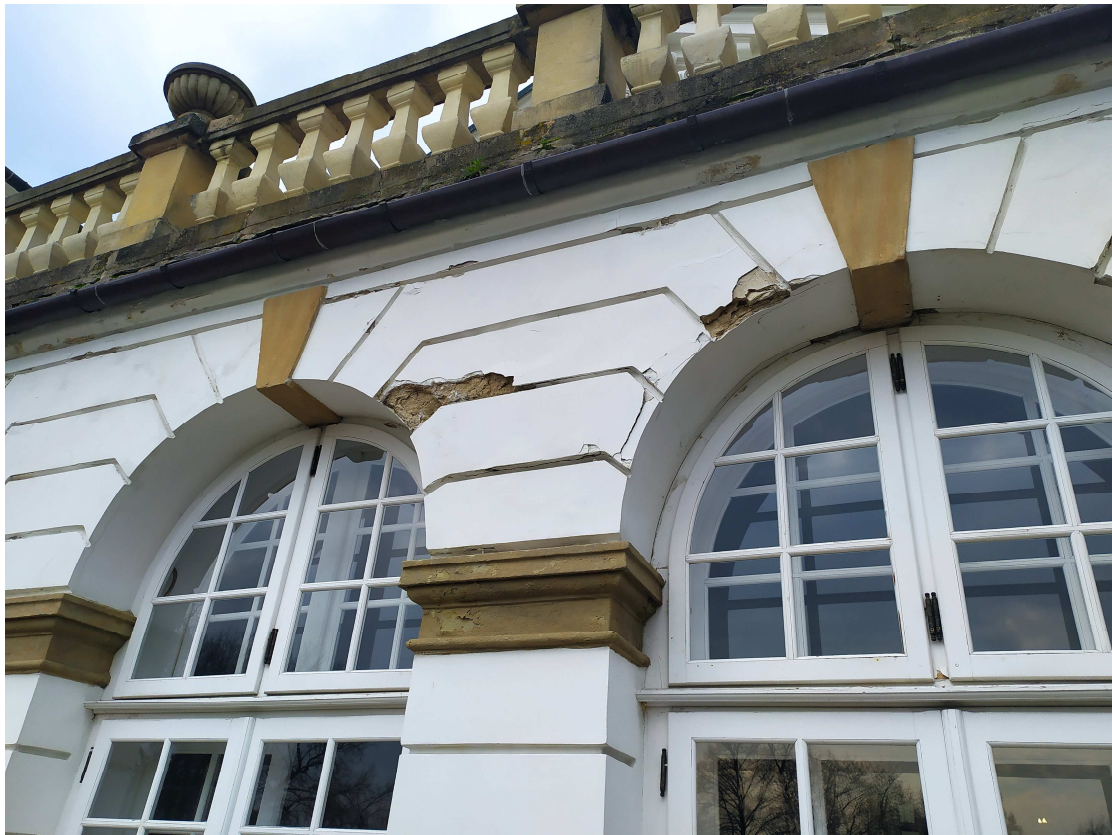
Fot. nr 6 Uszkodzenie ściany zewnętrznej
