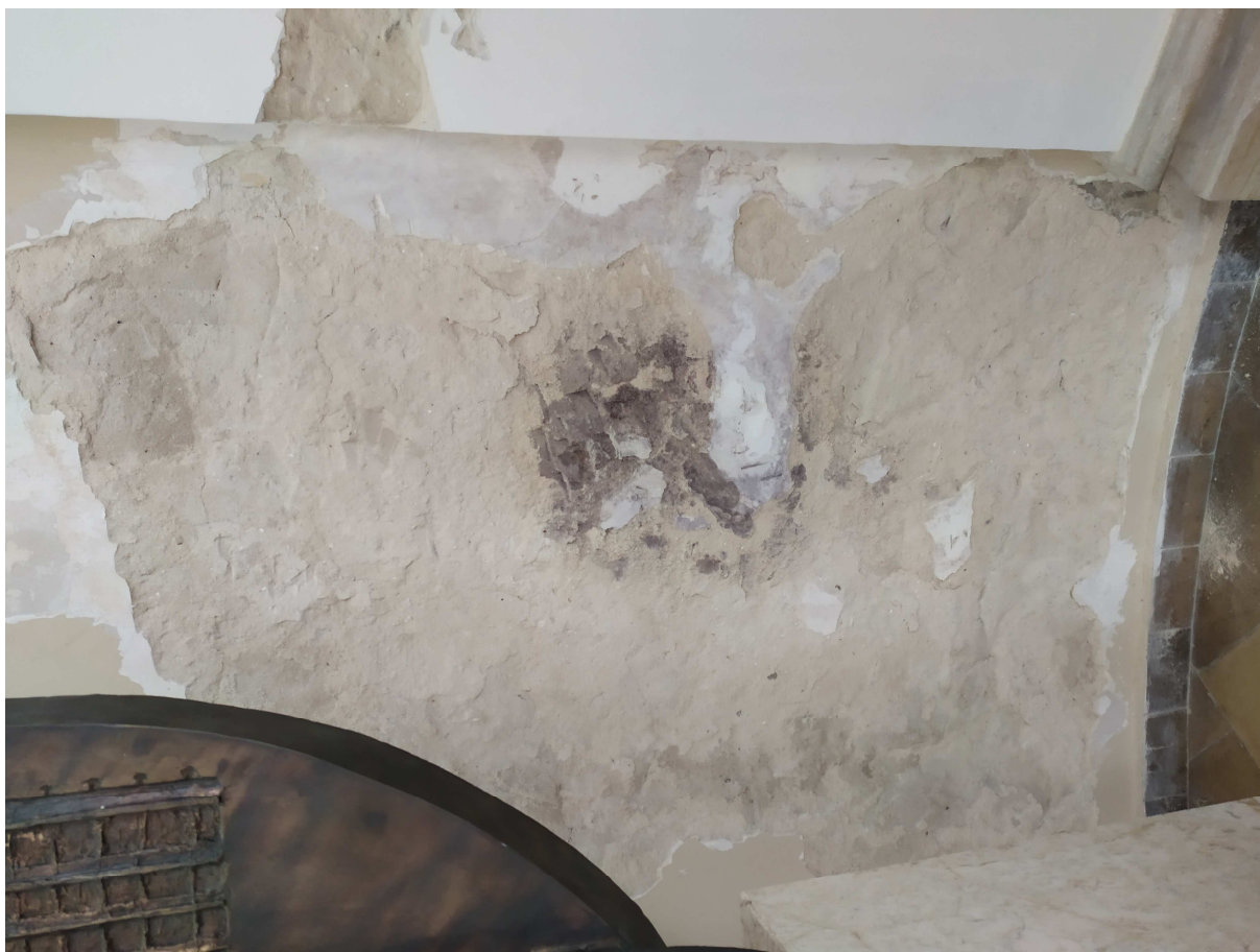
Fot. nr 2 Uszkodzenie tynku na stropie
