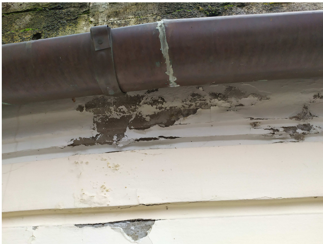
Fot. nr 4 Uszkodzenie rynny
