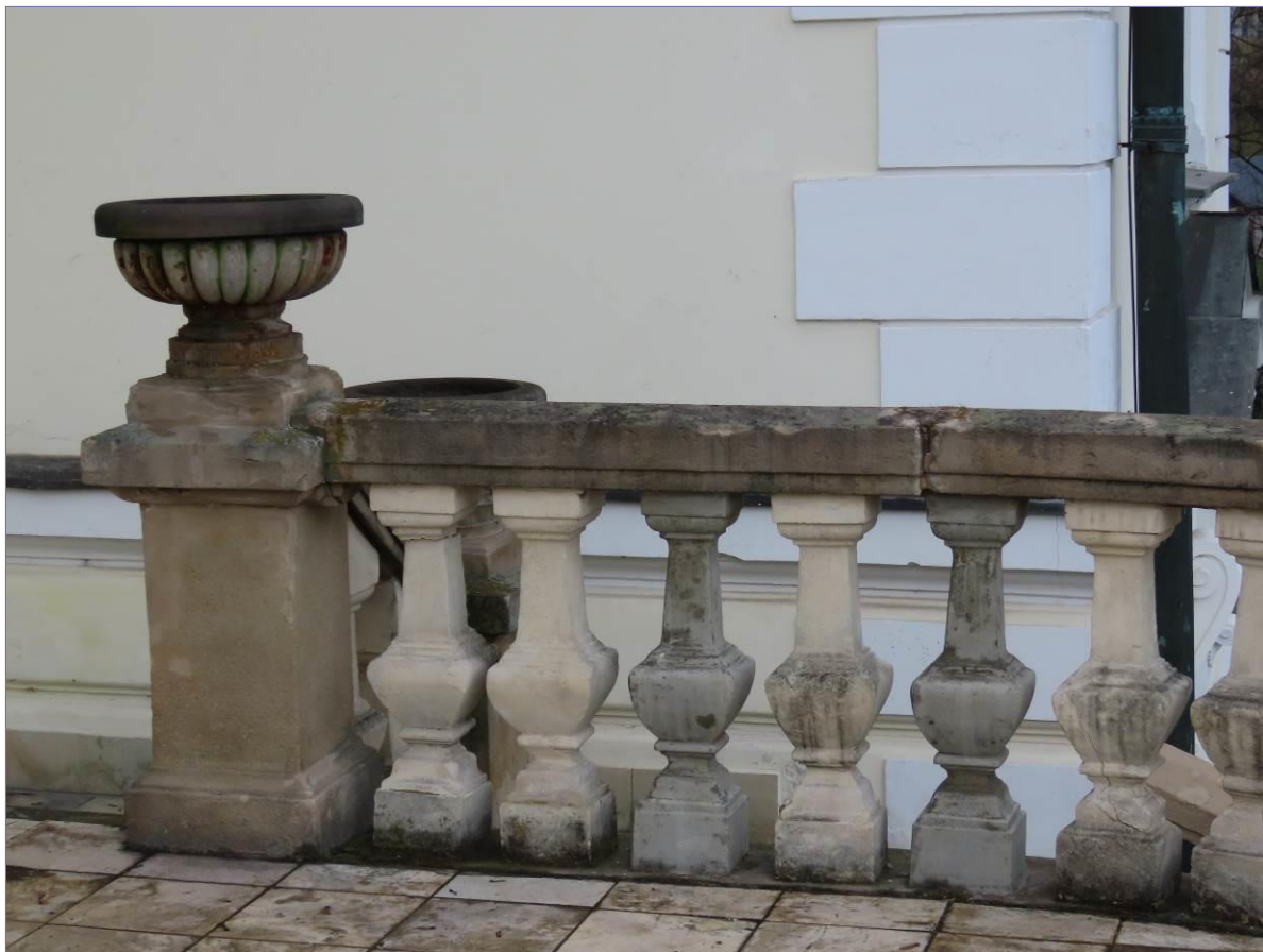
widoczne szare cementowe odlewy nowych tralek w balustradzie na tarasie; widoczne zmiany kolorystyczne kitów, liczne spękania i wżery na powierzchniach postumentów tralek, korozja biologiczna kamieniarki - zielone i czarne
