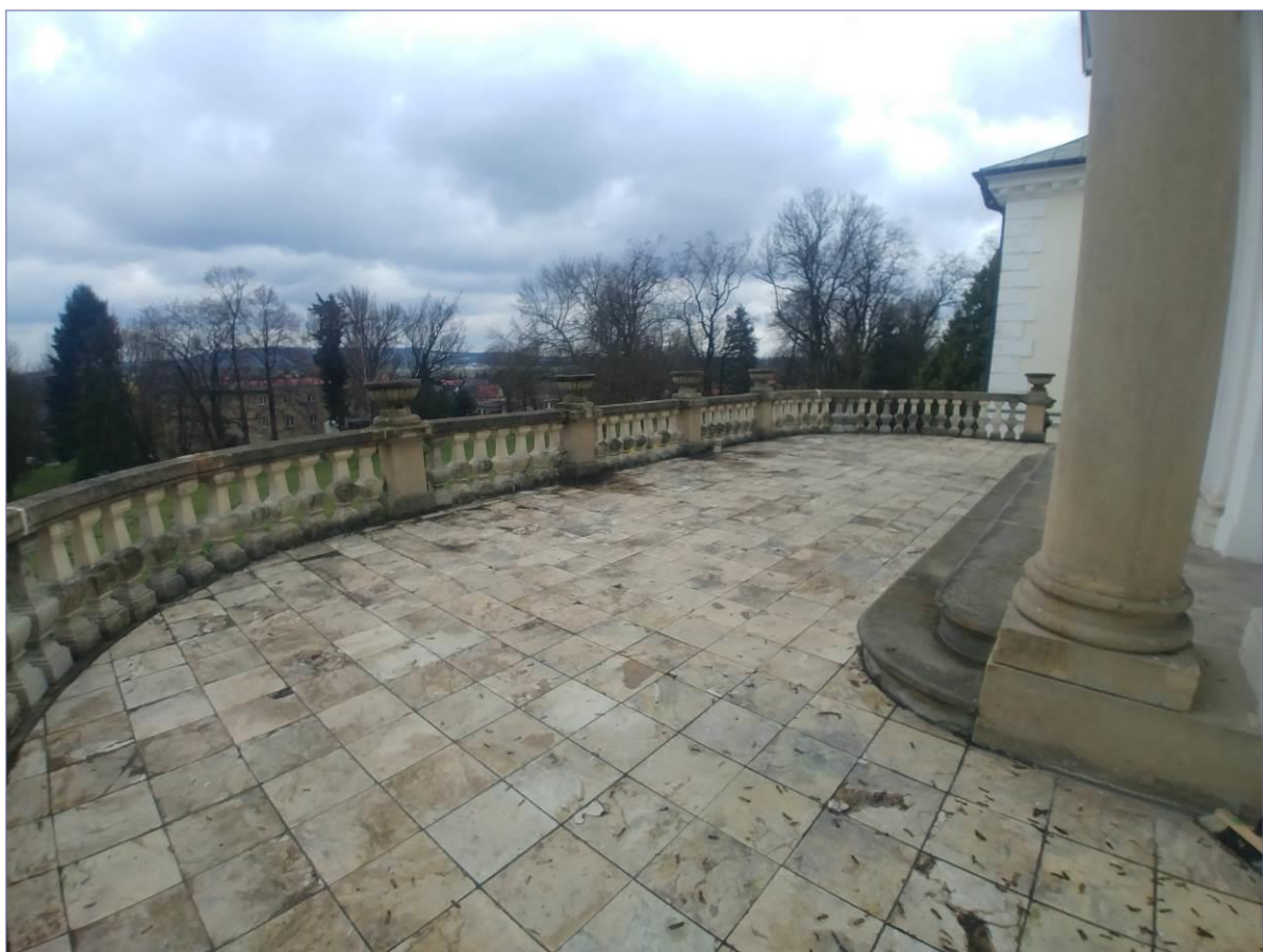
uszkodzenia kamieniarki, zabrudzenie, korozja – stan ogólny
