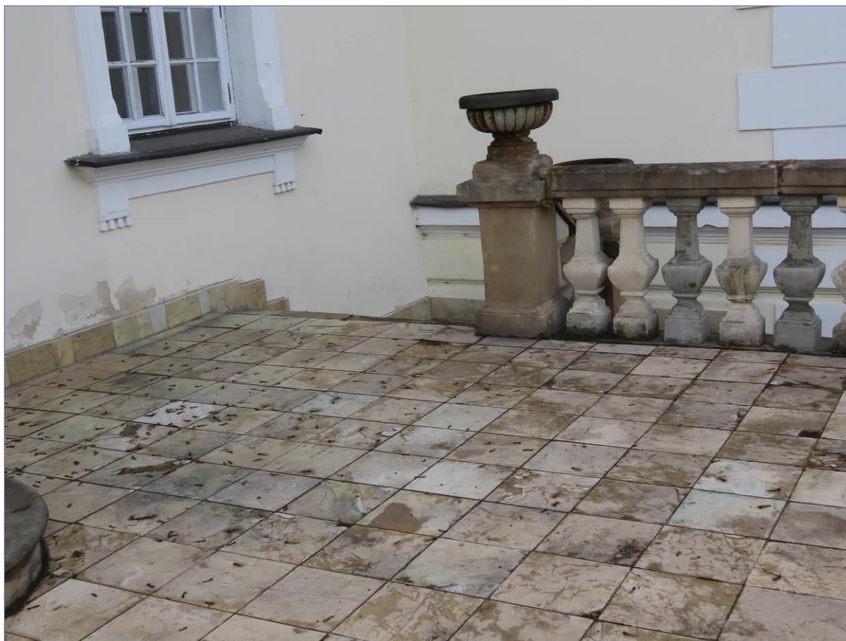
widoczne liczne niteczkowate spękania płyt mogące wpływać na zalewnie wewnątrz westybulu, zniszczone spoiny
