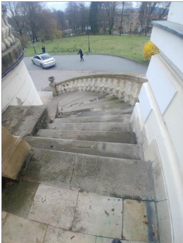
uszkodzenia kamieniarki, zabrudzenie, korozja – stan ogólny
