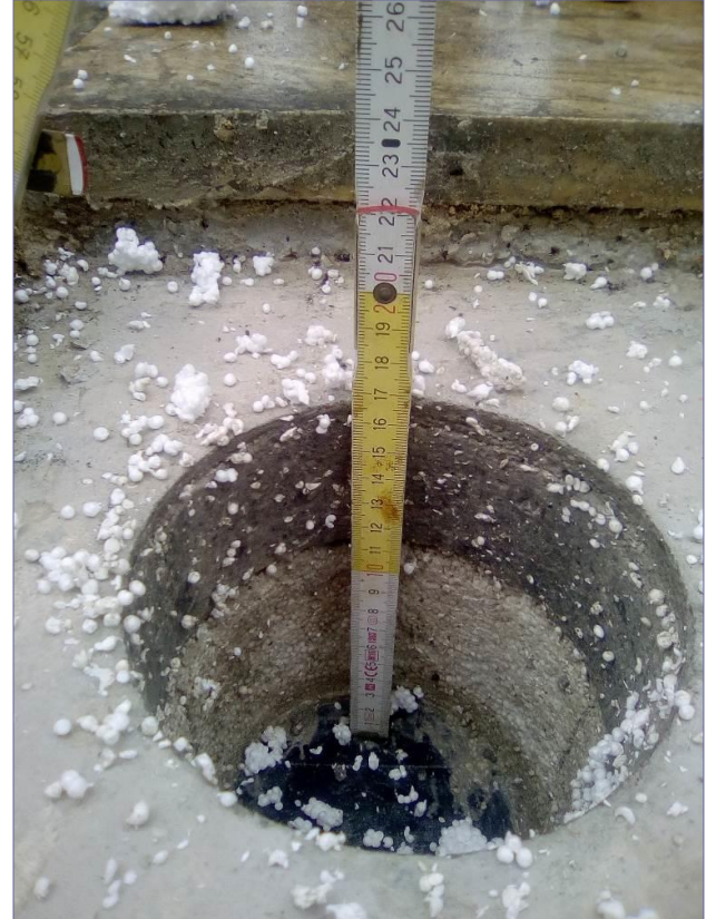
odkrywki warstw podkładowych
