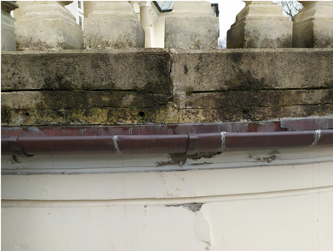
Fot. nr 5 Niewłaściwe zamontowanie rynny
