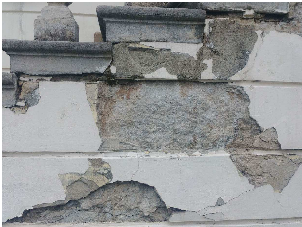
Fot. nr 8 Uszkodzenie ściany zewnętrznej przy schodach
