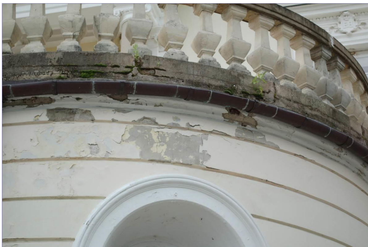
uszkodzenia tynków elewacji boniowanych spowodowanych zalewaniem tarasu od góry
