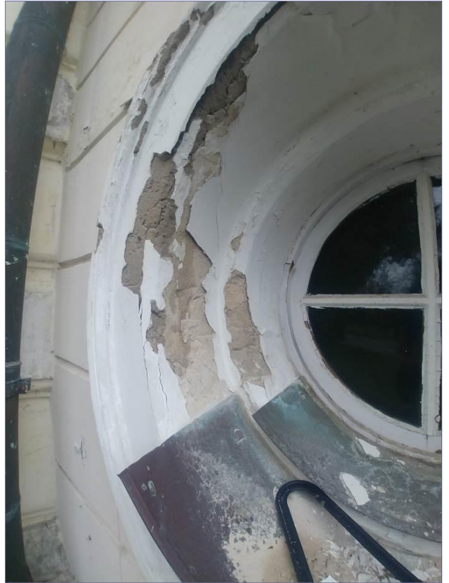
uszkodzenia tynków elewacji boniowanych spowodowanych zalewaniem tarasu od góry
