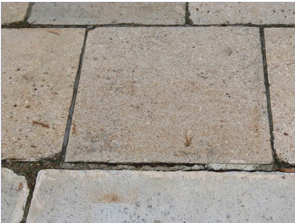
ubytki krawędzi płyt; lekkie zabrudzenie kamienia; sztywne cementowe zaprawy z ubytkami oraz braki spoin; w ubytkach zgromadzony piasek gruz i warstwy mchów
