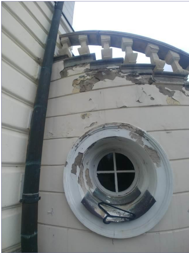
uszkodzenia tynków elewacji boniowanych spowodowanych zalewaniem tarasu od góry
