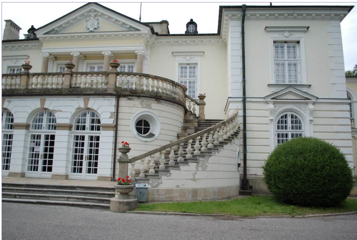
schody wachlarzowe - odpadanie tynków na elewacjach widoczne zawilgocone z korozją biologiczną
