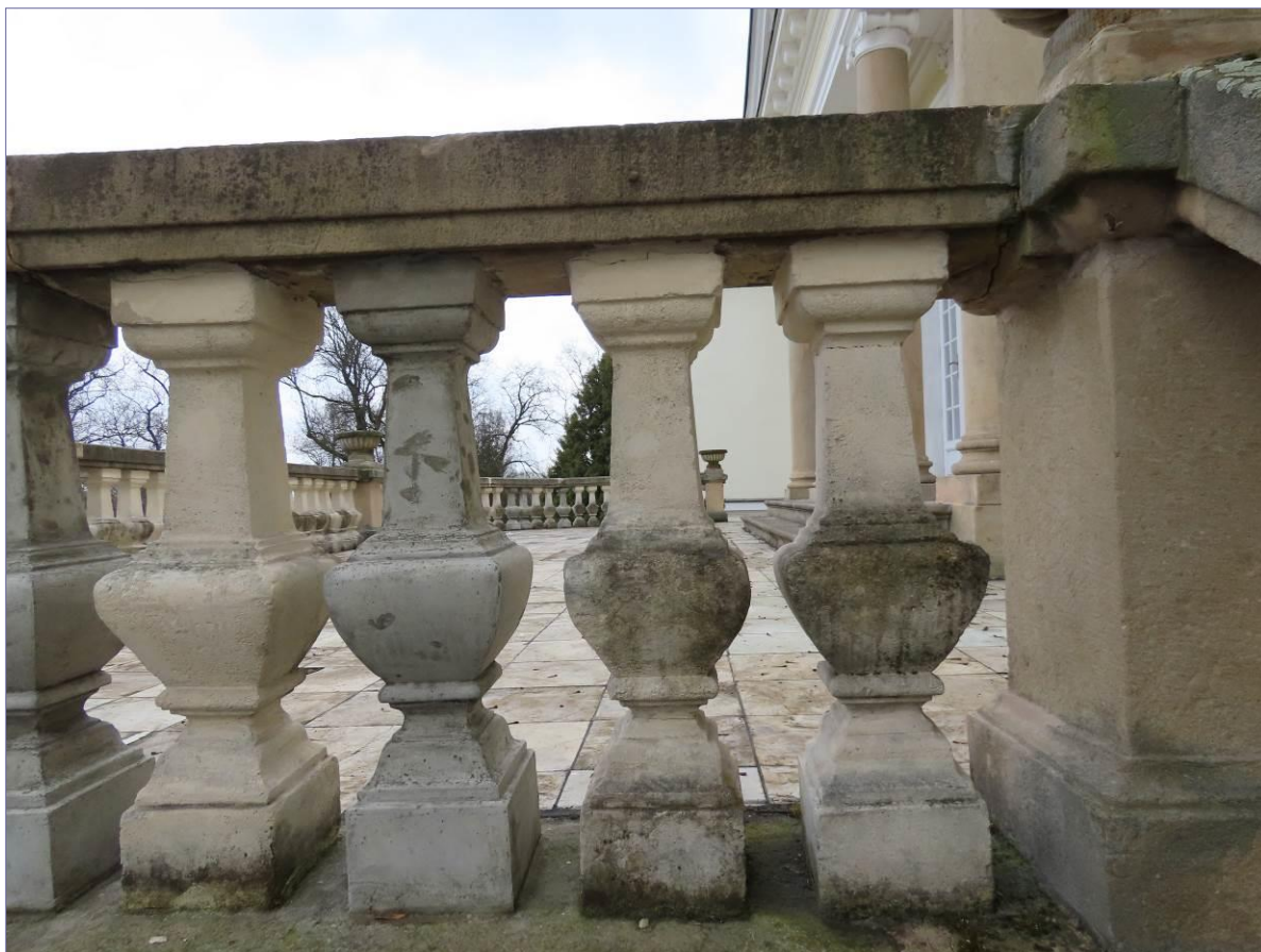
widoczne szare cementowe odlewy nowych tralek w balustradzie na tarasie; widoczne zmiany kolorystyczne kitów, liczne spękania i wżery na powierzchniach postumentów tralek, korozja biologiczna kamieniarki - zielone i czarne
