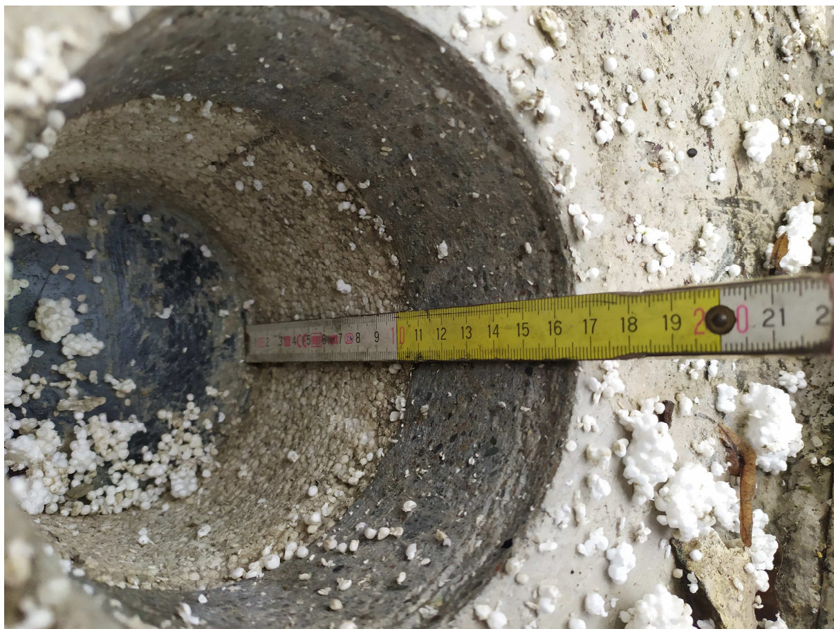
Fot. nr 2 Przekrój warstw na tarasie westybule
