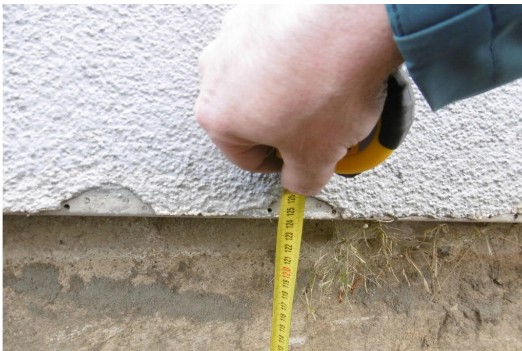
Fot. 10 – Widok ściany cokołowej
