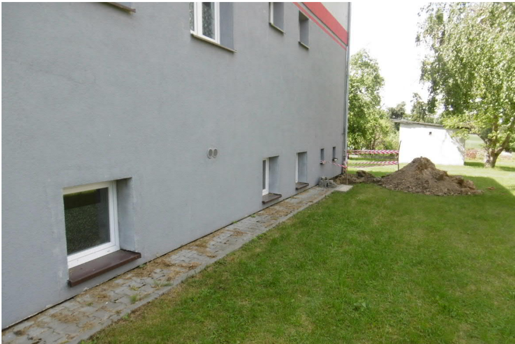
Fot. 4 – Widok elewacji bocznej (wschodniej)
