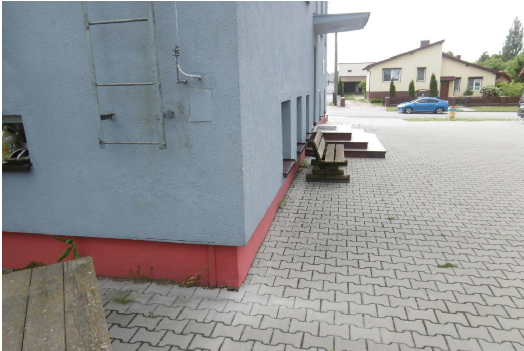
Fot. 3 – Widok elewacji bocznej (zachodniej)
