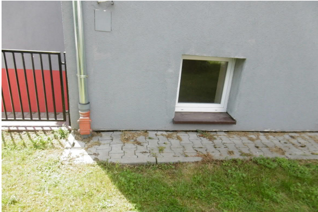
Fot. 7 – Widok izolacji ścian fundamentowych
