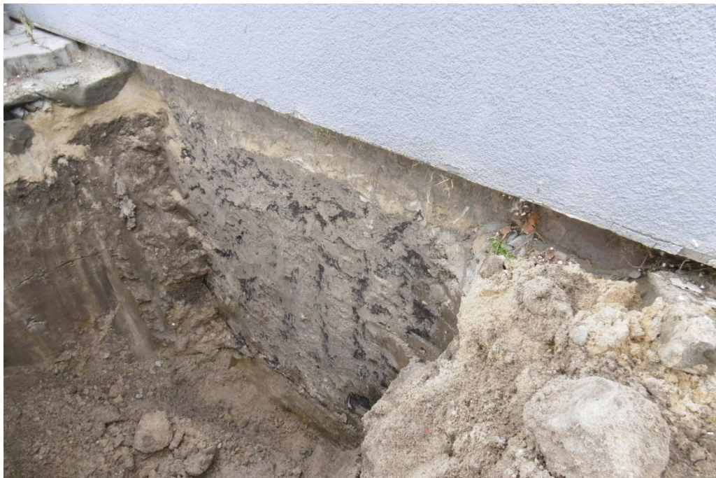
Fot. 8 – Widok izolacji ścian fundamentowych
