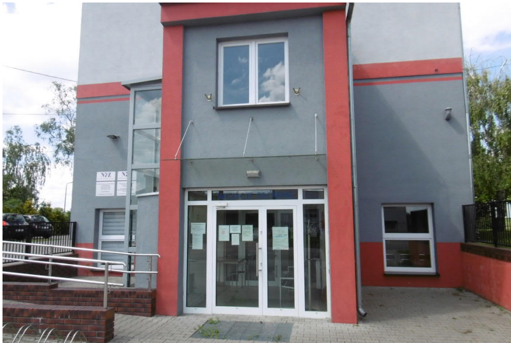
Fot. 1 – Widok elewacji frontowej (południowej)
