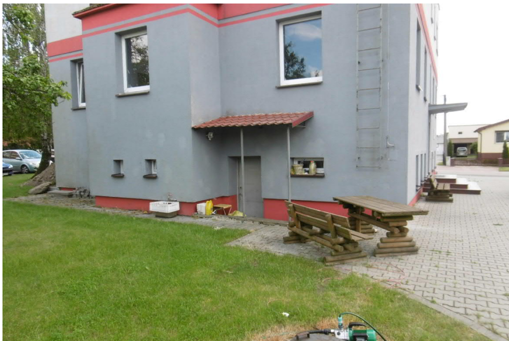
Fot. 2 – Widok elewacji tylnej (północnej)
