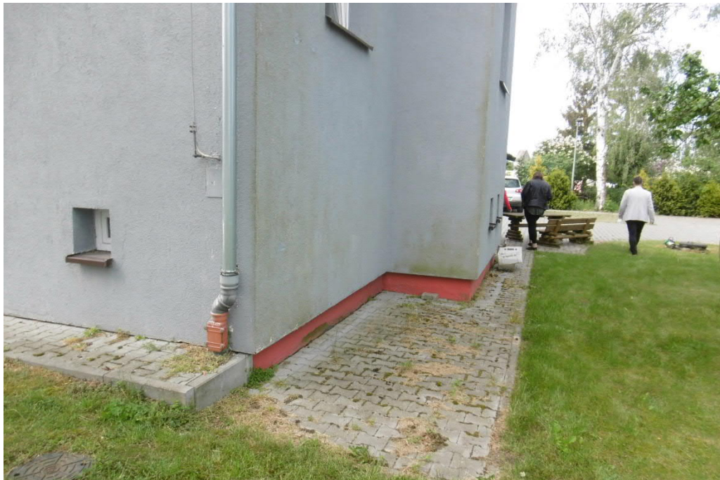
Fot. 5 – Widok elewacji tylnej (północno-wschodniej)
