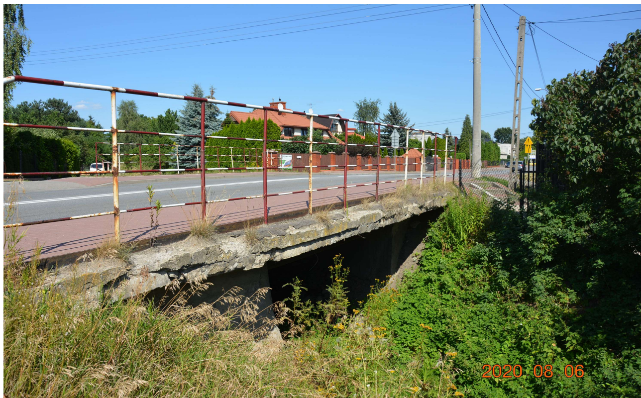
Widok ogólny obiektu mostowego
