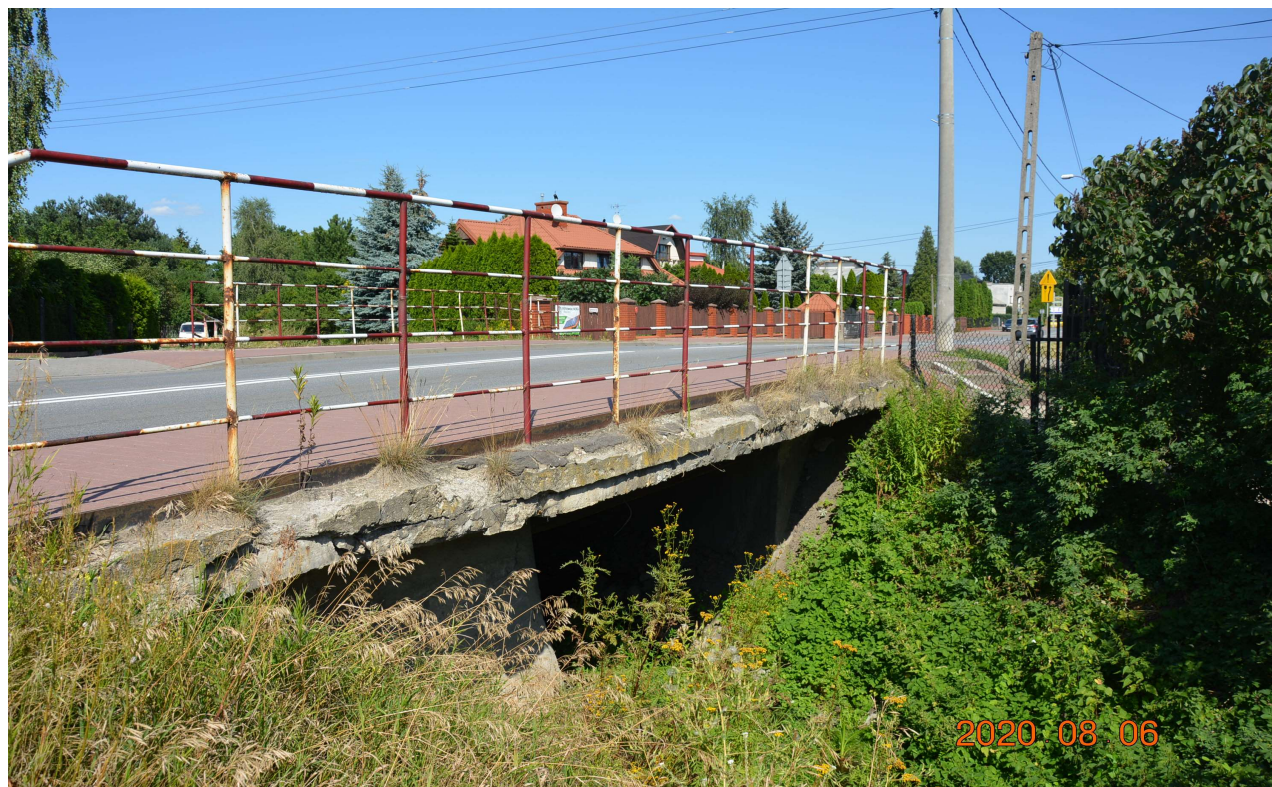
Fot. 3. Widok z boku od strony wody górnej.
