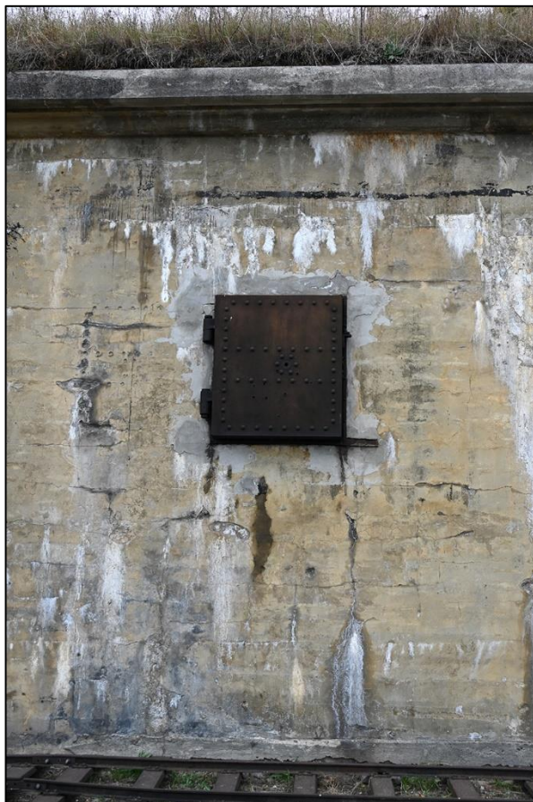
Fot. 11. Fot. 12. Stalowa, skorodowana okiennica; wokół okiennicy reperacje i uzupełnienia ubytków.
