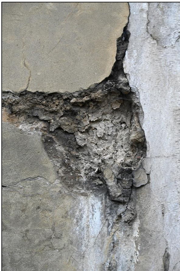
Fot. 20. Fot. 21. Zdegradowany, rozsypujący się mur betonowy.
