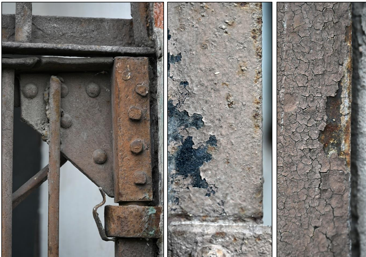
Fot. 29. Fot. 30. Fot. 31. Zawias górny bramy i wtórnie dospawany pręt. W ubytkach grubych i spękanych przemalowań widoczny skorodowany metal i, prawdopodobnie, oryginalne czarne wymalowanie.
