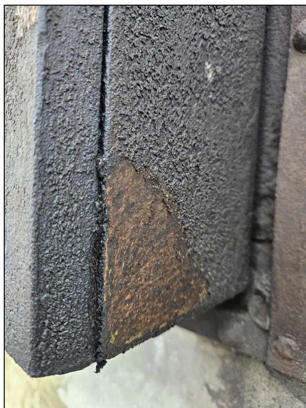
Fot. 51. Fot. 52. W ubytkach grubych i spękanych przelawień widoczny skorodowany metal i, prawdopodobnie, oryginalne czarne wymalowanie. Fragment okiennicy systematycznie „zabezpieczanej” olejem.
