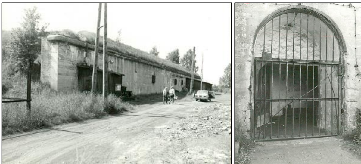
Fot. 1. Fot. 2. Historyczne fotografie frontu prochowni i kraty wejściowej; widoczne jeszcze zachowane stalowe obramienie otworu po stronie lewej.
