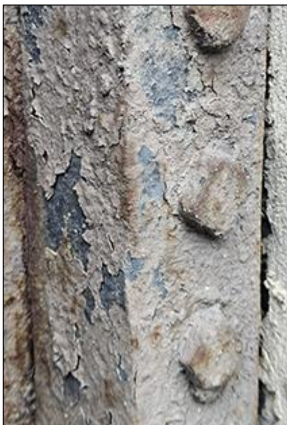
Fot. 51. Fot. 52. W ubytkach grubych i spękanych przelawień widoczny skorodowany metal i, prawdopodobnie, oryginalne czarne wymalowanie. Fragment okiennicy systematycznie „zabezpieczanej” olejem.
