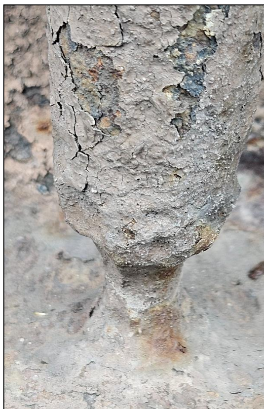
Fot. 48. Fot. 49. Silnie skorodowane dolne części prętów. Łuszczące się przemalowania, korozja i resztki czarnego wymalowania.
