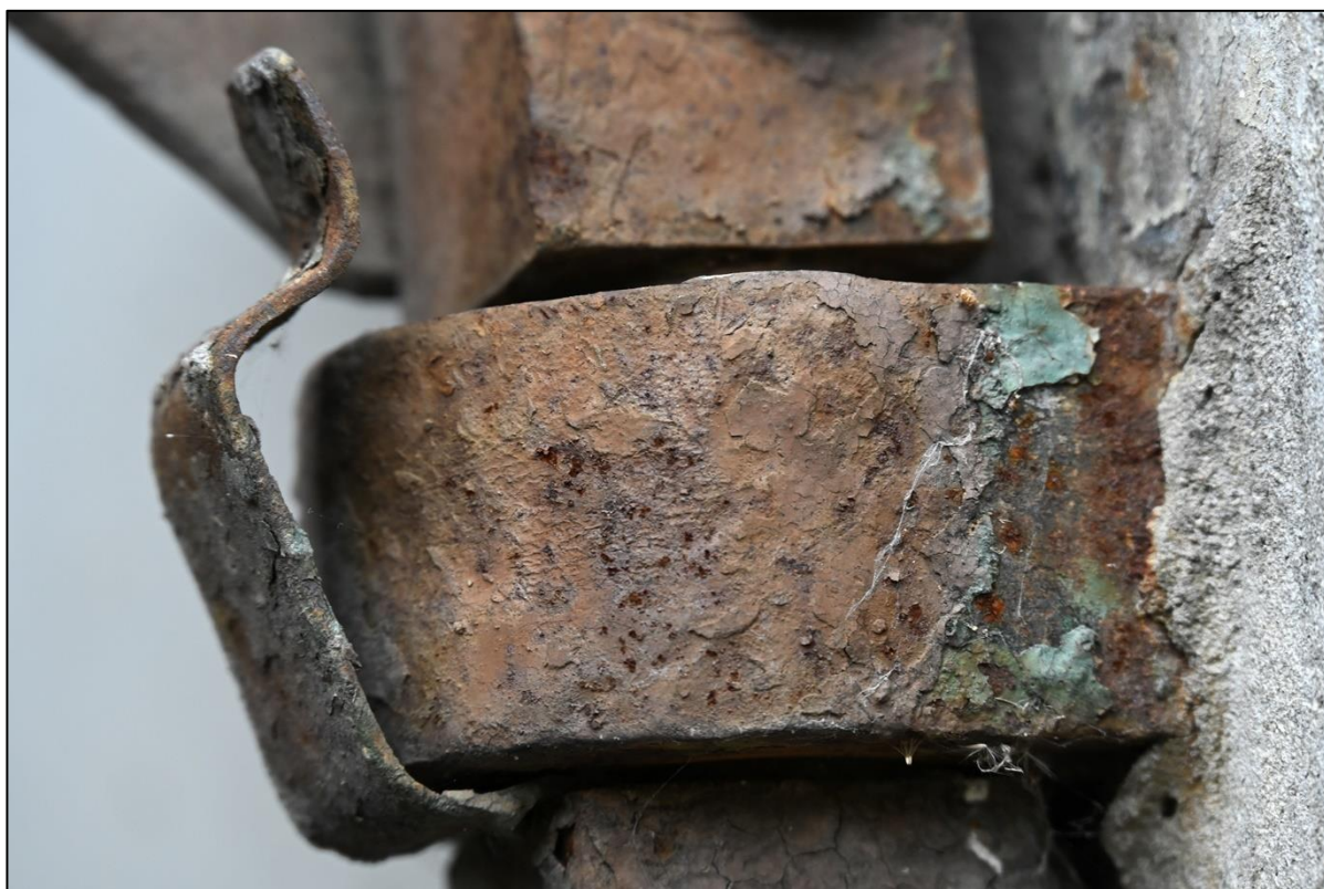
Fot. 32. Zawias górny montowany w murze.
