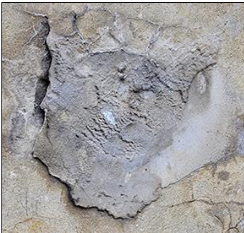
Fot. 22. Fot. 23. Reperacja uszkodzenia muru – niestarannie wypełniony ubytek.
