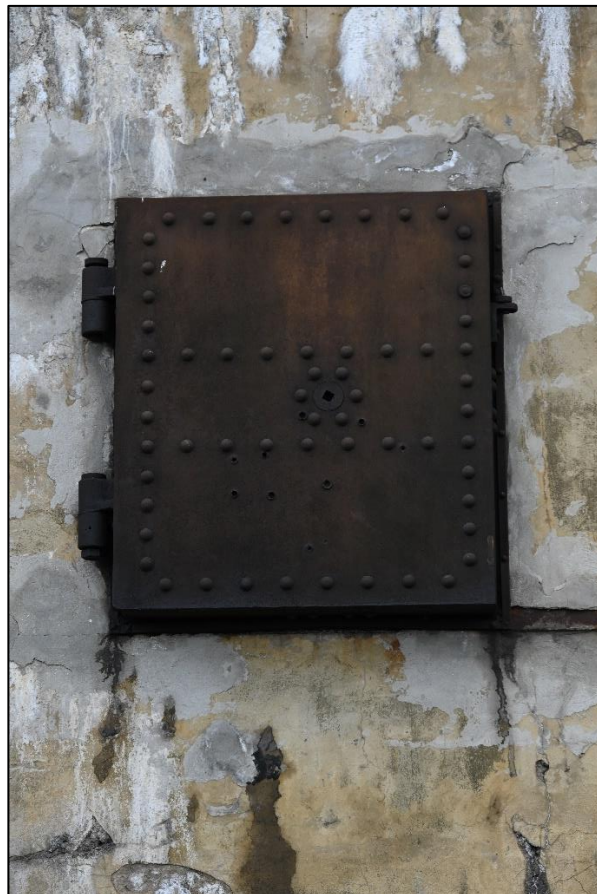
Fot. 11. Fot. 12. Stalowa, skorodowana okiennica; wokół okiennicy reperacje i uzupełnienia ubytków.
