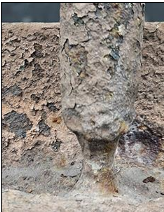
Fot. 48. Fot. 49. Silnie skorodowane dolne części prętów. Łuszczące się przemalowania, korozja i resztki czarnego wymalowania.
