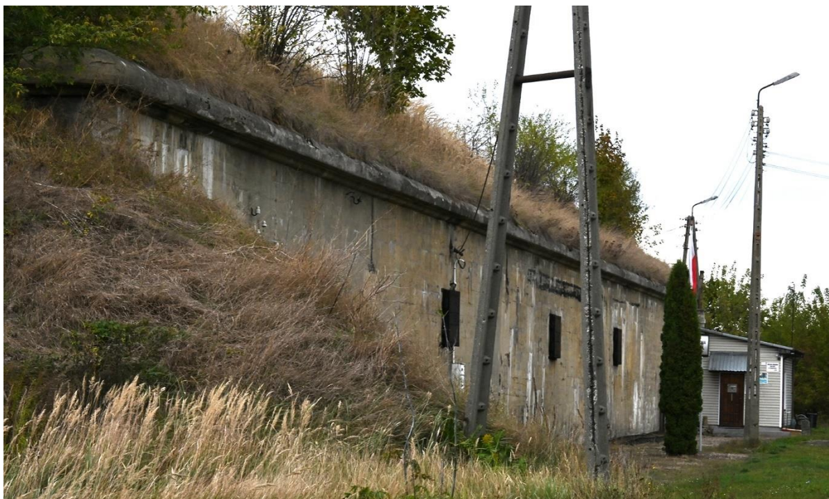
Fot. 6. Widok elewacji prochowni od strony południowo-zachodniej.
