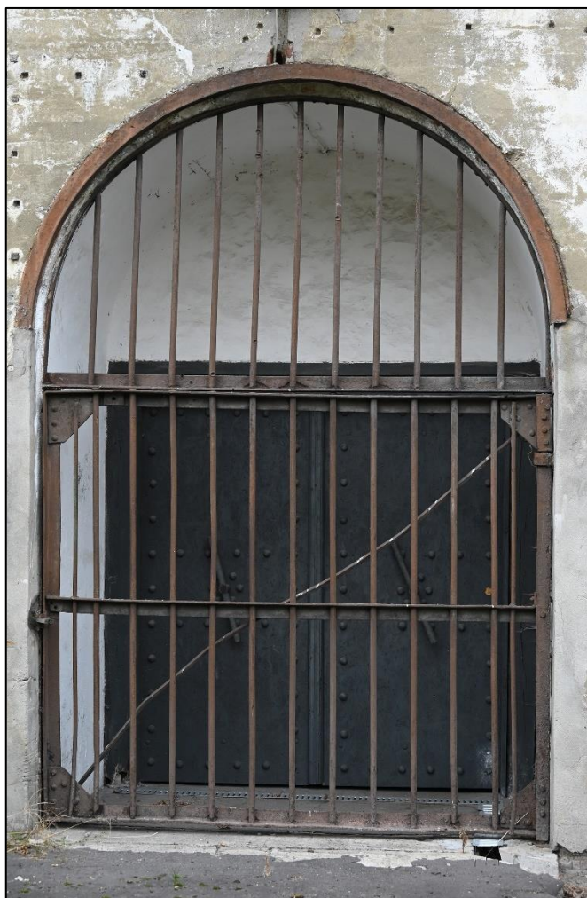
Fot. 25. Fot. 26. Krata z wtórnie dodanymi prętami; w głębi stalowe drzwi pancerne.. Wokół wejścia ślady po zdemontowanej instalacji elektrycznej. Miejsce po zdemontowanym, pionowym kątowniku obramienia otworu wypełnione zaprawą.
