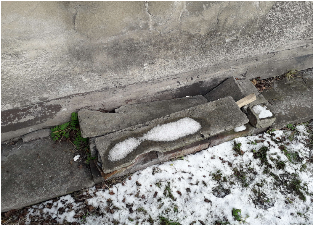
Rys. nr 14. Zniszczone klapy – zakrycia okien piwnic od strony frontu. [1.3]
