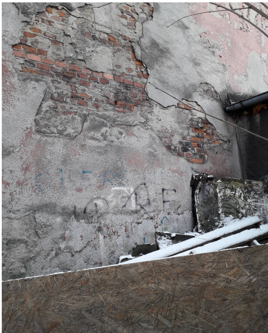
Rys. nr 6. Odparzenia tynku – elewacja szczytowa. [1.3]
