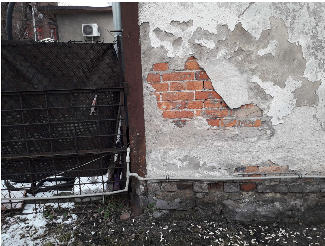
Rys. nr 13. Odparzenia tynku, wypłukanie zaprawy cementowo-piaskowej z muru. [1.3]
