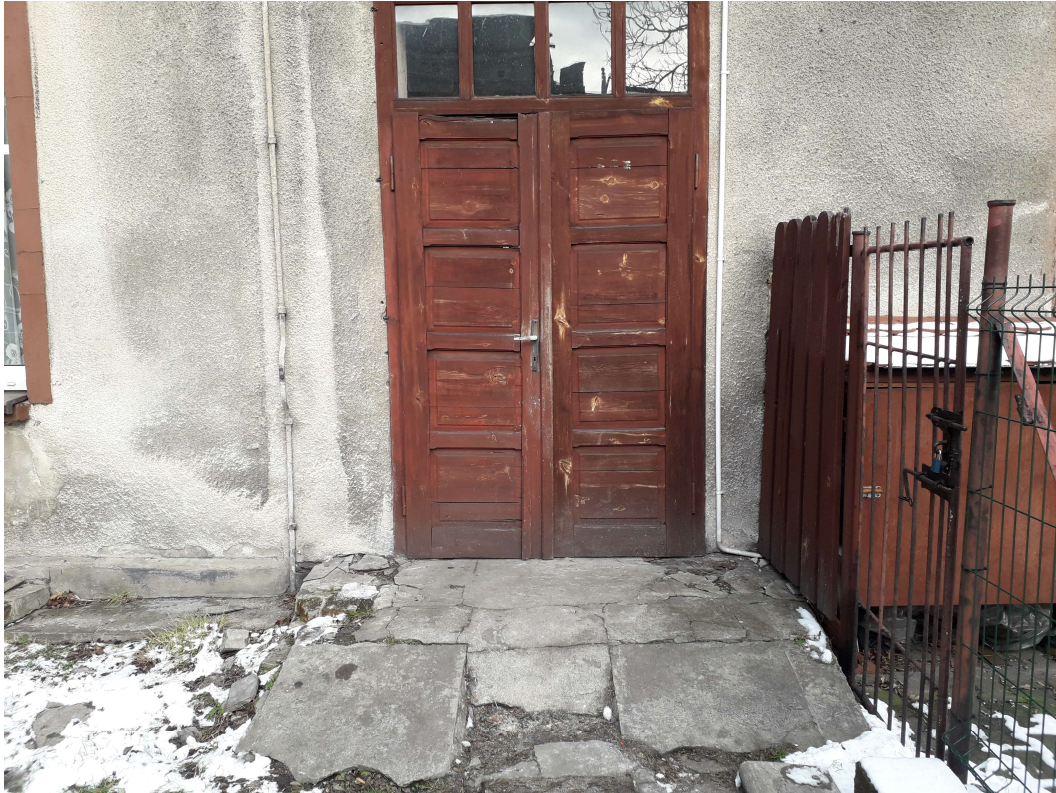
Rys. nr 12. Znacznie wyeksploatowane zewnętrzne drzwi wejściowe od strony frontu oraz brak estetyki wejścia – popękana i wykruszona konstrukcja podestu wejściowego. [1.3]
