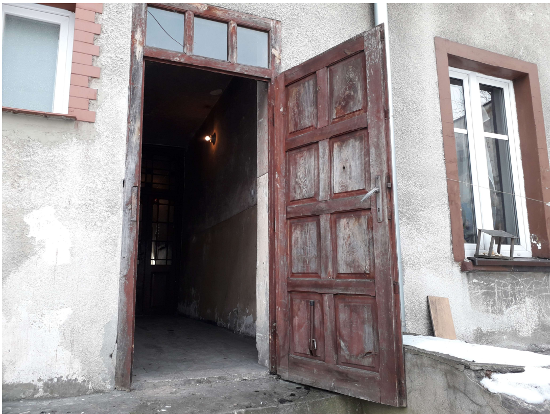
Rys. nr 9. Znacznie wyeksploatowane zewnętrzne drzwi wejściowe od strony podwórza. [1.3]
