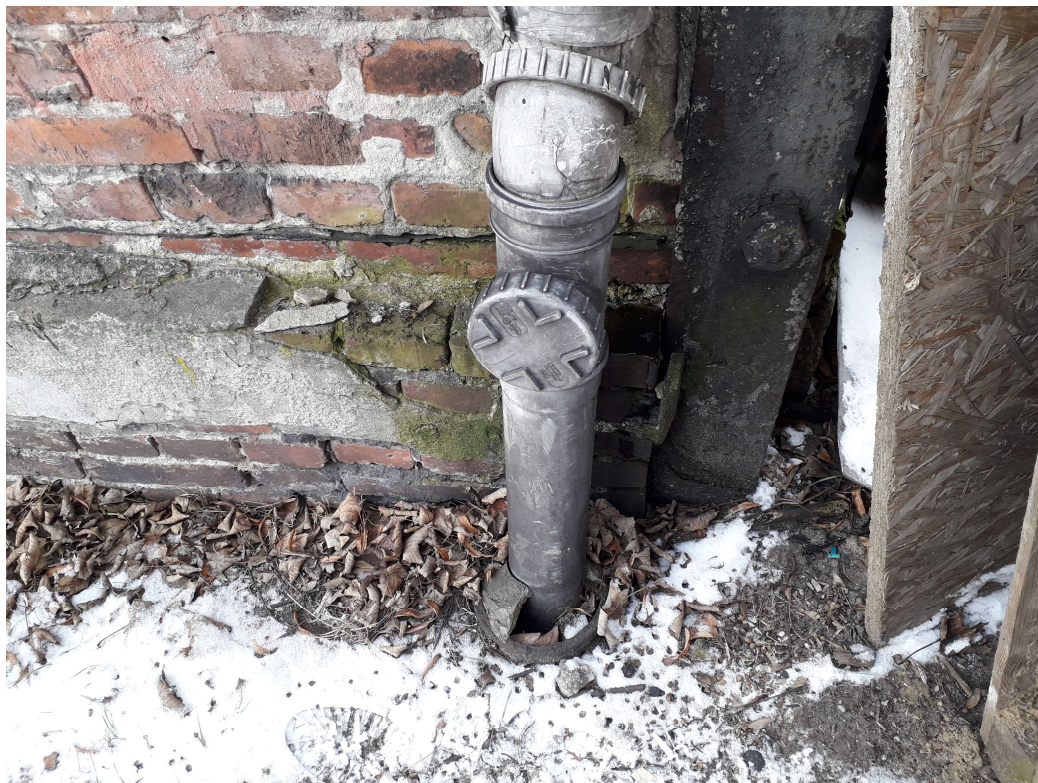
Rys. nr 7. Zawilgocenia ściany cokołowej, wyeksplotowany geiger. [1.3]
