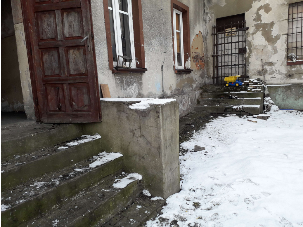
Rys. nr 8. Zniszczenia – zawilgocenie i degradacja biologiczna schodów zewnętrznych, brak odpowiedniej obróbki blacharskiej murków. [1.3]
