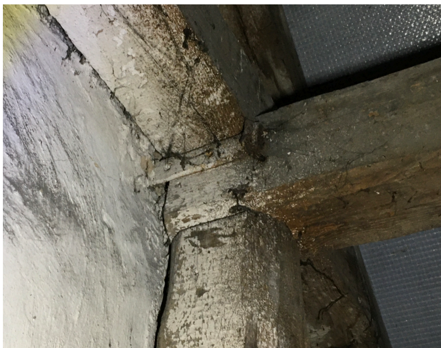
Fot. nr. 8. Kotwienie więźby dachowej w ścianie szczytowej.
