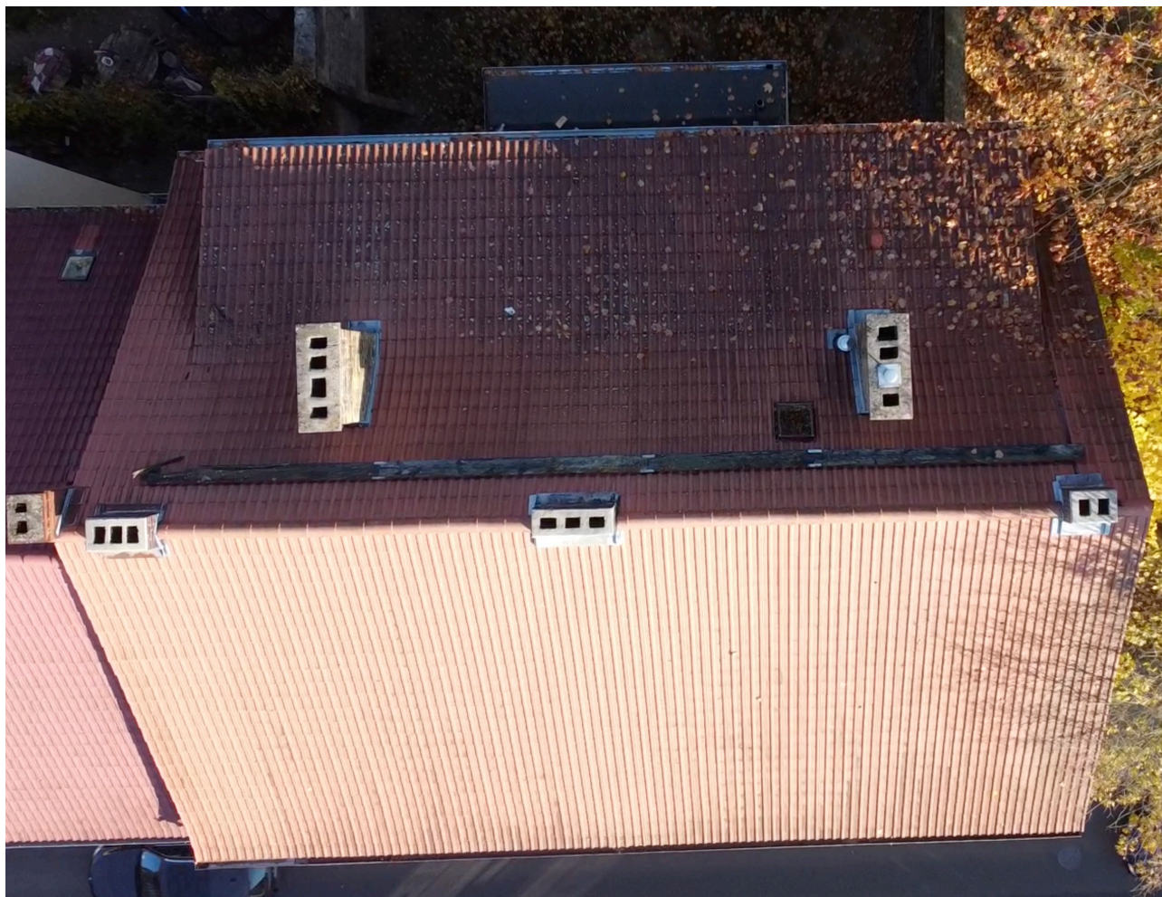
Fot. nr. 2. Dach dwuspadowy - dachówka zakładkowa pokrycie
