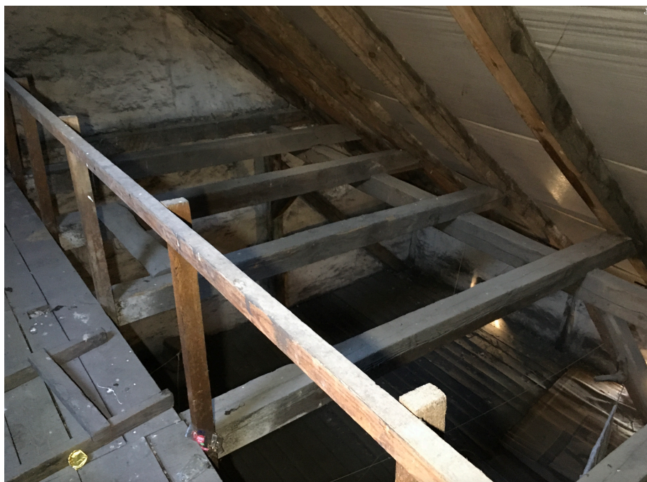
Fot. nr. 7. Fragment konstrukcji dachu
