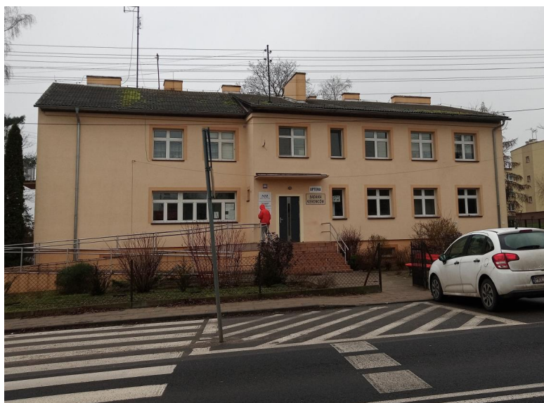
Fot. 5 Stan istniejący pokrycia dachu
