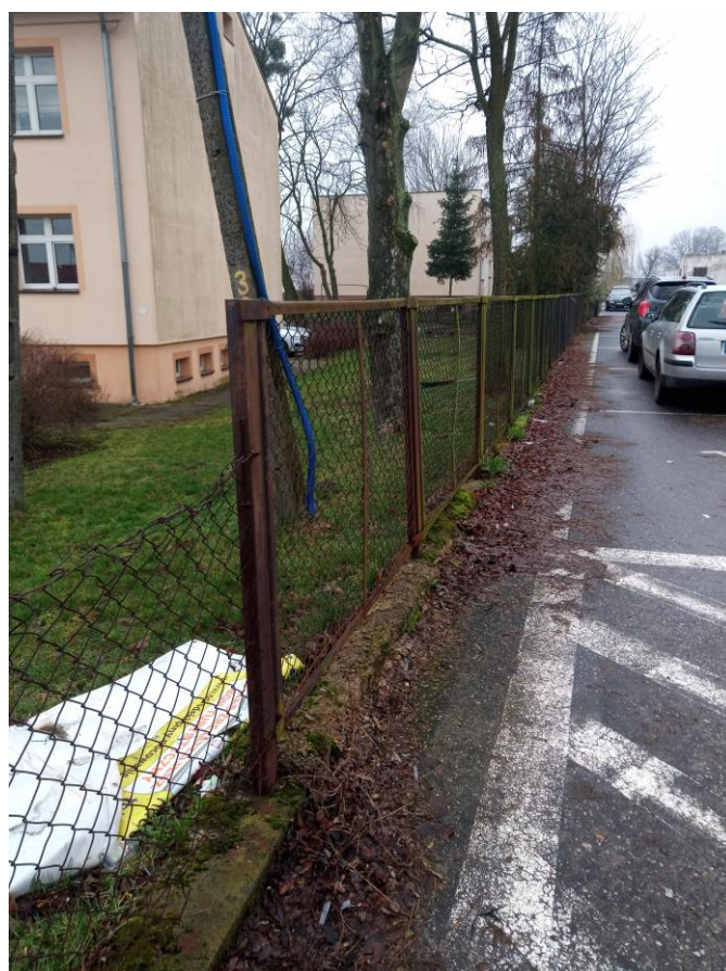
Fot. 7 Stan istniejący ogrodzenia
