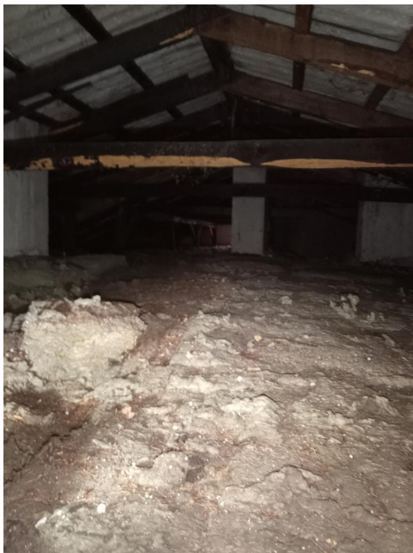
Fot. 1 Stan istniejący stropu drugiej kondygnacji
