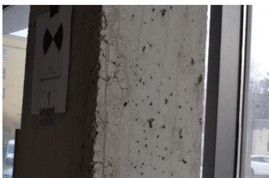
„Raki” na słupach prostokątnych części nieużytkowanej
