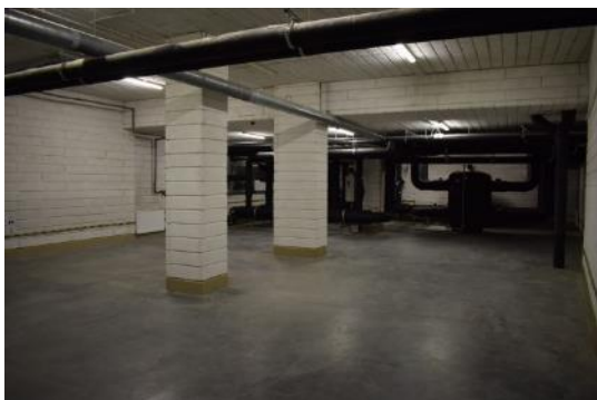
Segment E – część podziemna, widok 1
