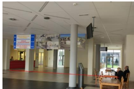
Widok ogólny Segmentu C – parter (obszar za dylatacją, górna część zdjęcia powyżej czerwonej linii)
