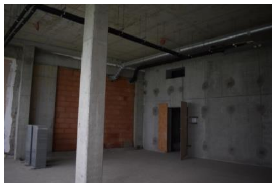
Segment E – część nadziemna, widok 2
