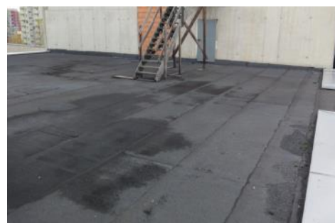
Fragment stropu nad poziomem +1 (obszar niewykonanej części modułowej) izolacja płyty stropowej papką na lepiku
