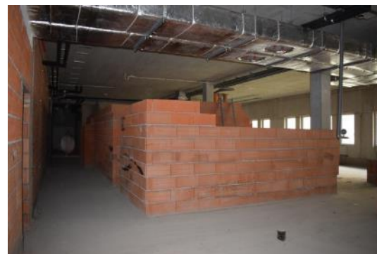
Widok ogólny na nieużytkowaną część podziemną z miejsca przecięcia osi konstrukcyjnych 8B/CB
