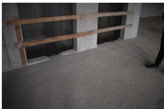
Skute fragmenty progów w ścianach trzonów windowych – poziom +3
