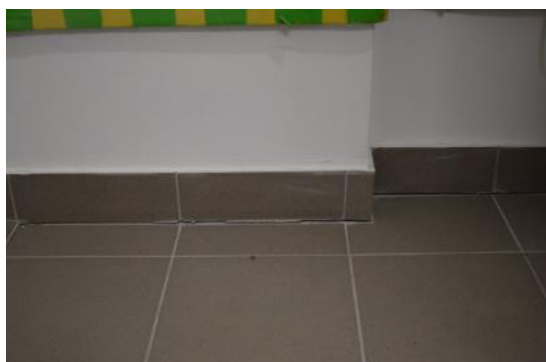
Zarysowania na styku ściany murowanej i wykończenia posadzki
