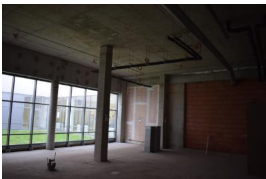
Segment E – część nadziemna, widok 1
