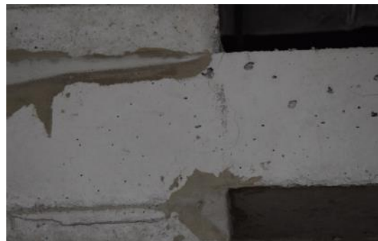
Zarysowane nadproże w miejscu połączenia ze ścianą żelbetową
