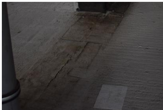
Pęknięcia izolacja na dylatacji pomiędzy Segmentami B i C za pomocą papy
