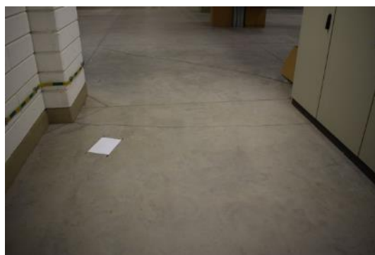
Zarysowania posadzki w piwnicy w osiach 3B-8B/CB-GB
