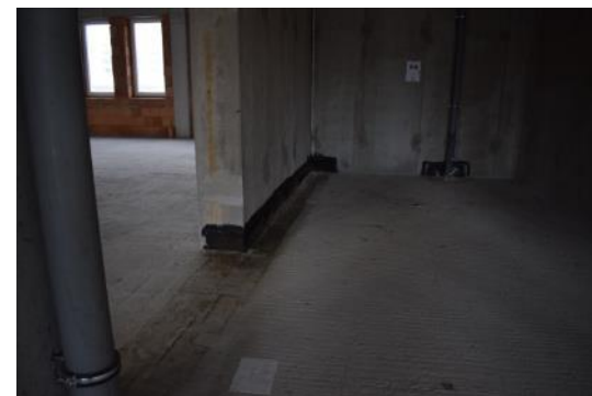
Izolacja wierzchnia dylatacji pomiędzy Segmentami B i C za pomocą papy
