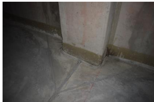
Obwodowe oddylatowanie posadzki od konstrukcji obiektu
