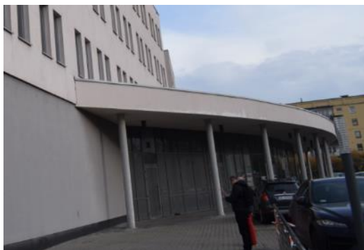
Elewacja Segmentu F – widok od strony parkingu przy Segmencie B
