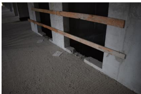
Skute fragmenty progów w ścianach trzonów windowych – poziom +1
