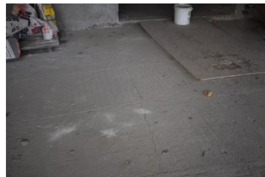
Zarysowanie płyty na gruncie wzdłuż belki spinającej
