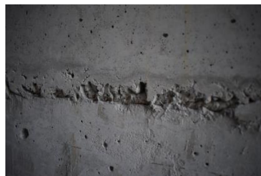
Pręt zbrojeniowy bez prawidłowego otulenia betonem (ściana w osi 4A, klatka schodowa K2)
