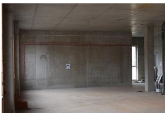
Ściana żelbetowa na poziomie +1
