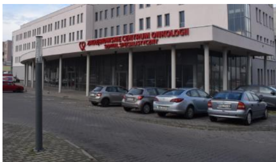
Elewacja Segmentu F – widok od strony parkingu
