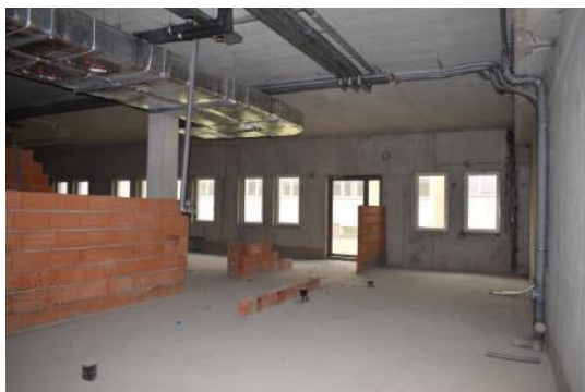
Widok ogólny na ścianę w osi 10B – poziom -1
