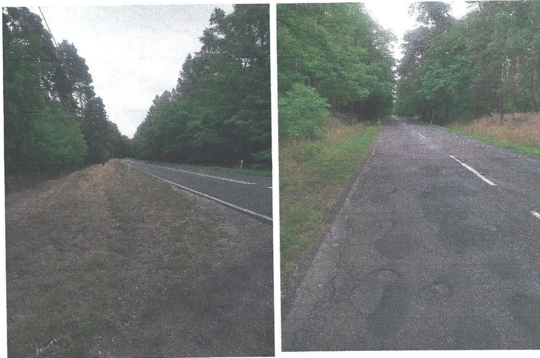
Fotografia nr 1 Istniejąca nawierzchnia
