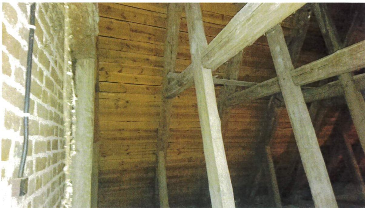
Widok konstrukcji nośnej dachu ( W części wyremontowanej )
