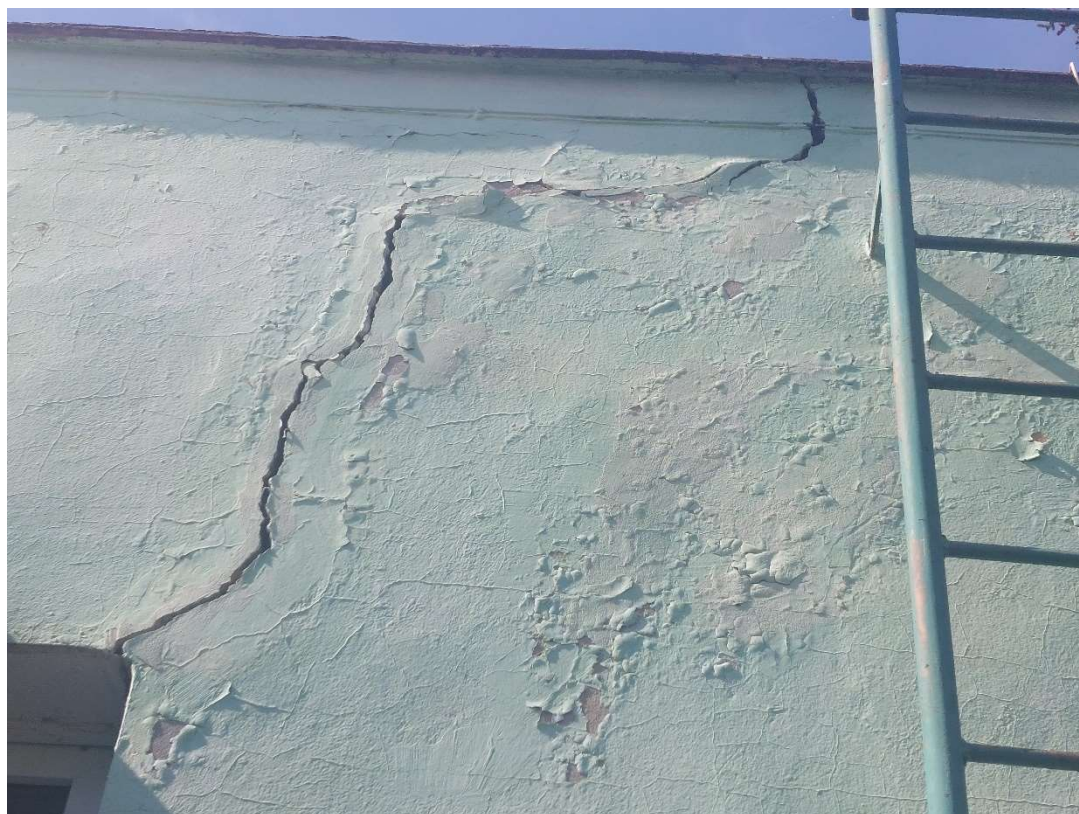
Fot. 12. Pęknięcie ściany zewnętrznej
