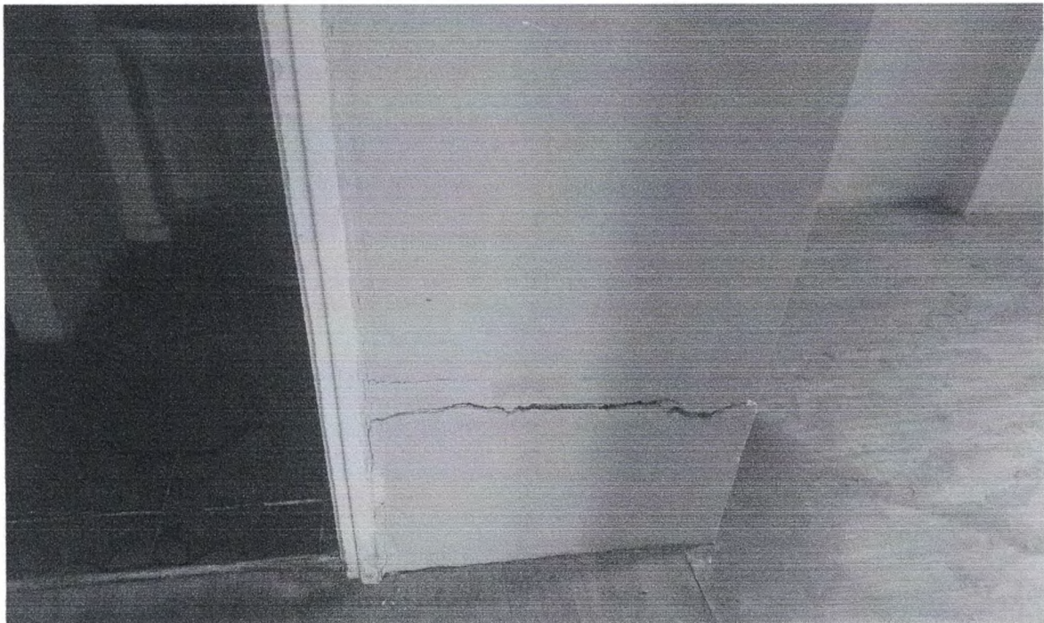
Fot. 14. Pęknięcie ściany działowej
