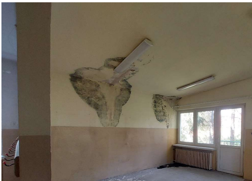
Fot. 13. Pleśń na ścianie wewnętrznej
