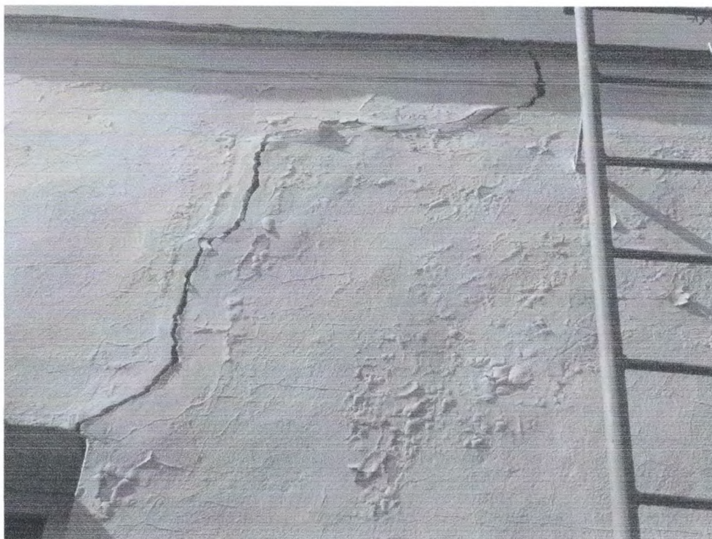
Fot. 12. Pęknięcie ściany zewnętrznej
