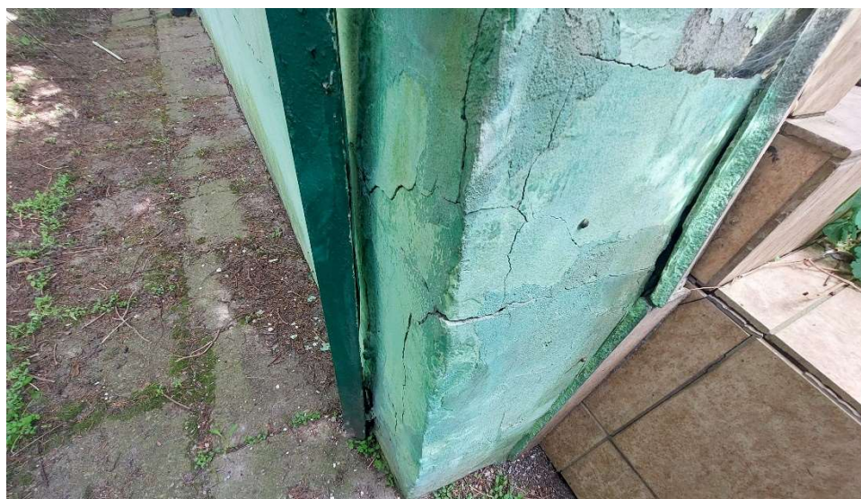
Fot. 10. Fragment uszkodzonej ściany zewnętrznej
