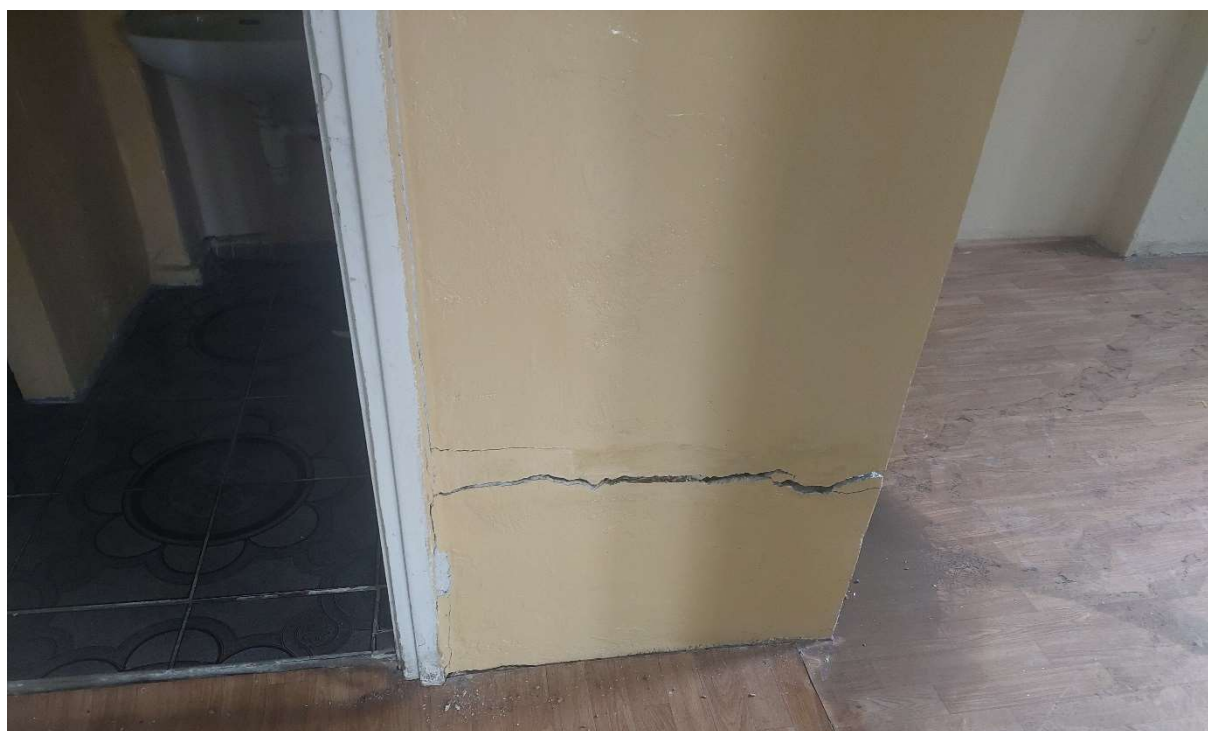
Fot. 14. Pęknięcie ściany działowej
