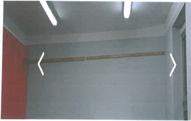
Widoczne ugięcie stropu
