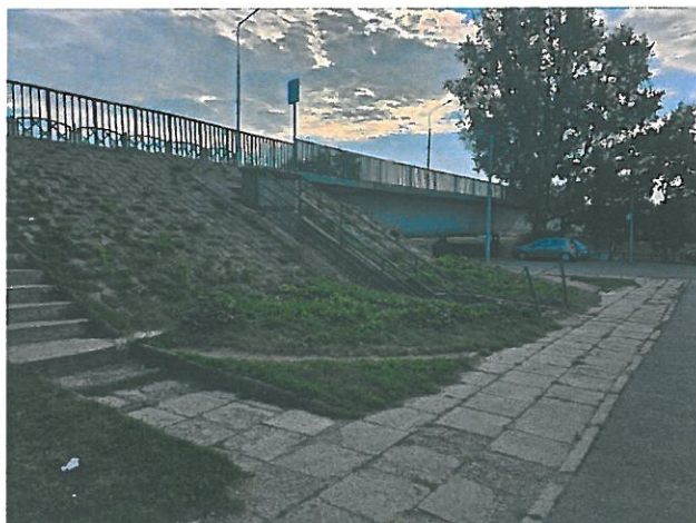
Fot.13 Przyczółki porośnięte roślinnością
