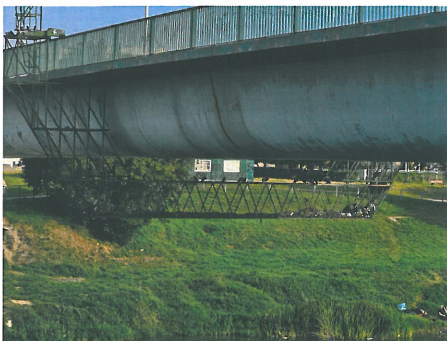
Fot. 11 Zanieczyszczenia i siedlisko gołębi w wózku rewizyjnym
