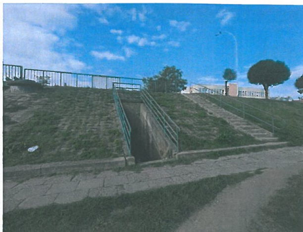
Fot.13 Przyczółki porośnięte roślinnością
