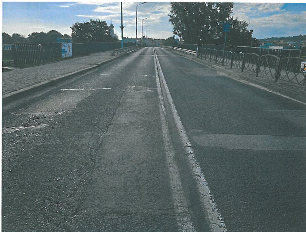
Fot.1 Widok ogólny na nawierzchnię
