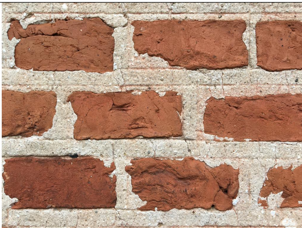
29. Kwietniewo; kościół paraf. pw. Podwyższenia Krzyża Świętego – kruchta boczna; elewacja wschodnia, odcinek środkowy (przyziemie). Lico pierwotnego wątku ceglanego; zachowany kształt spoinowań; relikty czerwonej monochromii.
