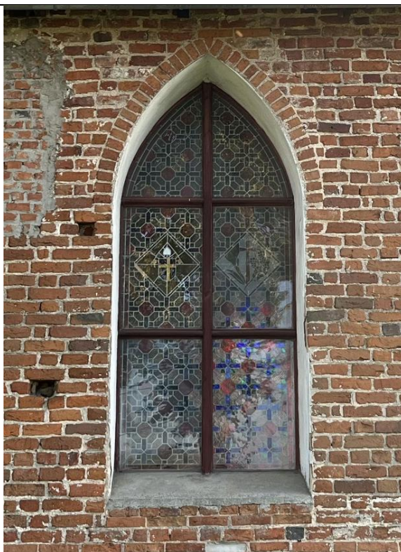
44. Kwietniewo; kościół paraf. pw. Podwyższenia Krzyża Świętego – korpus; elewacja południowa, okno (awers). Konstrukcja pokryta brązowo-bordową bejcą; współczesne podziały skrzydeł i szklenie; od wewnątrz szklenie witrażowe.
