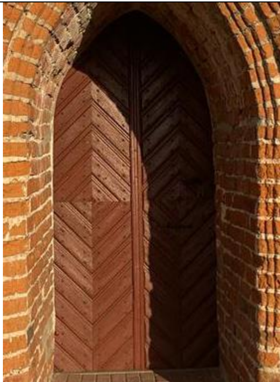
37. Kwietniewo; kościół paraf. pw. Podwyższenia Krzyża Świętego – kruchta wieżowa; elewacja zachodnia, drzwi (awers). Opierzenie i okucia pokryte farbą olejową.
