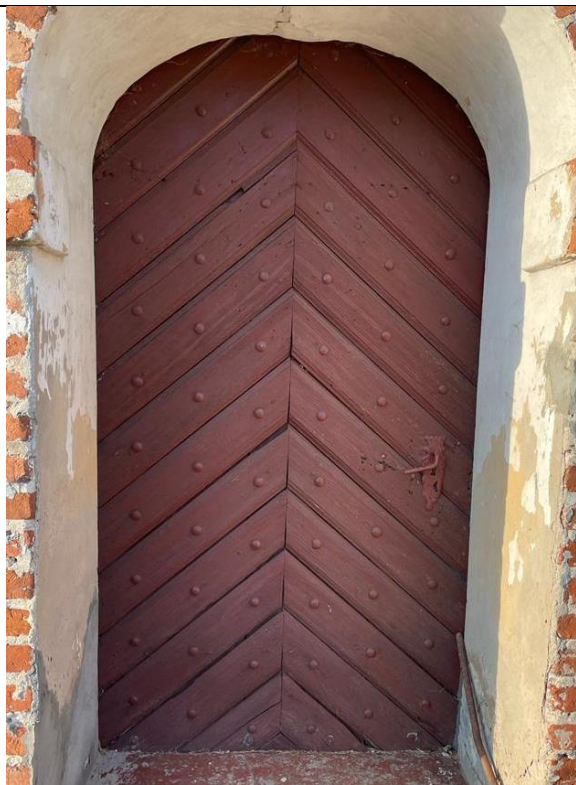
39. Kwietniewo; kościół paraf. pw. Podwyższenia Krzyża Świętego – kruchta boczna; elewacja południowa, drzwi (awers). Opierzenie i okucia pokryte farbą olejową; ubytki na krawędziach deszczutek opierzenia.
