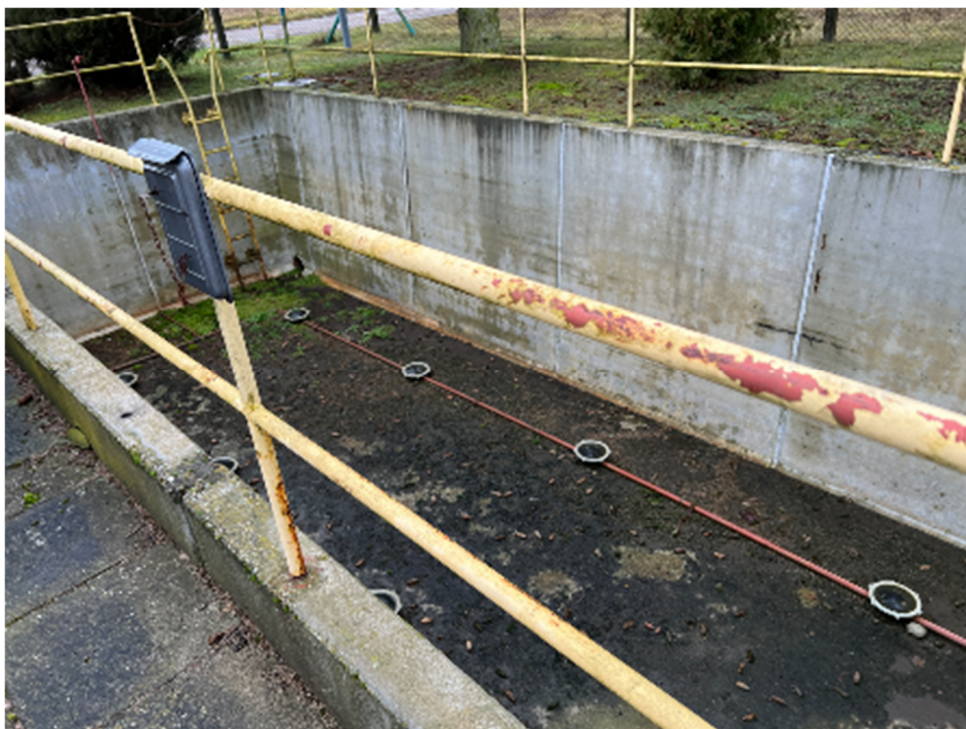
Fot.3. Zbiornik retencyjny ścieków dowożonych
