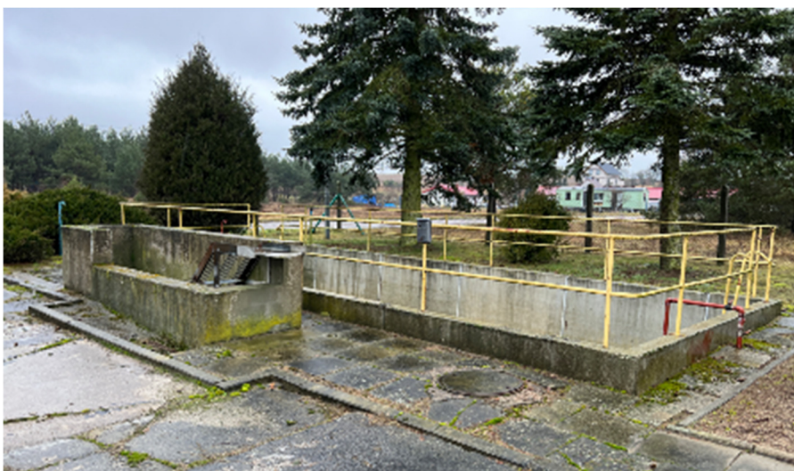
Fot.2. Zbiornik retencyjny ścieków dowożonych i komora kraty
