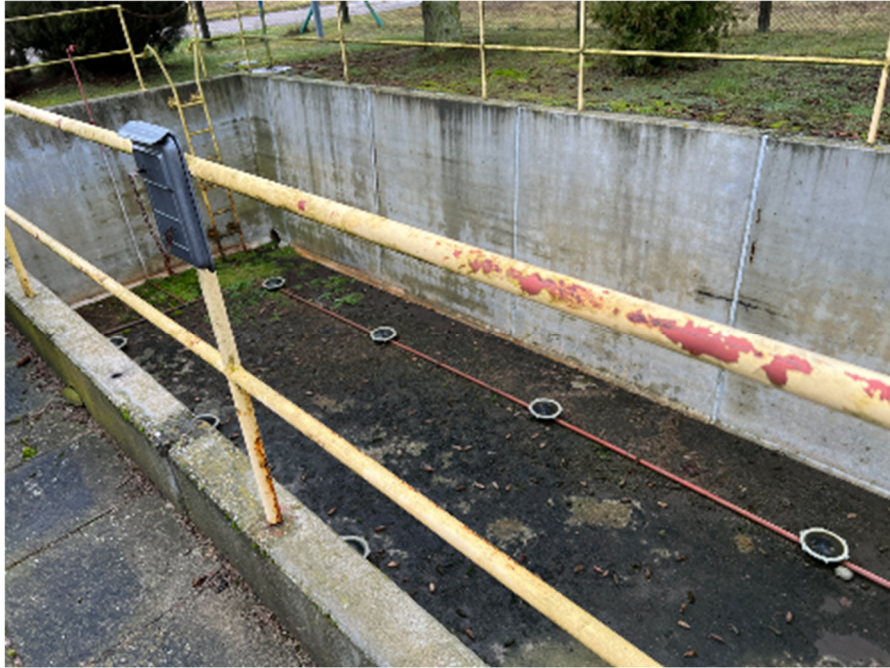
Fot.3. Zbiornik retencyjny ścieków dowożonych
