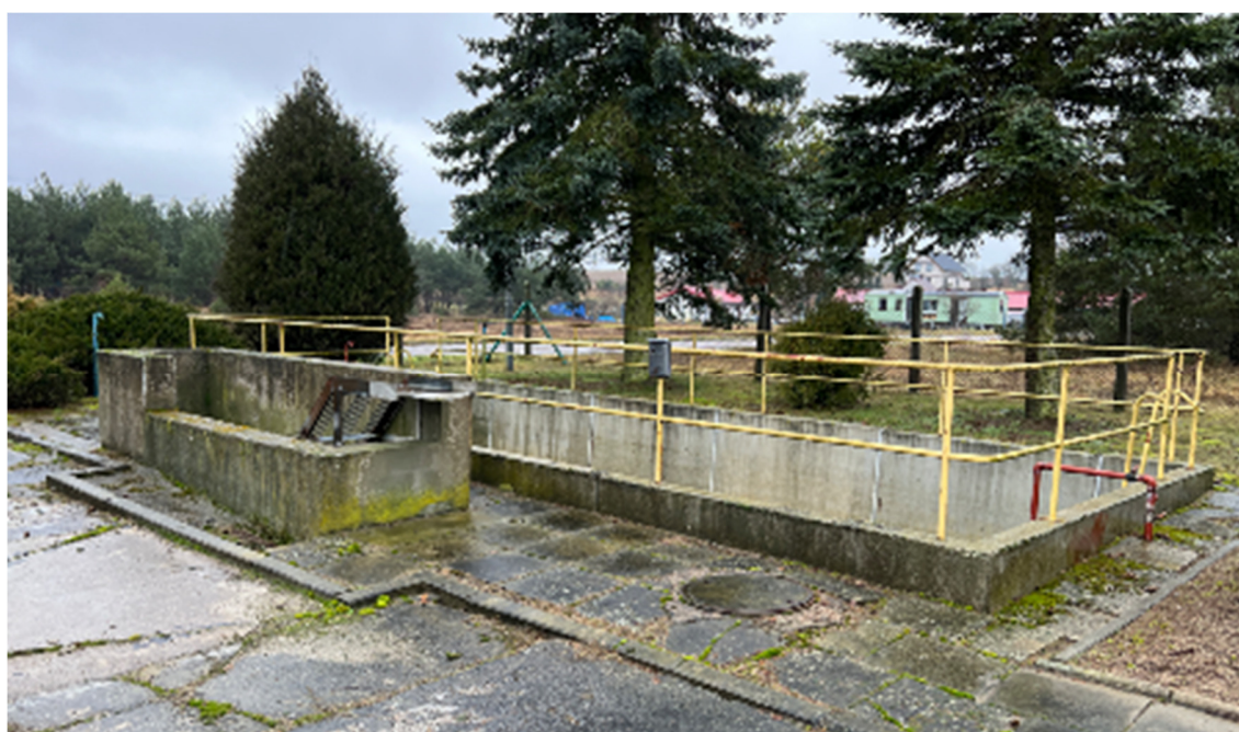
Fot.2. Zbiornik retencyjny ścieków dowożonych i komora kraty
