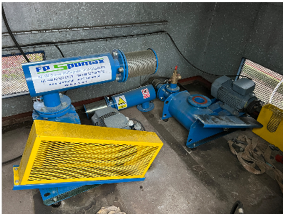
Fot.16. Stacja dmuchaw
