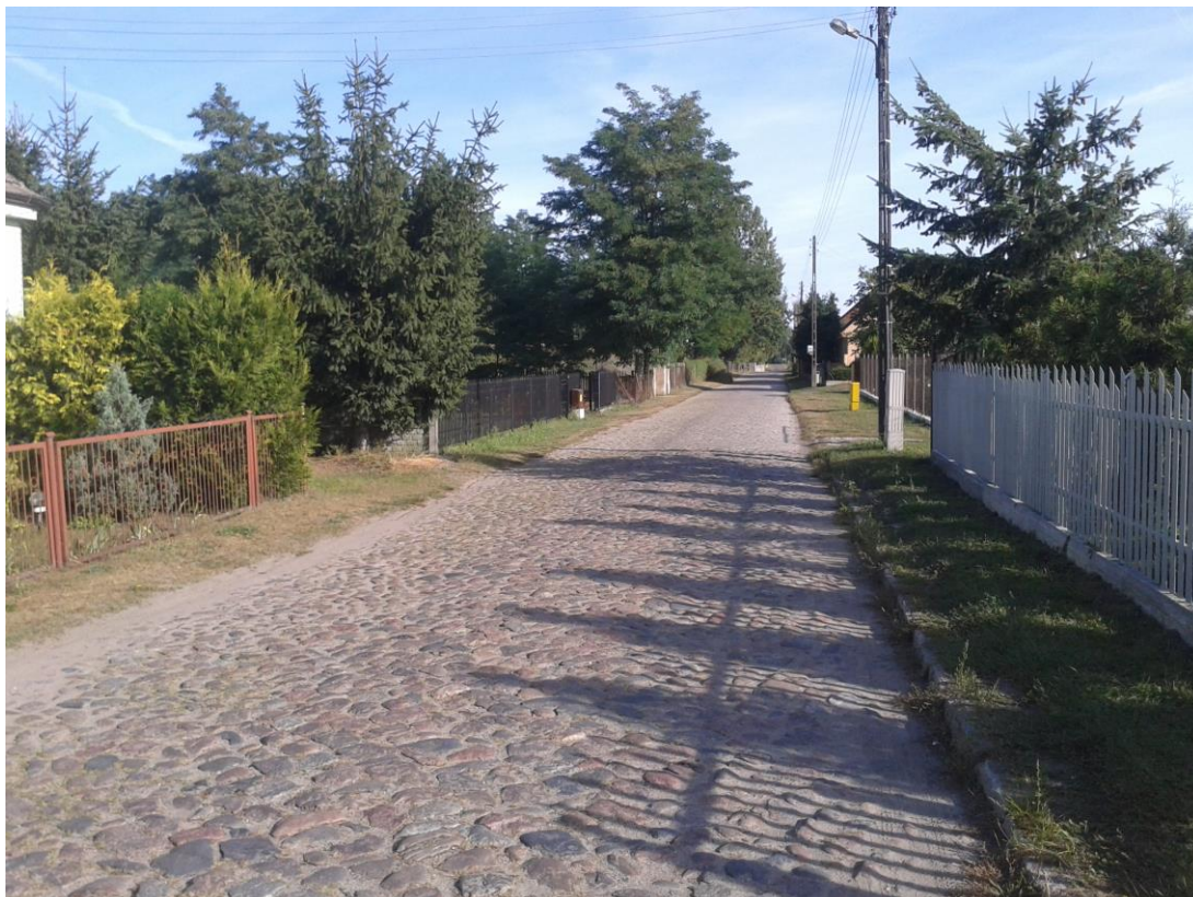
Fot. 1: Istniejący stan ul. Szkolnej (DP nr 1361Z)
