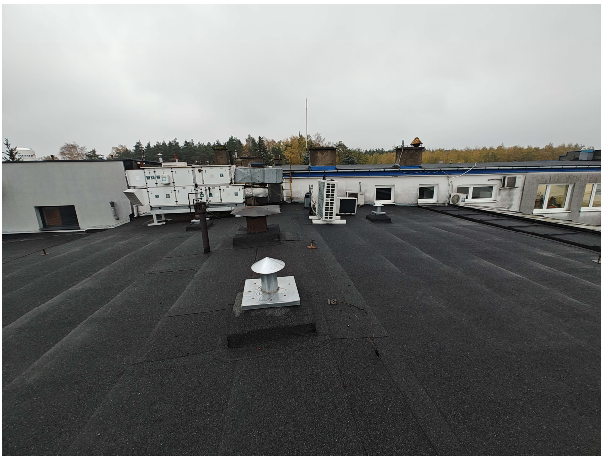
Zdjęcie 8. Fragment połaci dachowej
