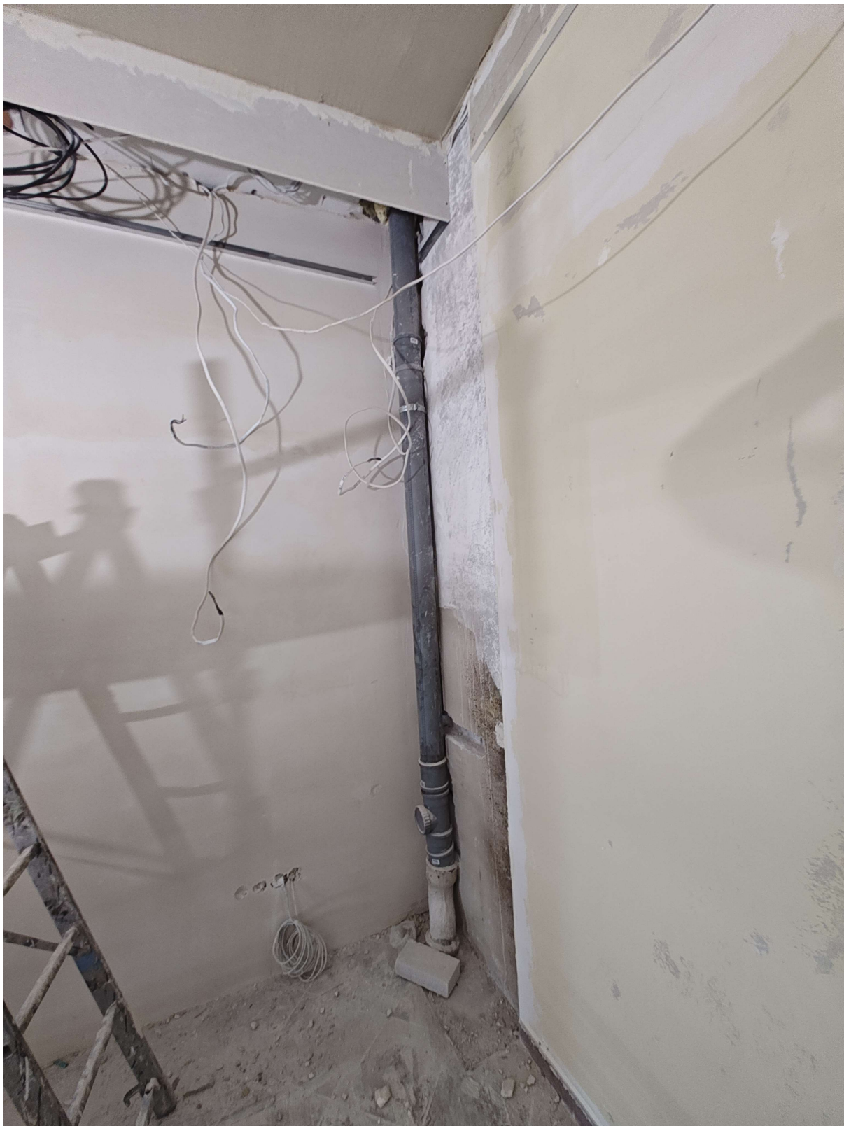
Zdjęcie 9. Istniejący pion kanalizacji sanitarnej w pomieszczeniu technicznym 01.
