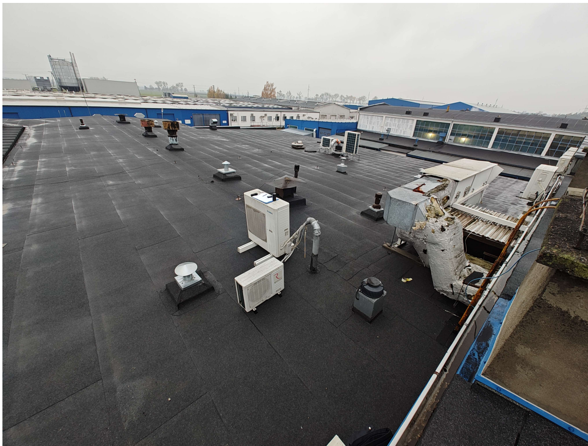
Zdjęcie 7. Fragment połaci dachowej
