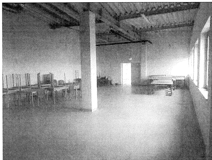
Fot. 2. Widok pomieszczenie do adaptacji w kierunku drzwi
