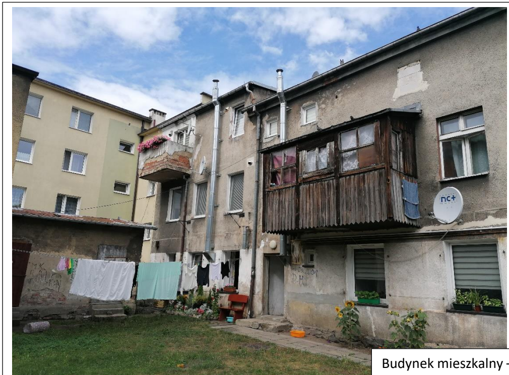
Budynek mieszkalny – widok od strony ulicy Długosza
