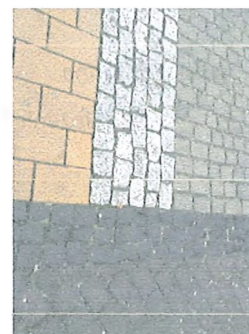
Pow. płyty rynku łączenie faktur i kolorów granitu, bazaltu i kostki betonowej.
