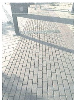
Powierzchnia traktu wiodącego do fontanny z kostki betonowej, bazaltowej oraz płyt z granitu czerwonego.
