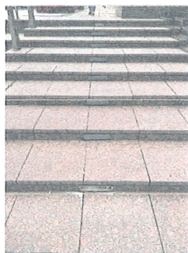
Schody i stopnie do siedzenia wykonano z płyt granitowych w kolorze czerwonym i szarym.
