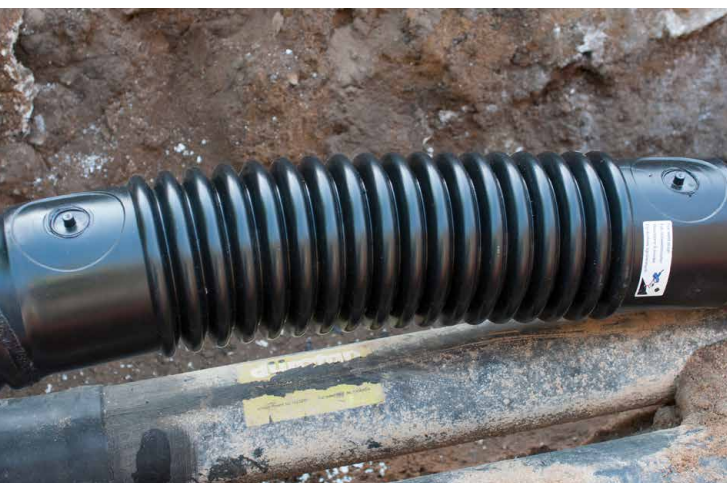
Złącze SXB-WP podczas montażu na budowie
