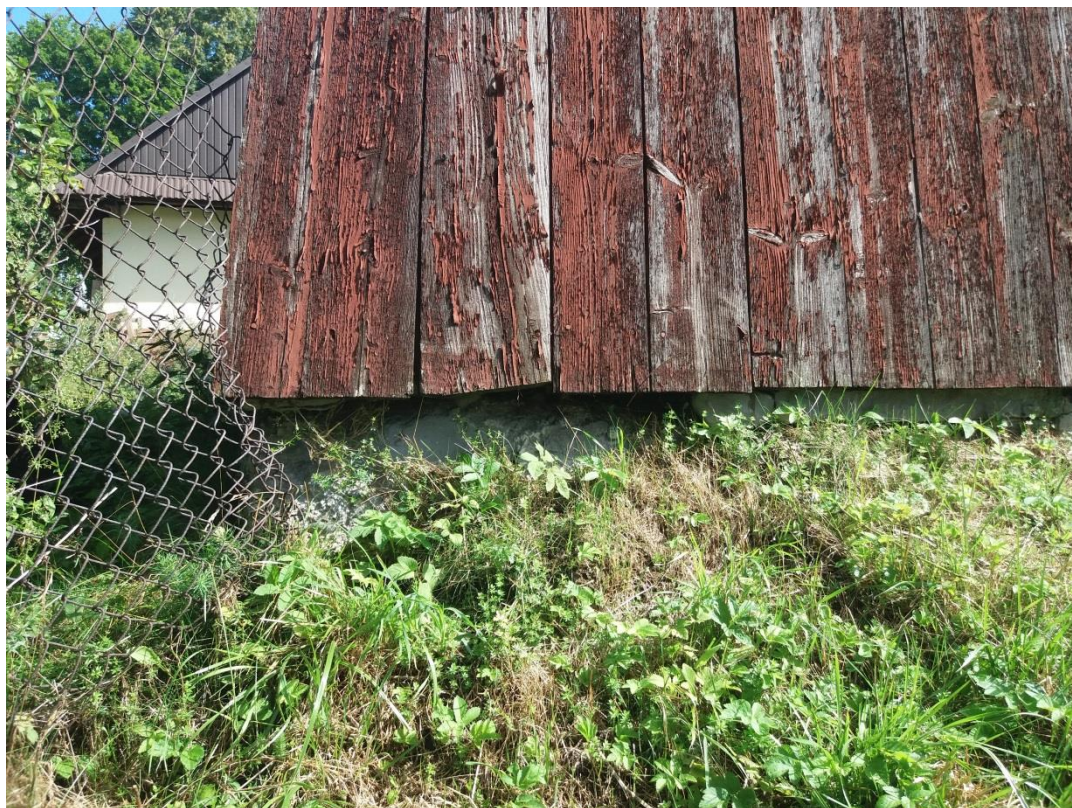
8. Zniszczenie i ubytki fundamentu. (fot. S. Kasprzak, sierpień 2023r.)
