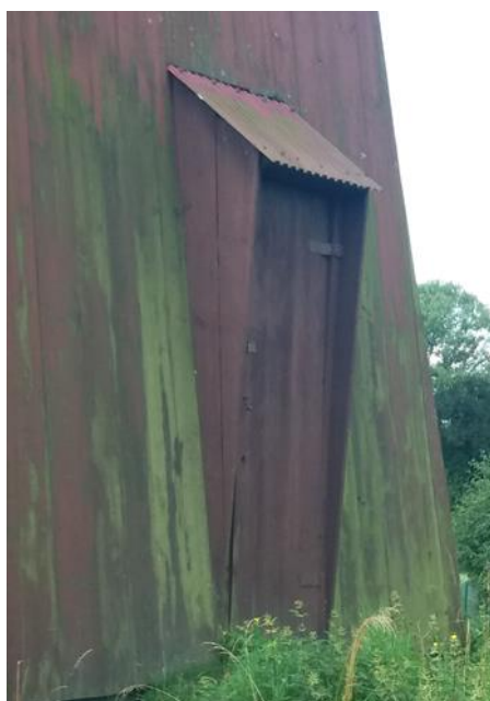
9. Porażenie deskowania przez glony. (fot. S. Kasprzak, marzec 2021r.)
