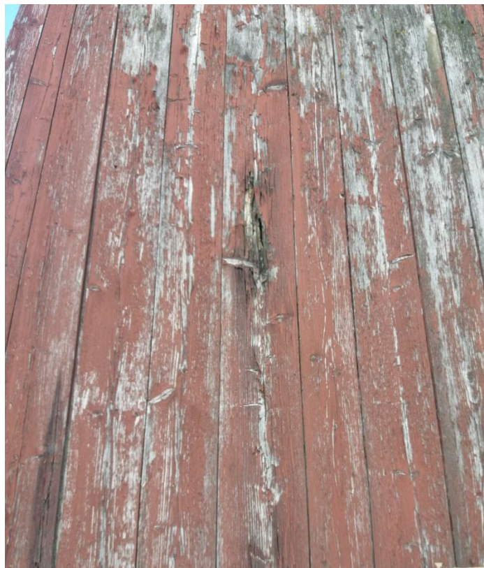
10. Zagrzybienie, spróchnienie i degradacja deskowania elewacji. (fot. S. Kasprzak, sierpień 2023r.)
