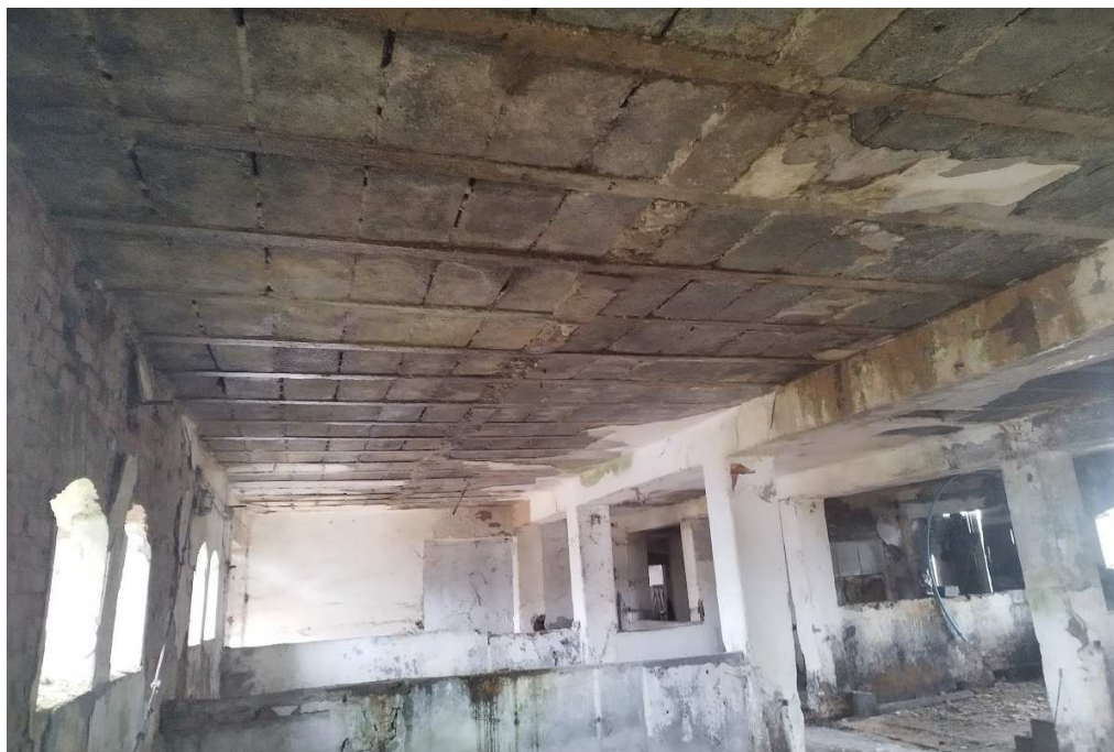
Widok konstrukcji stropu gęsto żebrowego (Przekrój A-A) Rysunek Nr 3
