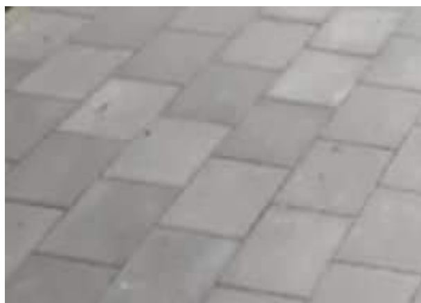
Fot.5. Układ ciosowy płytek chodnikowych
